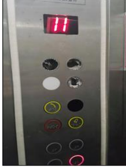
Fotoğraf 14: Hasar Gören Asansörlerden Bir Görünüm.
