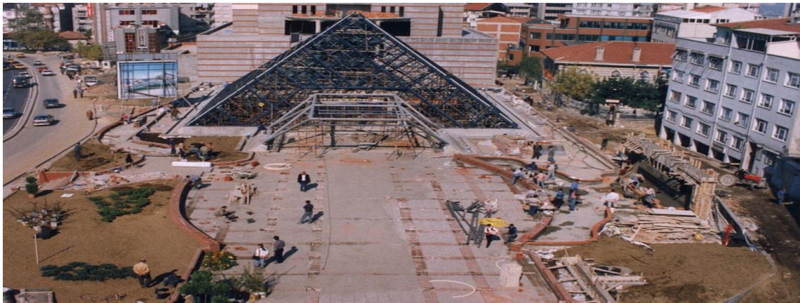
Fotoğraf 10: Zafer Meydanı Projesi Yapım Aşaması 2. 208
