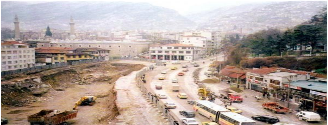
Fotoğraf 9: Zafer Meydanı Projesi Yapım Aşaması 1. 207
