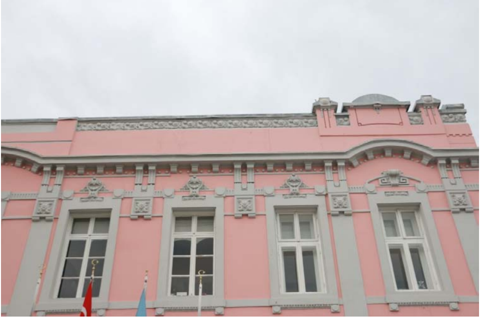
Resim 41: İzmir Ticaret Borsası Binası Üst Kat Pencere Süslemeleri (2016).
