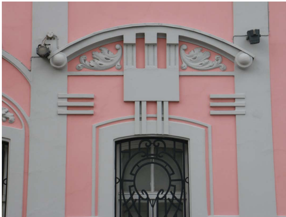
Resim 40: İzmir Ticaret Borsası Binası Pencere Silmeleri (2016).
