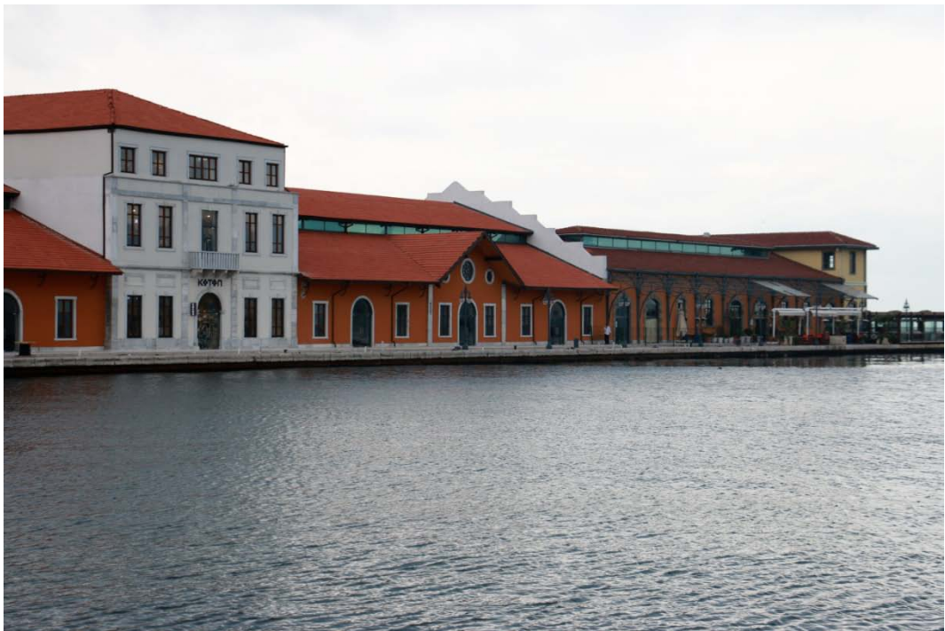
Resim 62: İzmir Gümrük Depolarına İlave Edilen Binaların Görünüşü (2016).
