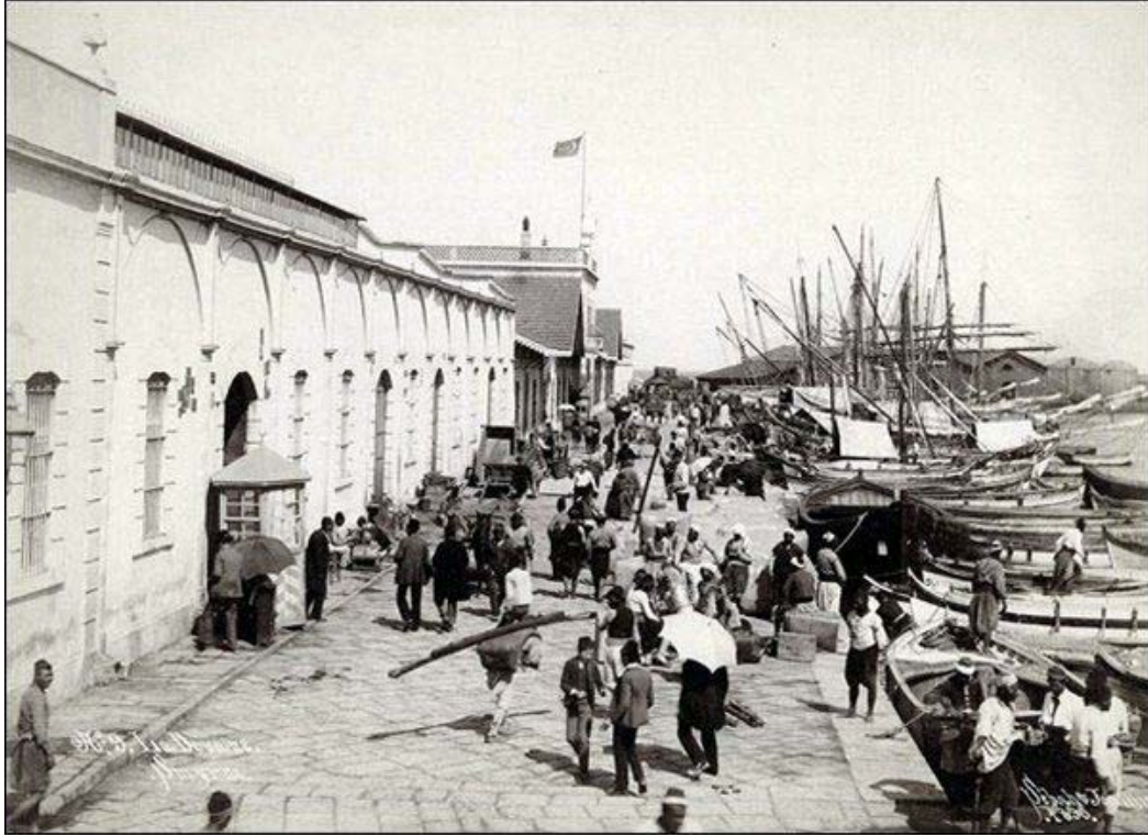
Resim 51: İzmir Gümrük Depoları Kuzey Cephesi (19. Yüzyıl) ( www.ege.gtb.gov.tr 1.12.2016).
