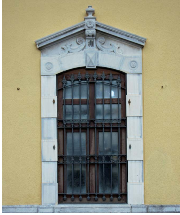
Resim 65: İzmir Gümrüğü Doğu Cephe Pencere Detay (2016).
