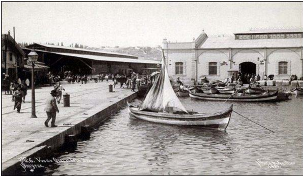
Resim 52: İzmir Gümrük Depoları Kuzey Cephesi (19. Yüzyıl) ( www.levantineheritage.com 1.12.2016).
