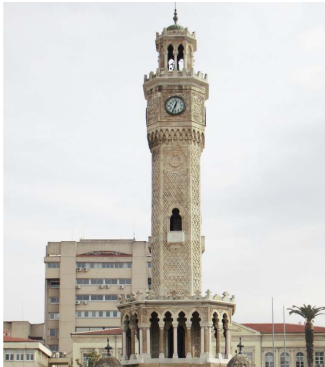
Resim 24: İzmir Saat Kulesi Balkon Açılan Kuzey Cepheden Görünüş (2015).
