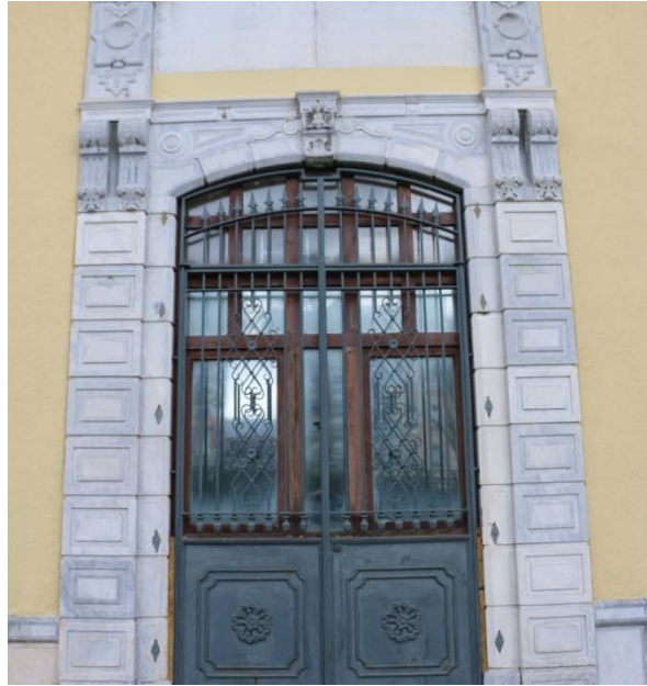
Resim 63: İzmir Gümrüğü Doğu Cepheye Açılan Kapı (2016).
