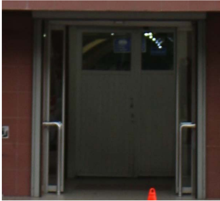
Resim 83: İzmir Gureba-i Müslim'in Hastanesi Kuzey Cephe Bodrum Kat Kapısı (2016).
