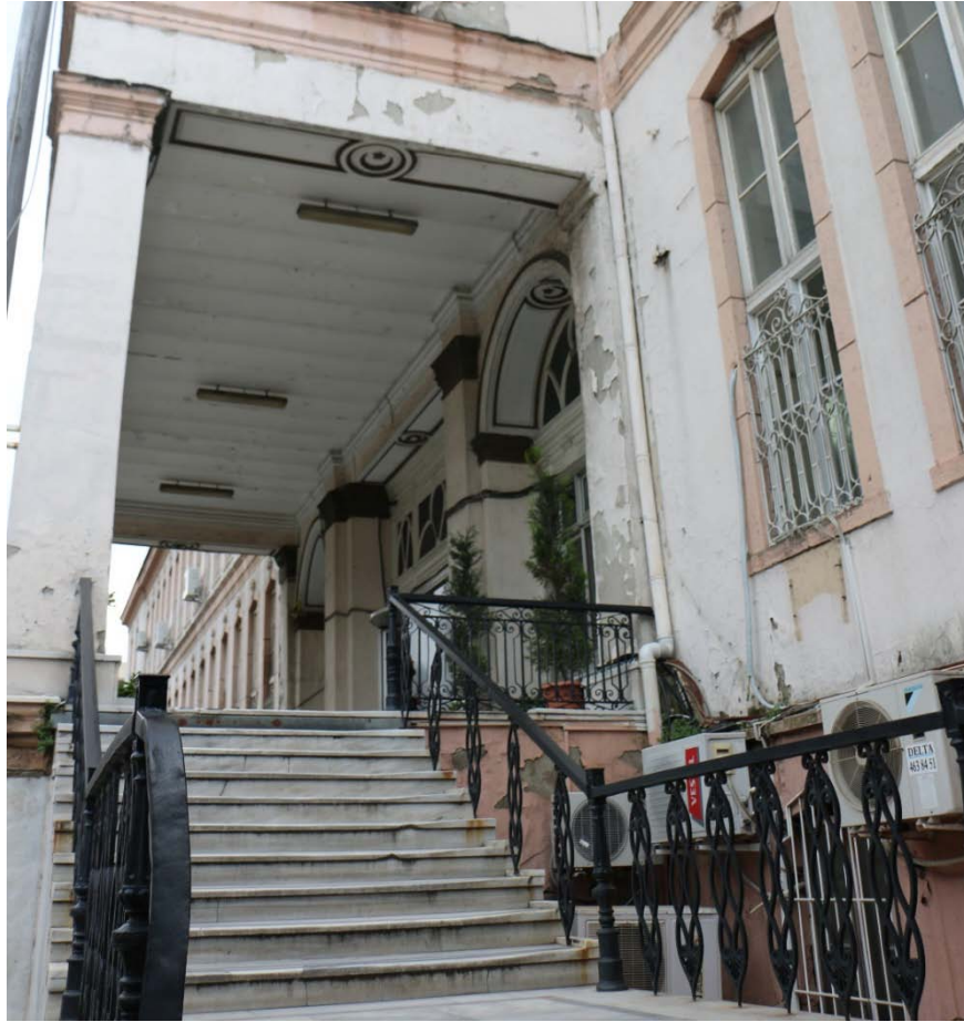
Resim 73: İzmir Gureba-i Müslim'in Hastanesi Kuzey Cephe Ana Giriş Bölümü (2016).
