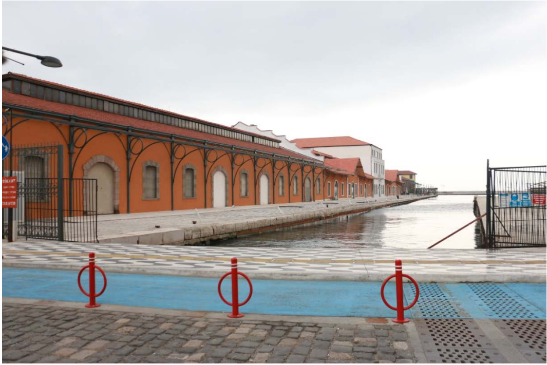
Resim 61: İzmir Gümrük Depoları Kuzey'den Güney'e Görünüş (2016).
