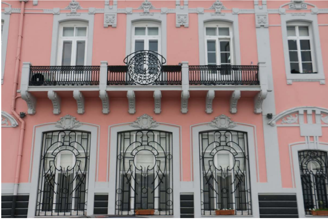
Resim 43: İzmir Ticaret Borsası Binası Batı Cephesindeki Balkon (2016).
