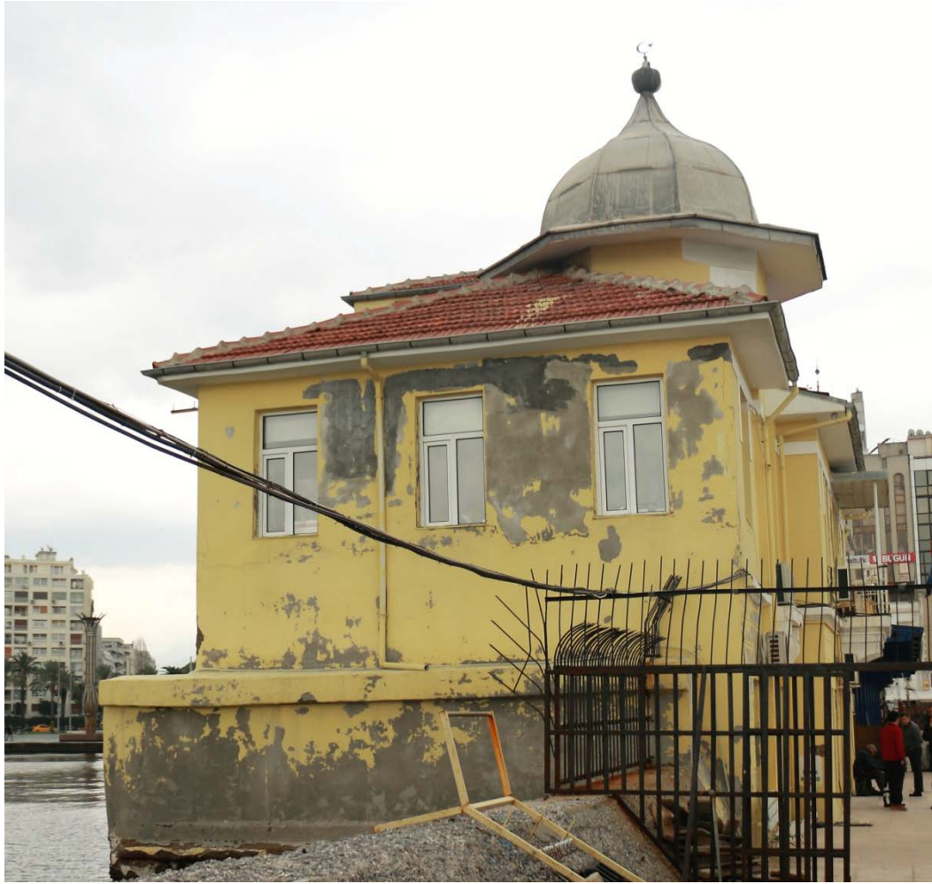
Resim 135: Pasaport İskelesi Karantina Binası Batı Cephe (2016).
