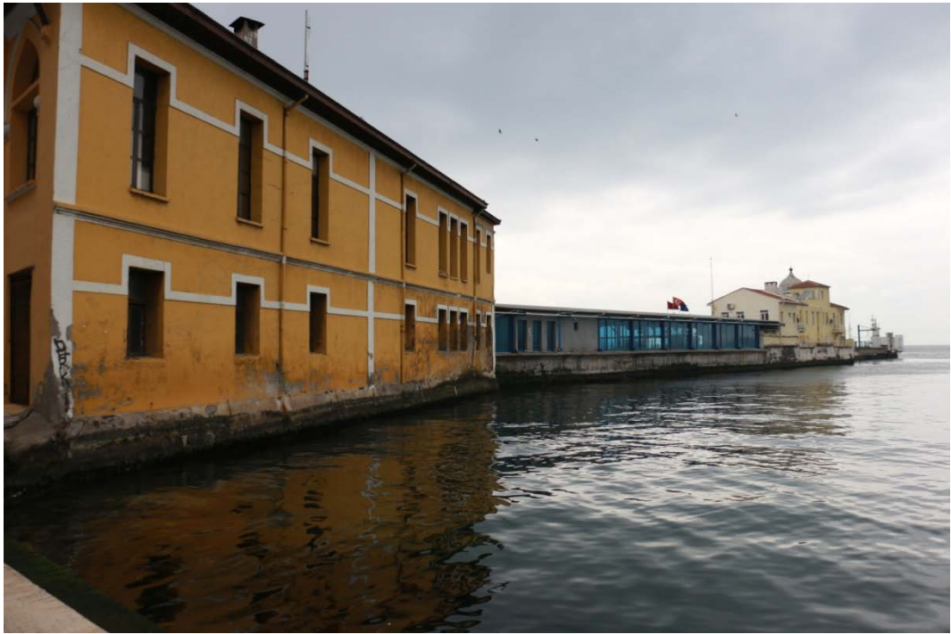
Resim 130: Pasaport İskelesi Kuzey Cephesi (2016).
