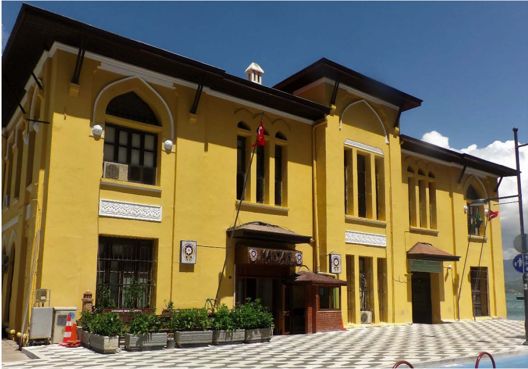
Resim 127: Pasaport İskelesi Doğu Cephe (2016).
