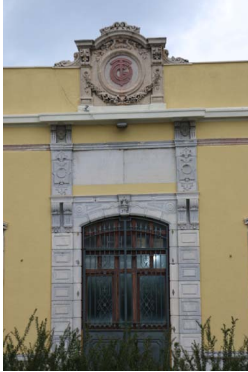
Resim 66: İzmir Gümrüğü Doğu Cephe Orta Kapı (2016).
