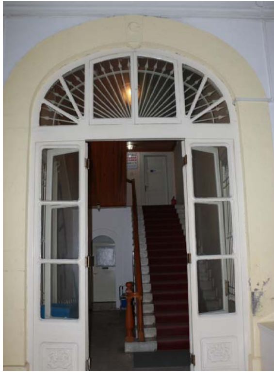
Resim 33: İzmir Eski Belediye Binası Birinci Kat Merdivenlerine Açılan Kapı (2015).
