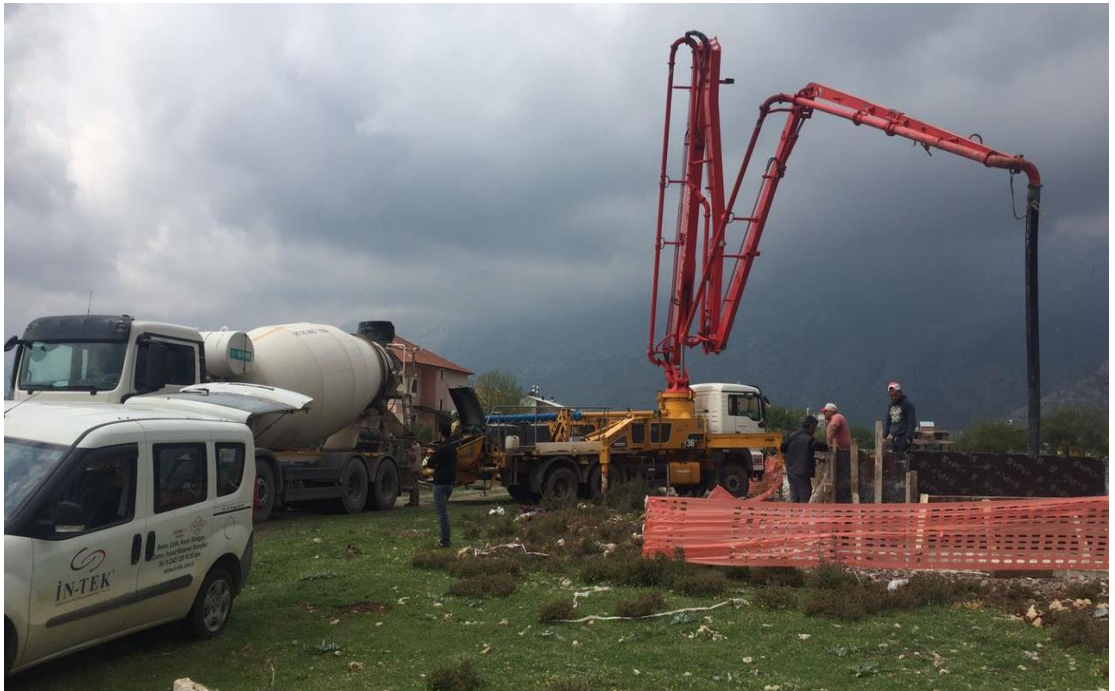
Şekil 2.7: Hazır Beton Dökümü
