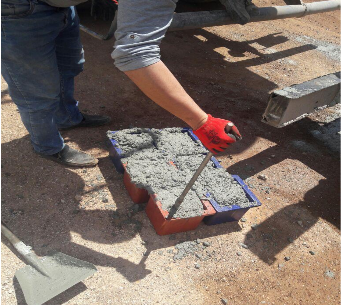
Şekil 2.12: Hazır Beton Numune Alınması
