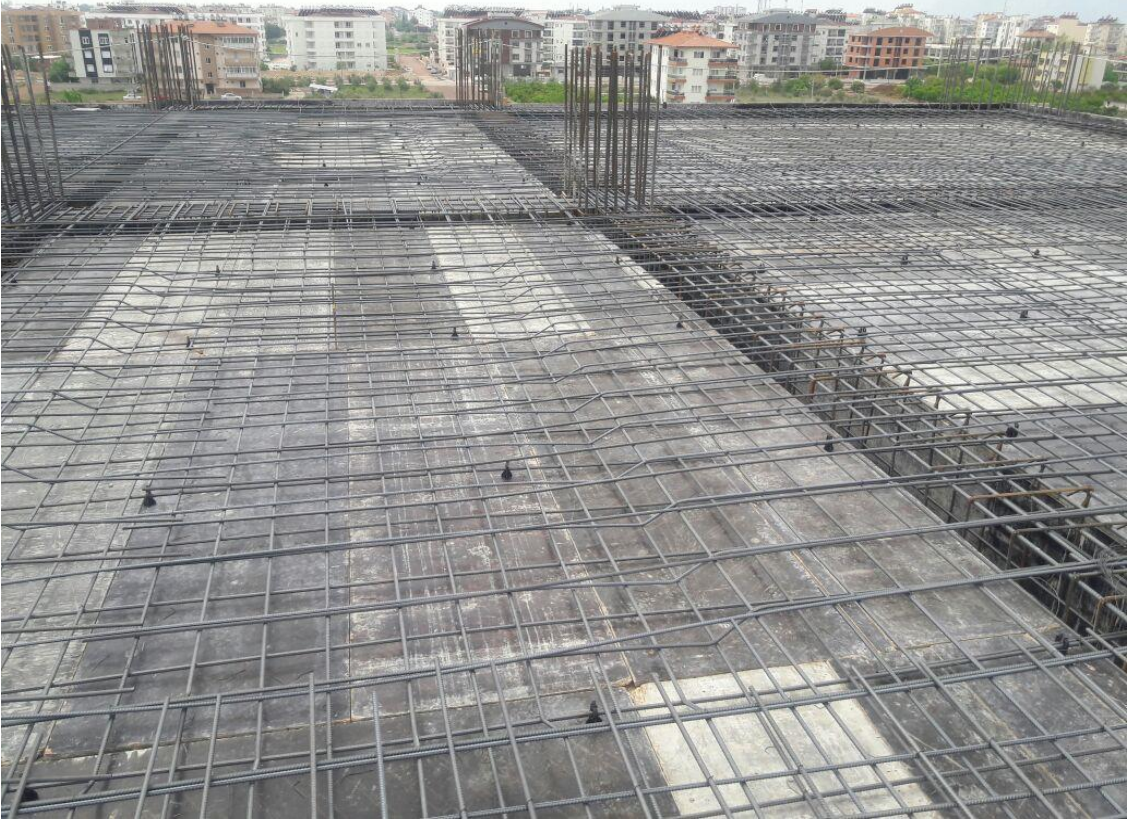
Şekil 2.4: Beton Döküm Öncesi Hazırlık
