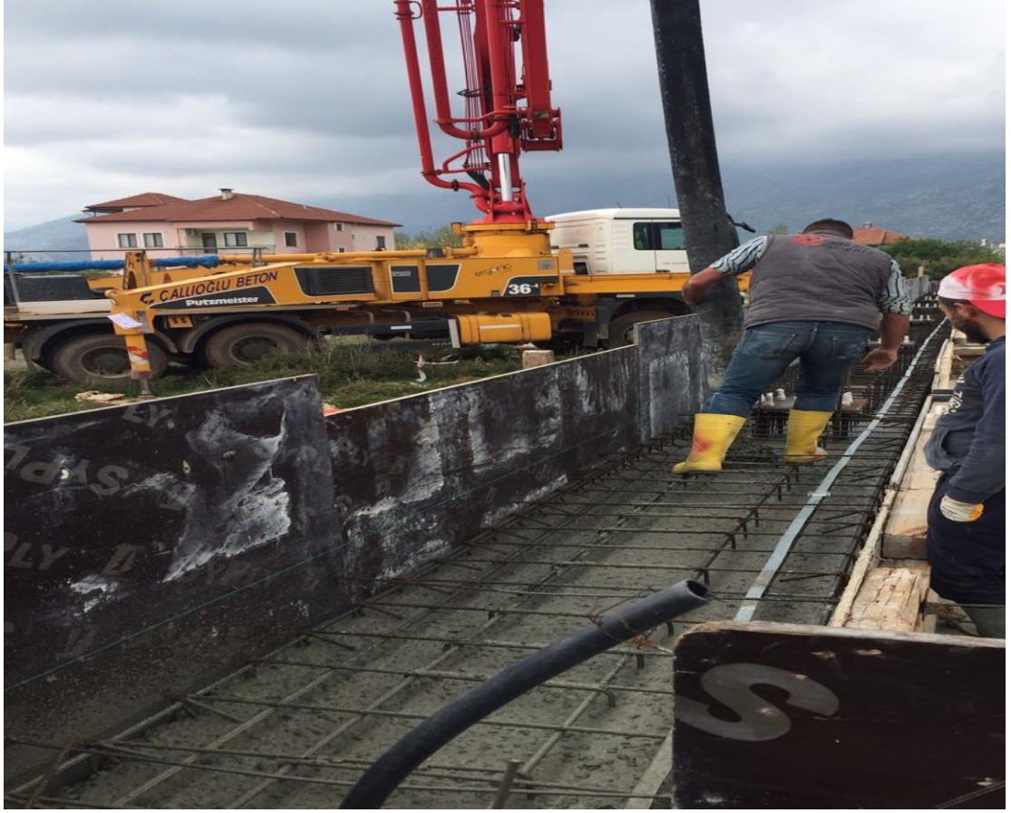
Şekil 2.6: Hazır Beton Dökümü
