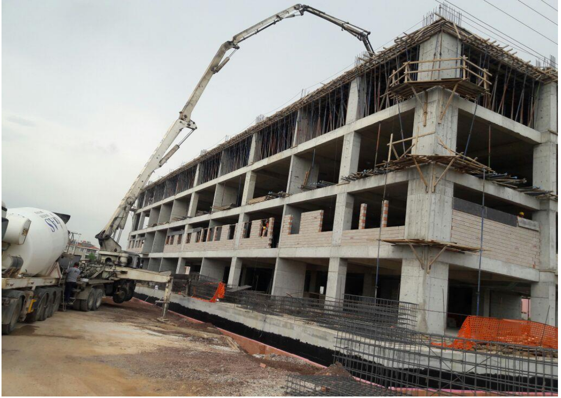
Şekil 2.5: Beton Döküm Öncesi Hazırlık
