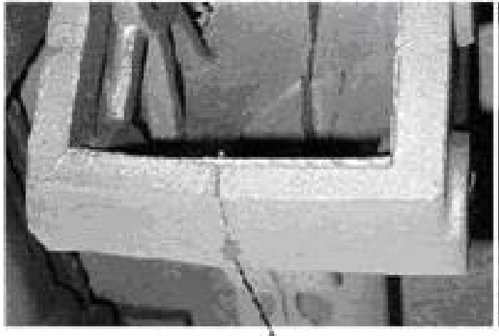
Şekil 4.9: Kaçıklık hatası (Harran Üniversitesi 2016).
