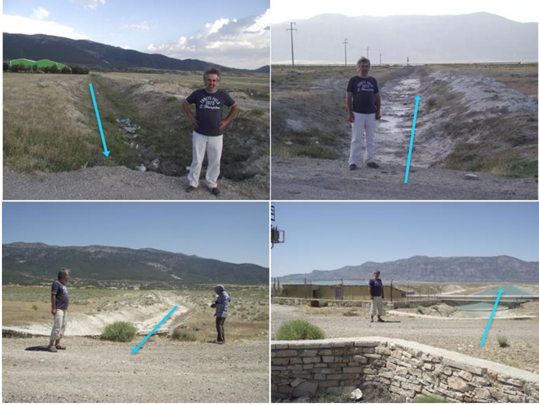
Şekil C. 2: Gemiş çevresindeki yüzeysel akışların Acıgöl'e iletiği kanallar.
