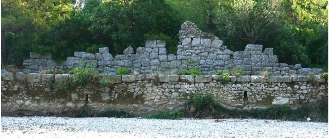
Şekil 3. Hellenistik sur duvarı (Kazı arşivi)
