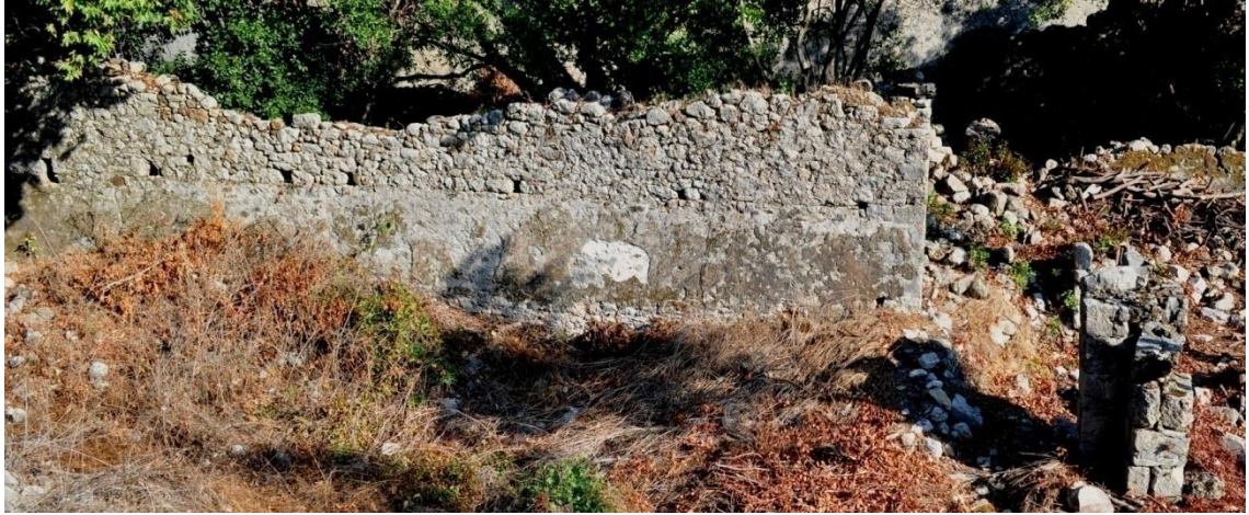
Şekil 25. Kilise kuzey duvar ve T kesitli kuzey paye (Öztaşkın. 2013: Şek. 50)
