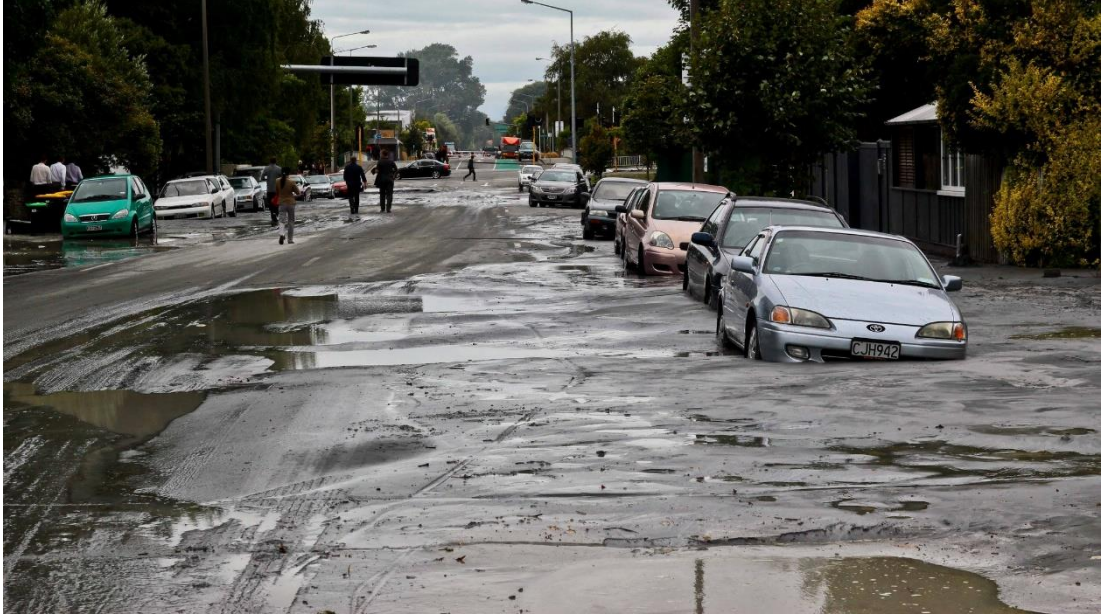
Şekil 5.1: 2011 Christchurch depremi sonrası Kilmore Caddesinde sivilaşma (Trafford, 2011).
