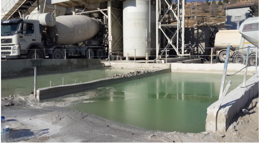
Şekil 3.2: 2 gözlü çökeltme havuzu.
