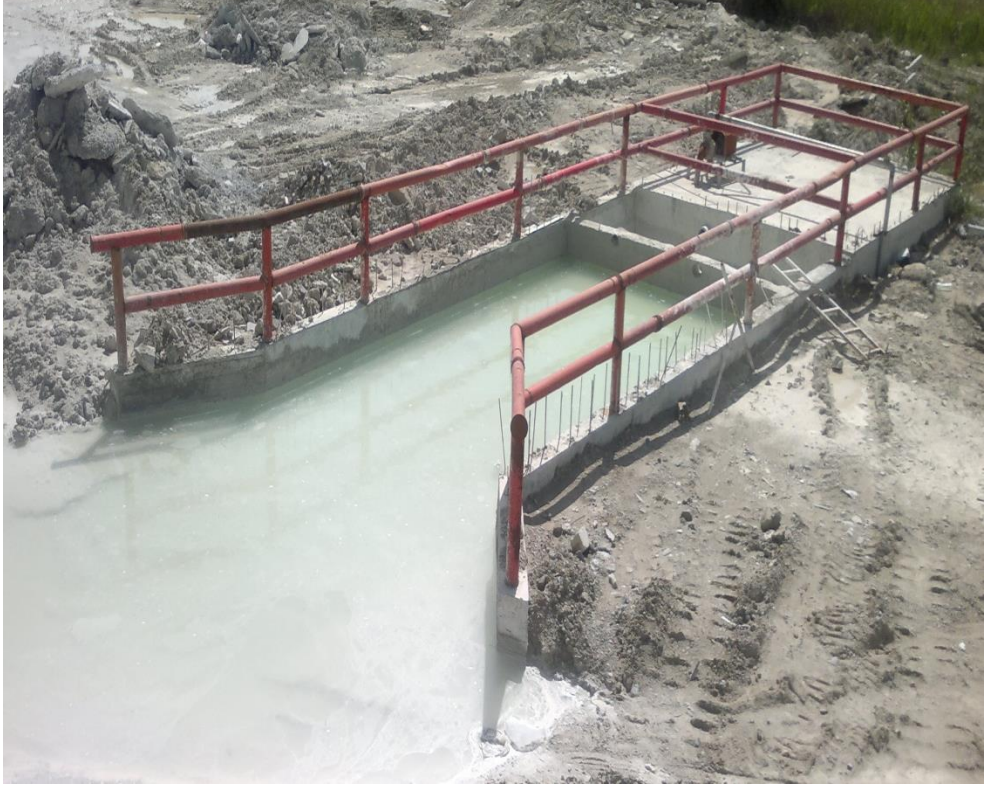
Şekil 3.1: 3 gözlü çökeltme havuzu.
