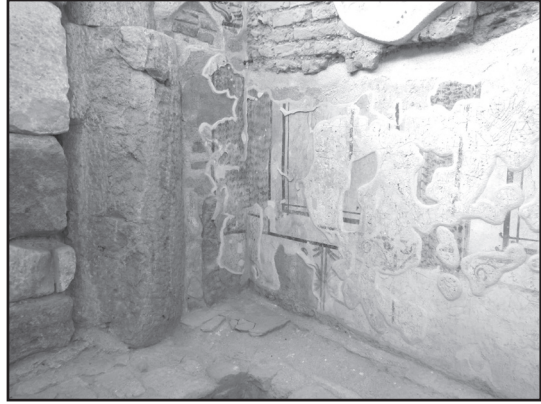
Resim 11: Taberna 2, restorasyon sonrası.
