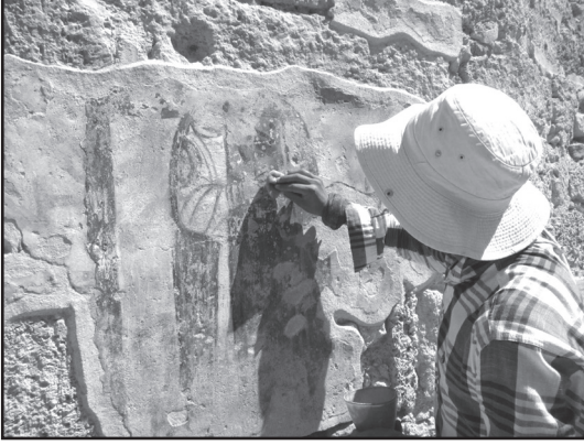
Resim 10: Fresk yüzeyinde oluşan tuzlanma ve kirlenmenin temizlenmesi.
