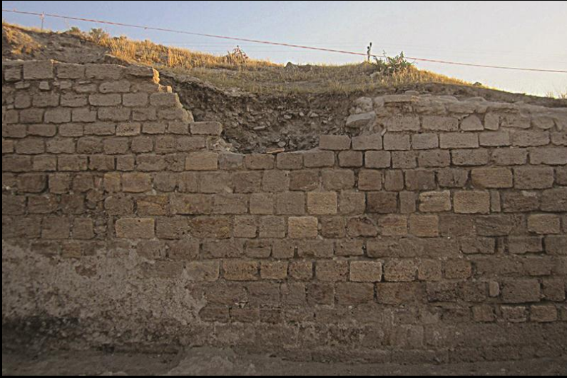
Resim 10 A: Devlet Agorası / kutsal alan duvar restorasyonu öncesi.
