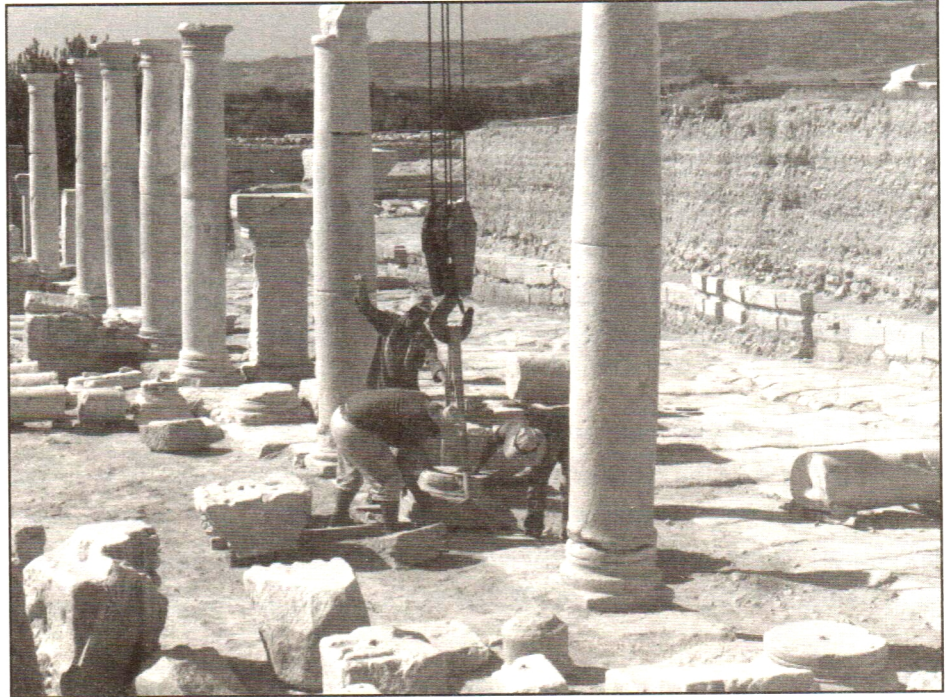
Resim 14: Hierapolis Caddesi restorasyon çalışması.
