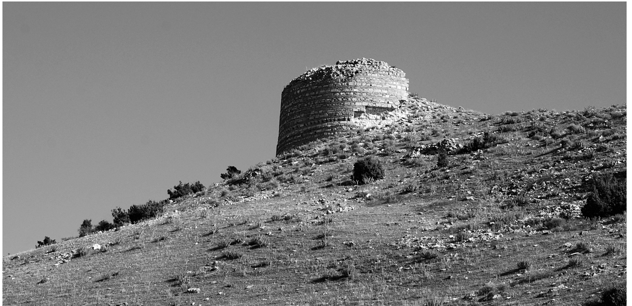
Fig. 4 K1 No.lu Kule, güneyden
