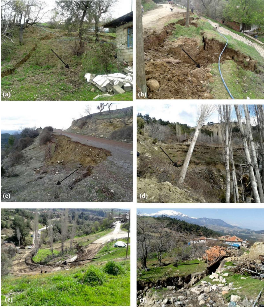
Şekil 1.1: Denizli ilinde meydana gelen heyelanlardan örnek görüntüler. a) ve b) Kale İlçesi Çakırbağ Mahallesi, c) ve d) Çameli İlçesi Kolak Mahallesi, e) Kale İlçesi Ortaköy Mahallesi ve f) Honaz İlçesi Akbaş Mahallesi.
