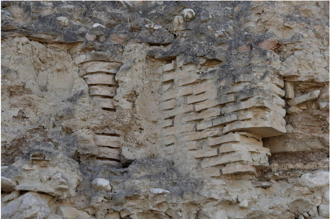
Fig.86b: I. Derece Sit Alanı Dışında Yenicekent Mahallesi Sınırları İçindeki Su Yapısında Yer Alan Tuğla Sırası.
