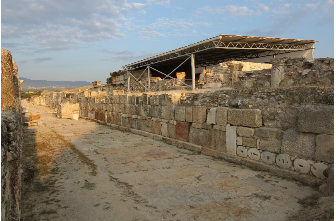
Fig.22b: Erken Bizans Güney Surunun Güney Cephesi.
