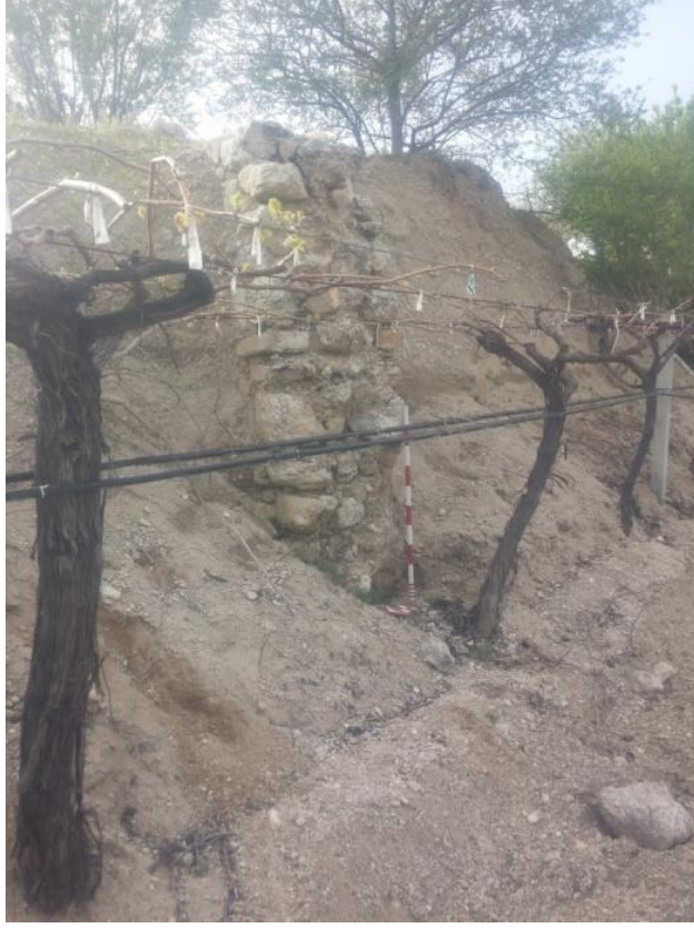
Fig.81b: Çayınkaşı Mevkisinde Bulunan Dış Çevre Surunun Batı Kesiti.
