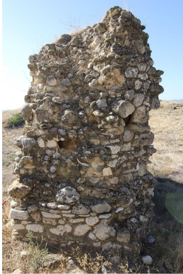
Fig.56c: GK3'deki Güney Duvarın Kuzey Cephesinde Yapılmış Kapı Kilidi Oyuğu.
