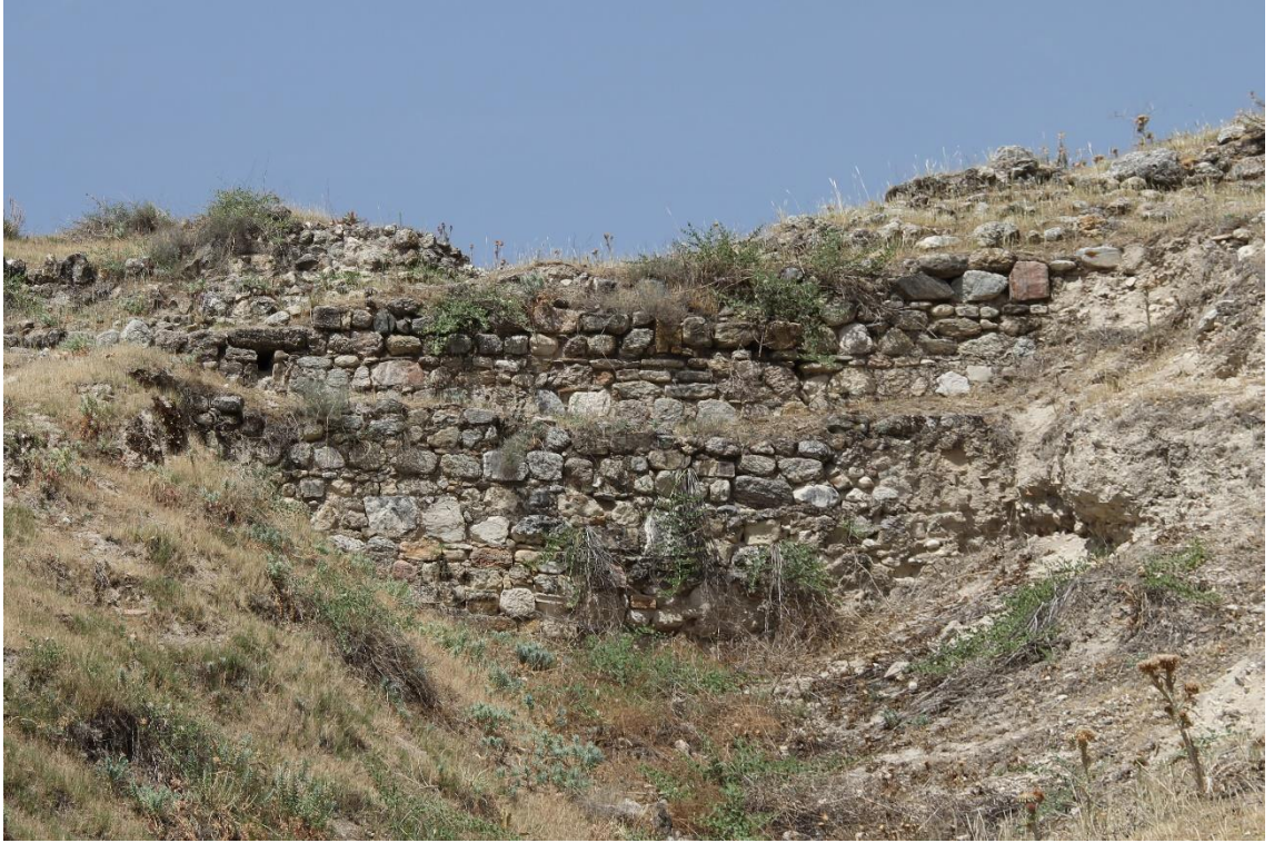
Fig.8: Erken Bizans Doğu Surlarında Çift Kademeli Yapılan Sur Hattı.
