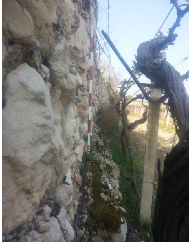
Fig.68e: Azmakkaşı Mevki Surunun Kuzey Cephesindeki Çıkıntı.
