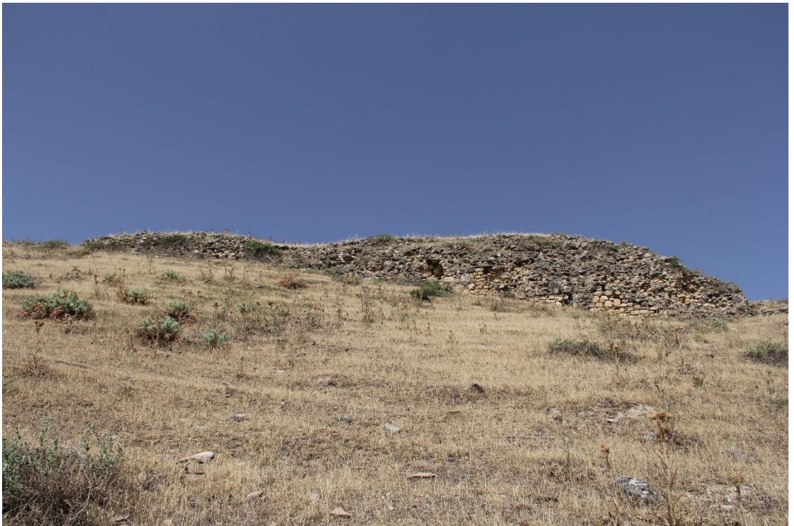
Fig.12: Erken Bizans Doğu Surları, Doğu Cephe.
