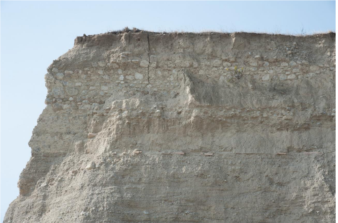
Fig.77d: Çayınkaşı Mevkisi Çevre Surunun Doğu Cephesinde Yer Alan Çatlak ve Üst Üste Yapılmış İki Künk Sırası.
