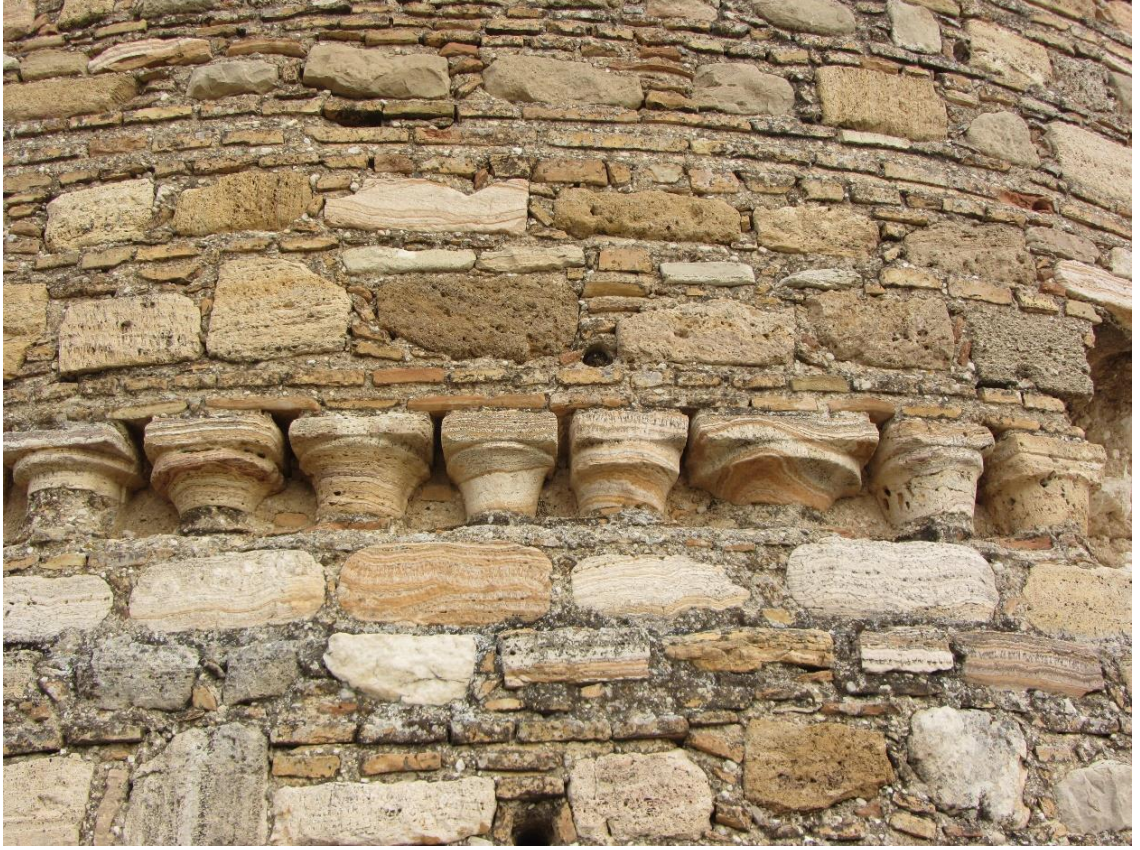
Fig.61c: Yukarı Kale GKL1'in Orta Bölümünde Devşirme Malzemeden Yapılmış Şerit.
