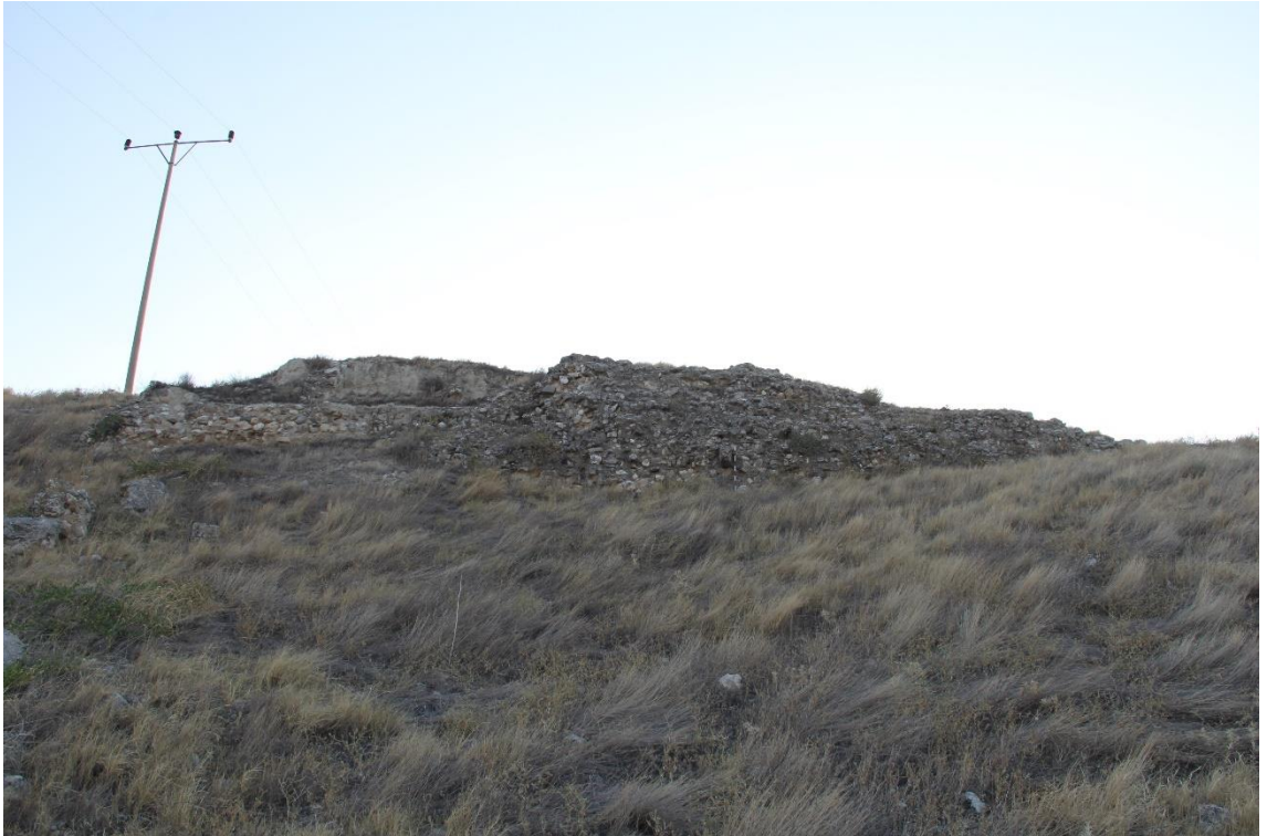
Fig.27b: Erken Bizans Batı Surlarının Batı Cephesi.
