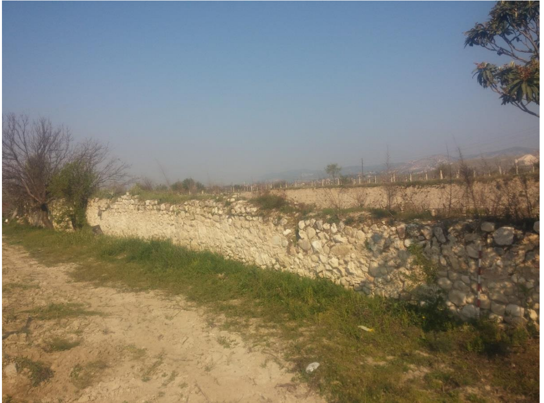
Fig.68b: Azmakkaşı Mevki Çevre Surunun Güney Cephesi.
