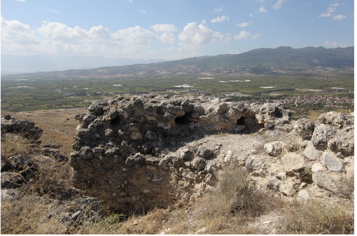
Fig.61f: Yukarı Kale GKL1 Üstünde Yer Alan Hatıl Delikleri.
