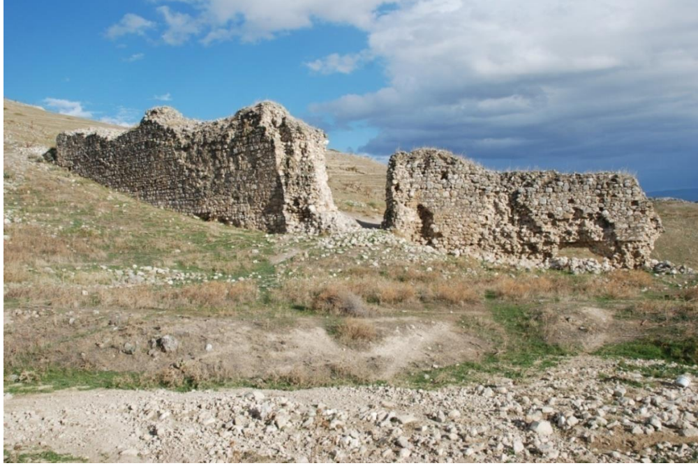
Fig.44a: Geç Bizans Dönemine Ait Bindirme Tekniğinde Yapılan GK3 ve Sur Hattının Batı Cephesi.
