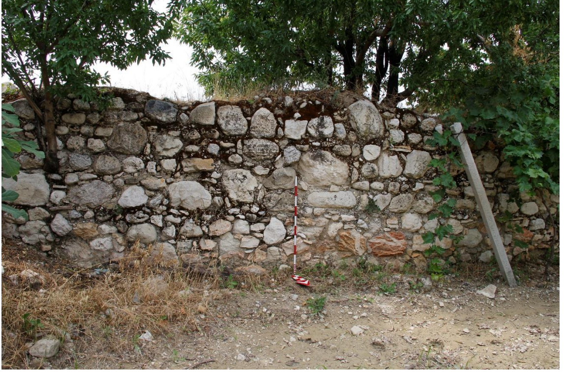
Fig.68c: Azmakkaşı Mevki Çevre Surunun Kuzey Cephesi.
