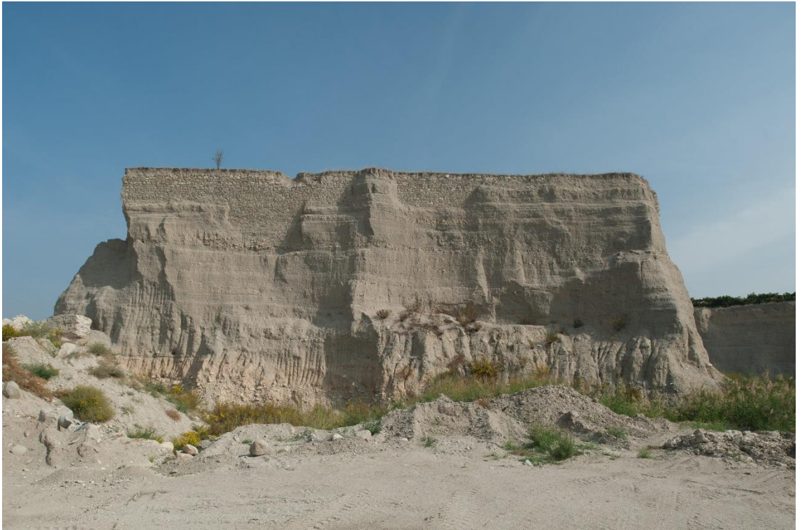
Fig.77b: ayınkaşı Mevkisi evre Surunun Batı Cephesi.
