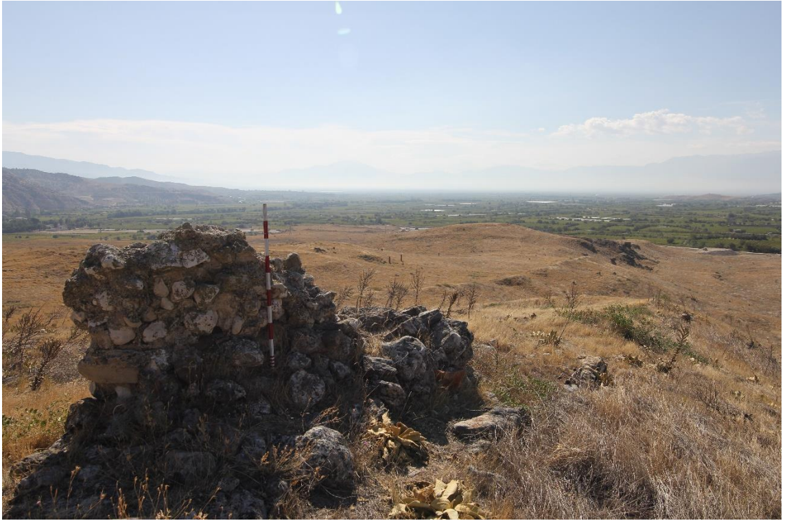
Fig.32: Kuzeydeki Sur Duvarı Parçası ve Güneye Doğru Devam Eden Sur Duvarı.
