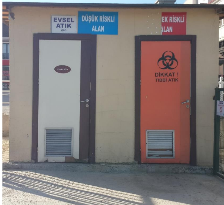
Resim 3.14: ABC Hastanesi Geçici Evsel ve Tıbbi Atık Deposu
