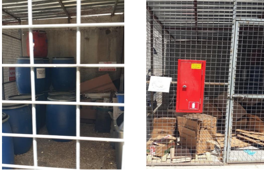
Resim 3.13: ABC Hastanesi Geçici Tehlikeli Atık ve Ambalaj Atıkları Deposu
