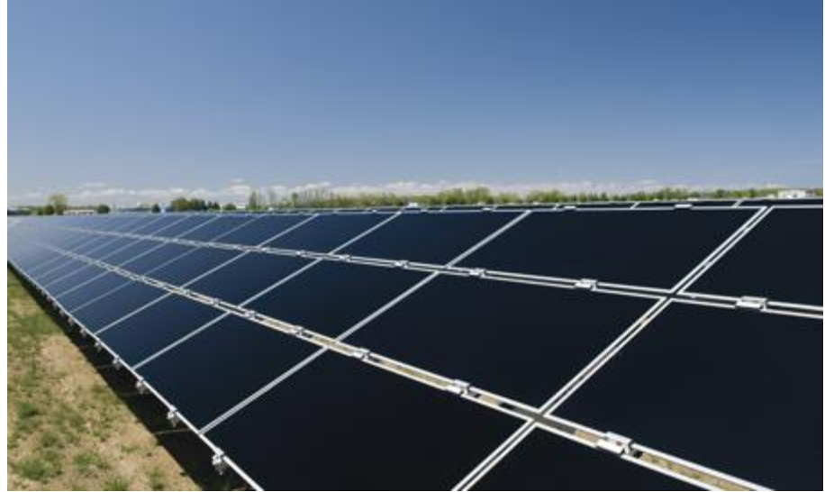
Şekil 3.12: CdTe ince film güneş pilleri (Url-15, 2019)
