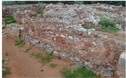
Figür 86 a-b: Malia Sarayı batı kanadından kesme taş ve moloz taş duvar.
