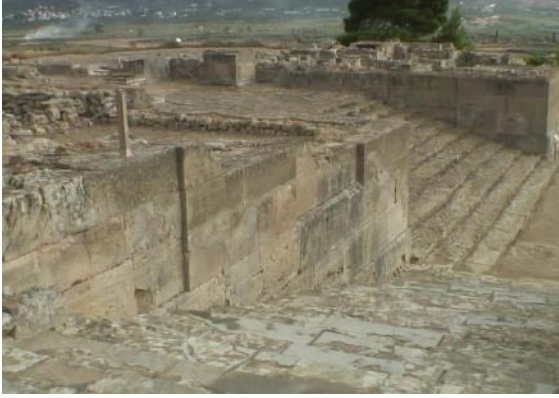
Figür 104: Phaistos Sarayı batı kanadındaki ortostatlar.
