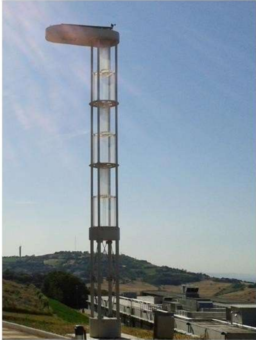
Şekil 4.3: Savonius rotoru ile çalışan sokak lambası (Ricci ve diğ. 2016)
