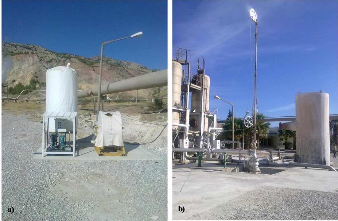
Şekil 1.8: Mineral çökelmesini engellemek için sahada kullanılan İnhibitör düzeni. İnhibitör pompa aracılığıyla depodan emilip (a), kapiler boru vasıtasıyla, kuyu başındaki makara sisteminden geçerek kuyu içine gönderilmektedir (b).
