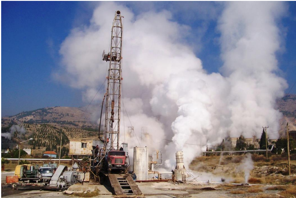
Şekil 1.7: İnhibitör öncesinde sahada uygulanan mekanik temizlik operasyonu.
