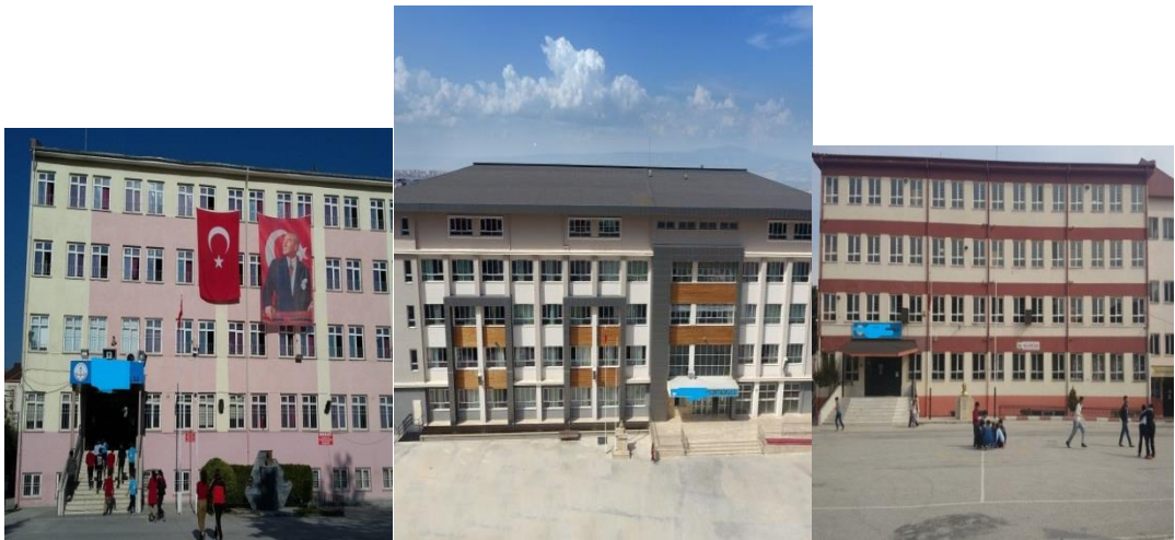
Şekil 4.2. Okul binalarının dıştan görünümü
