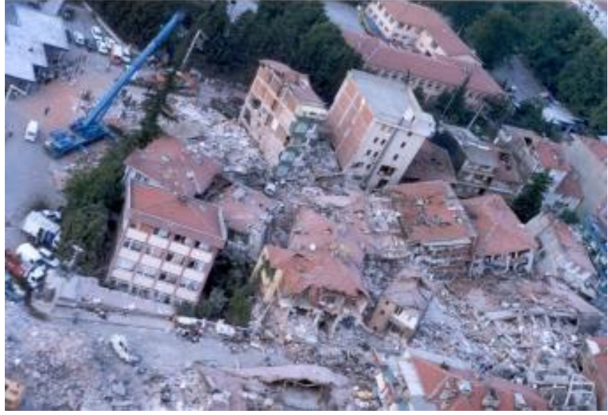
Şekil 1.1: 17 Ağustos 1999 G?lc?k depreminde hasar almış bazı yapılar (Anonim)
