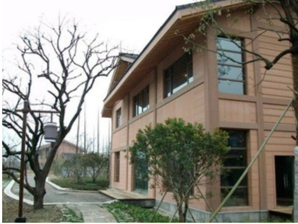
Şekil 2.3: Doğal kompozit kullanılarak inşa edilmiş ev (Web Anonim 2)
