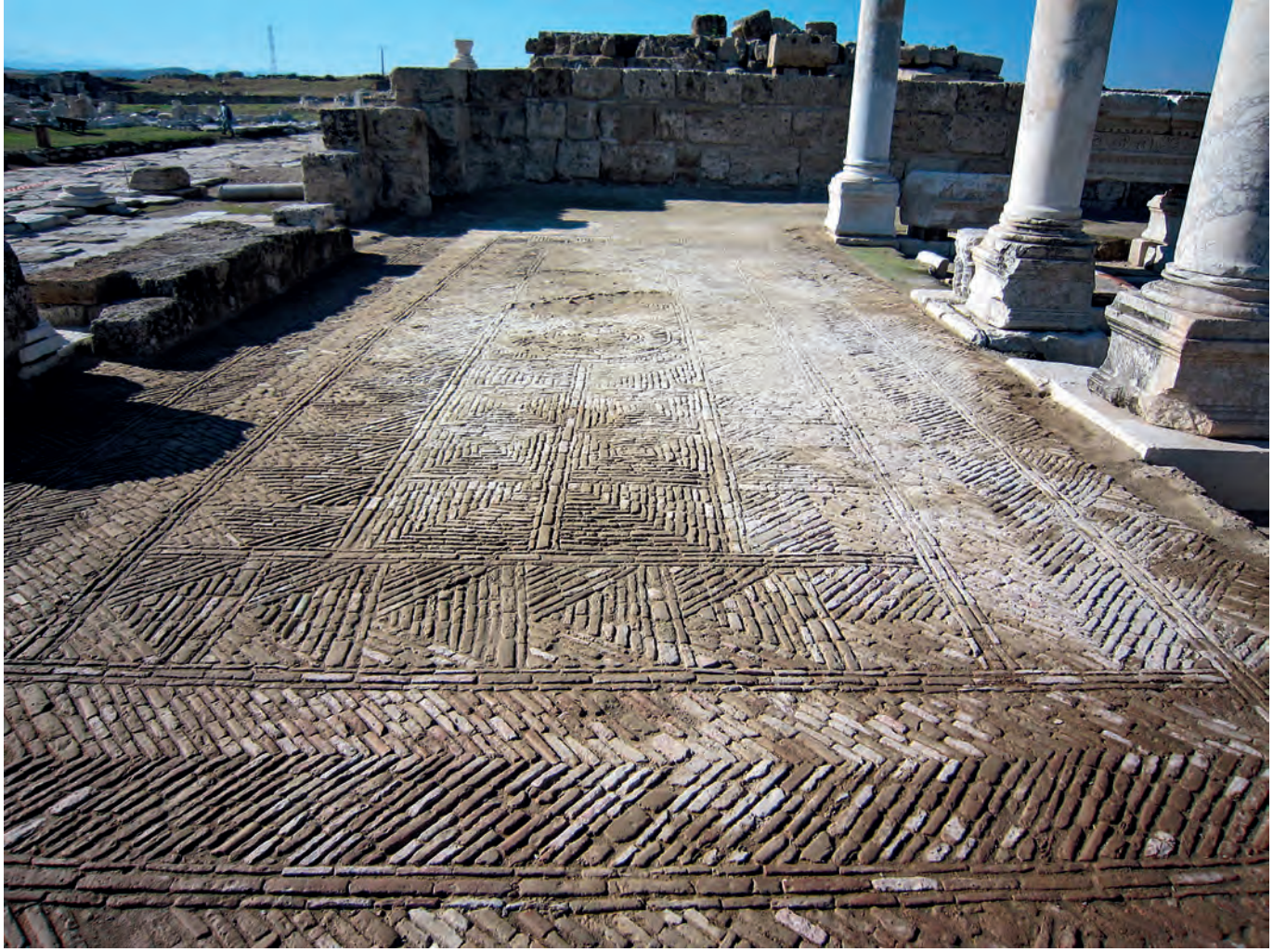
Fig. 18 Tapınak A, Güney Portik kuzey kanadında yer alan opus spicatum döşemeler (MS 5.-6. yy)
