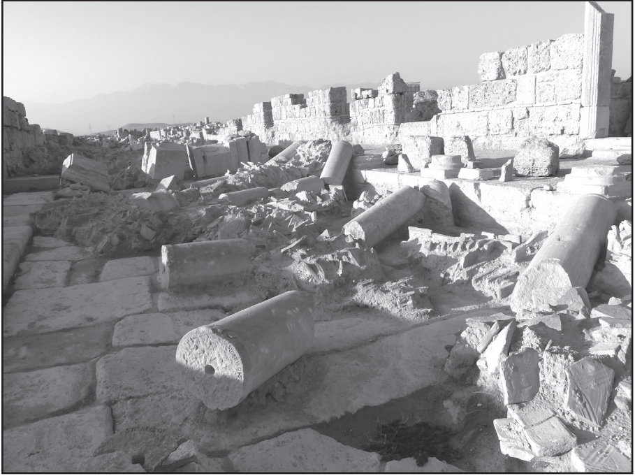
Resim 3: Stadyum Caddesi Batı Portiçe ait depremde taban üzerine yıkılan kaide, sütun ve başlıkların in-situ hali.
