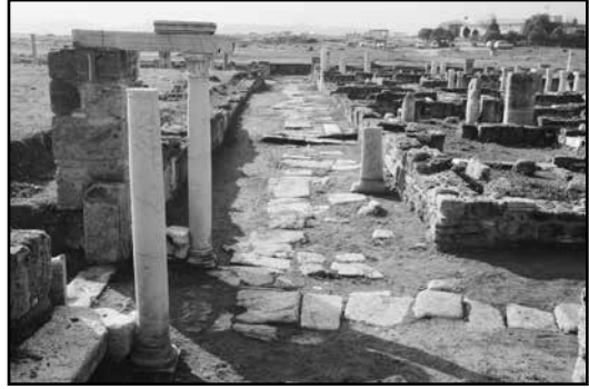
Resim 11: A Evi, Doğu ve Kuzey sokaklarının restorasyon sonrası durumu.
