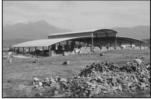
Resim 14: Laodikeia Kilisesi için yapılan koruma çatısı.
