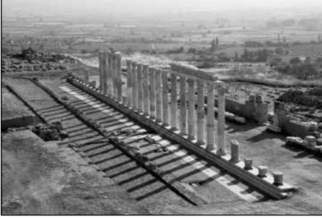
Resim 13:Kuzey (Kutsal) Agora, Doğu Portik sütunlu galerisi, kanalizasyon sistemi ve dikdörtgen havuz.
