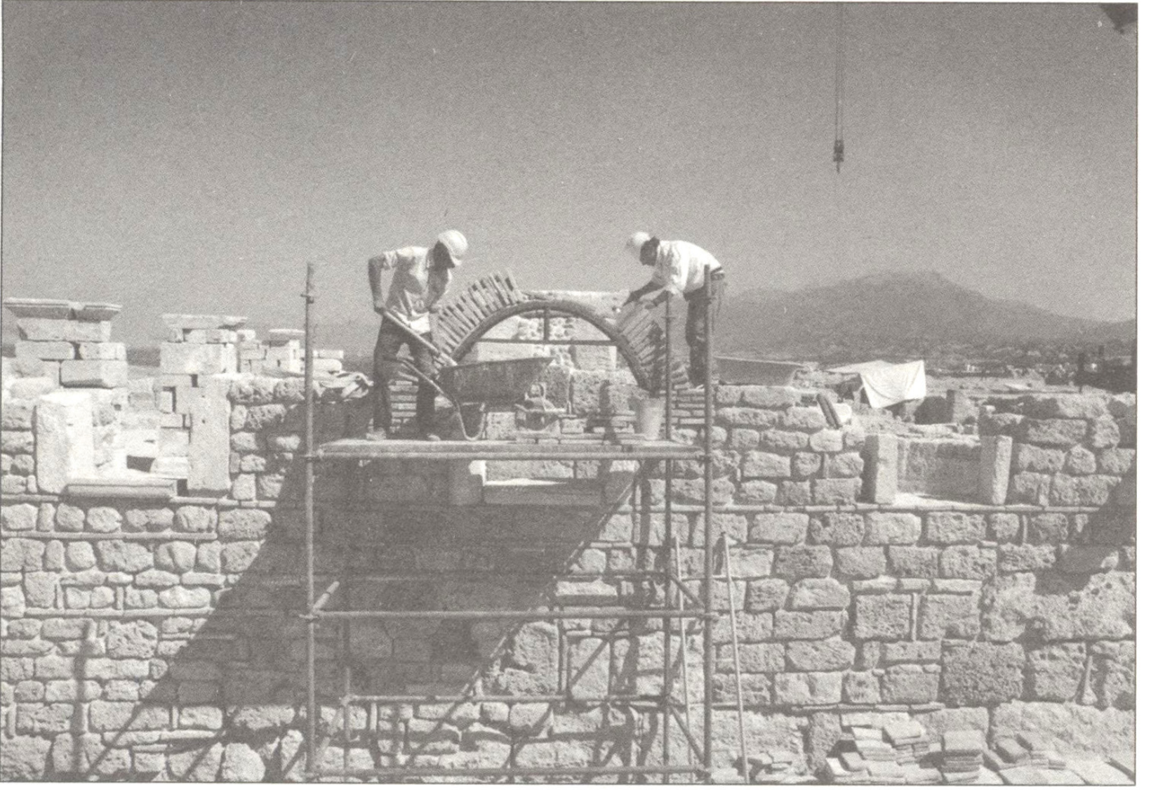
Resim 14: Laodikeia Kilisesi'nin, narteks batı duvarı ve pencerelerindeki restorasyon çalışmaları
