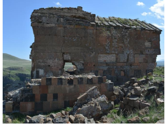
Resim 9. Saray Kilisesi iç mekan kuzey cephe
