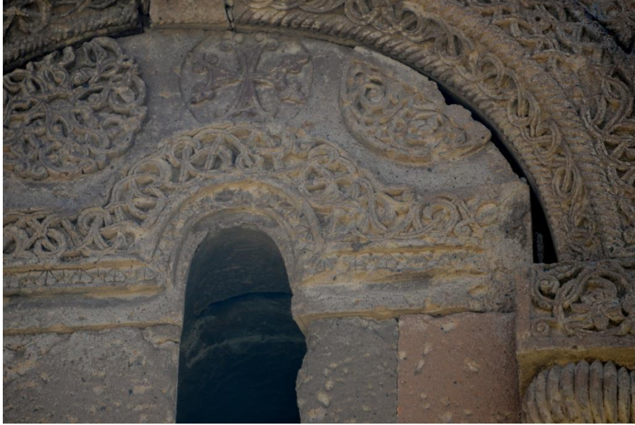
Resim 451: Kızlar Manastırı Kilisesi, batı cephede kuzey uçtaki pencere açıklığı
