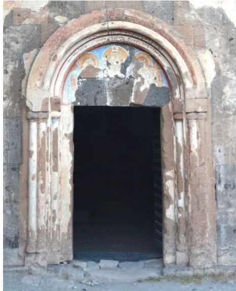
Resim 343: Tigran Honents Kilisesi, batı cephe eksenindeki kapı açıklığı
