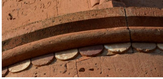
Resim 434: Bakireler Manastırı Kilisesi, kubbe kasağı alt seviye silme kuşığı bezeme
