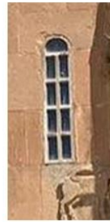
Akdamar Surp Haç Kilisesi güney konchu aydınlatan batıdaki pencere
