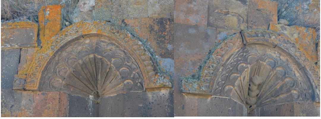
Resim 512: S. Minas Kilisesi, kuzey cephe doğudaki nişin tepeliği
