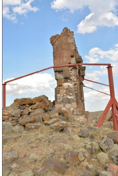
Resim 323: Gürcü Kilisesi, batı cephe korunan bölüm
