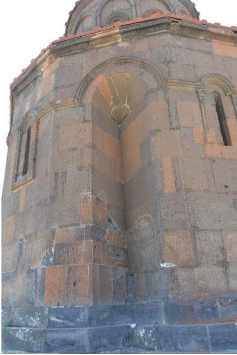
Resim 206: Apughamrents Kilisesi, kuzey cephe niş
