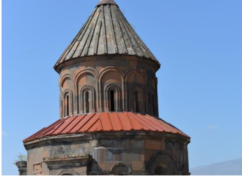
Resim 227: Apughamrents Kilisesi, örtü sistemi
