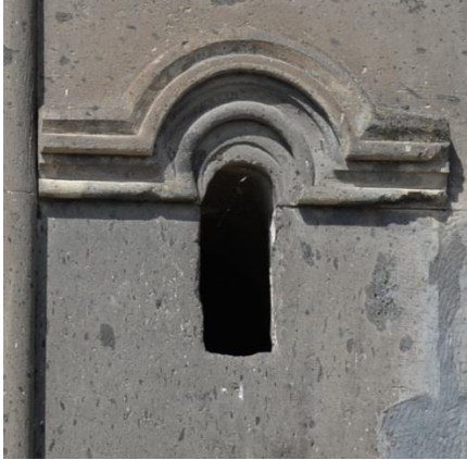
Resim 356: Tigran Honents Kilisesi, doğu cephede kuzey uçta alt seviyedeki pencere
