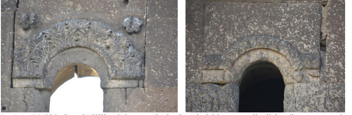
Resim 584-585: Oğuzlu Kilisesi doğu cephe deksenindeki pencere ile diakonikon penceresi
