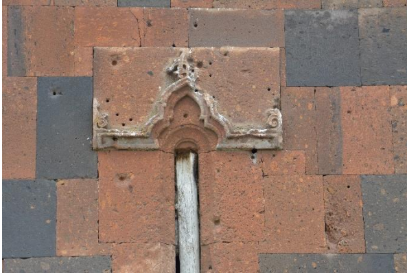
Resim 613: Dprevank Kilisesi, kuzey cephede eksendeki pencere
