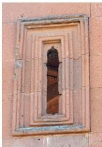
DeğirmendereKarmirvank Kilisesi, Doğu cephe eksenindeki pencereler
