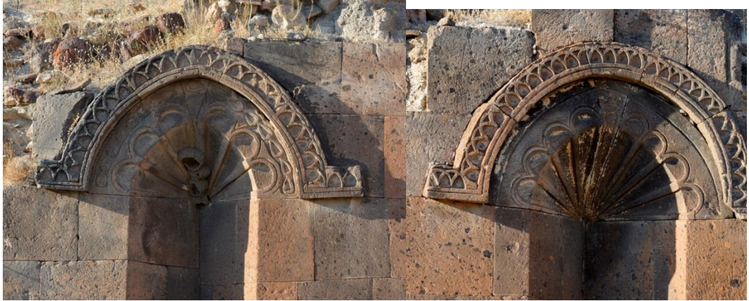
Resim 508: S. Minas Kilisesi, güney cephe batıdaki nişin tepeliği
