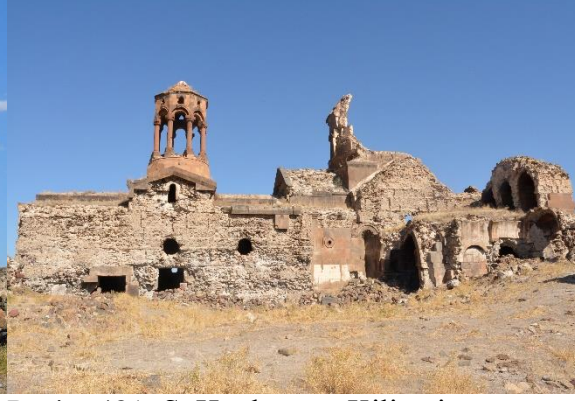
Resim 481: S. Hovhannes Kilisesi güney cephe
