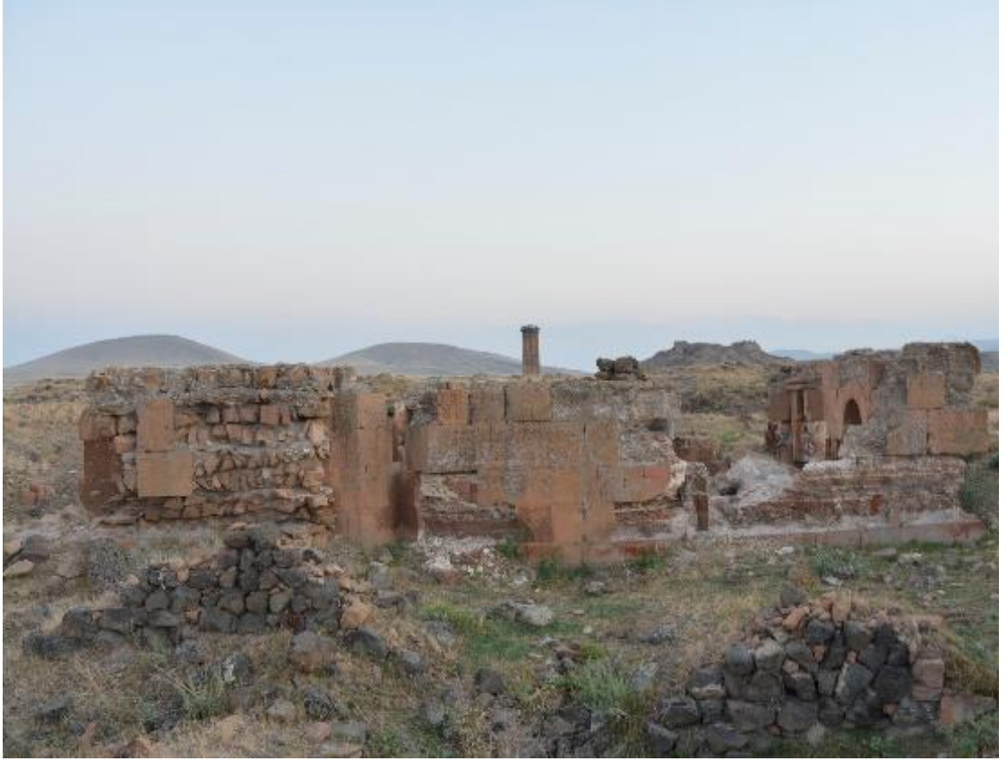
Resim 308: Anonim Kilise kuzey cephe mevcut durum
