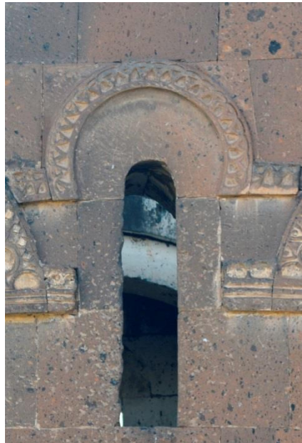
Resim 517: S. Minas Kilisesi, doğu cephe eksenindeki pencere
