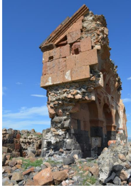
Resim 10. Saray Kilisesi batı cephe mevcut durum
