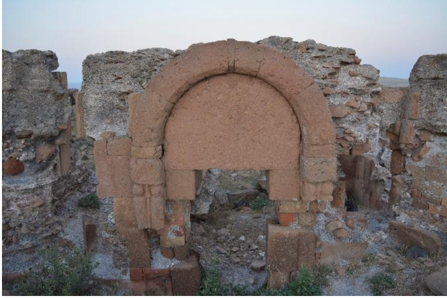
Resim 309: Anonim Kilise, batı cephe eksenindeki kapı açıklığı
