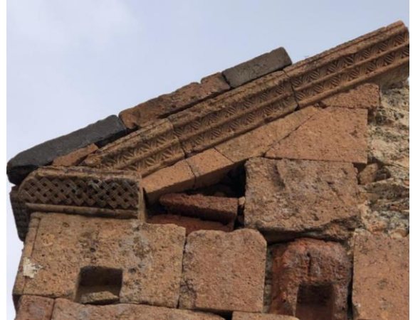
Resim 16. Saray Kilisesi batı cephe saçak frizi
