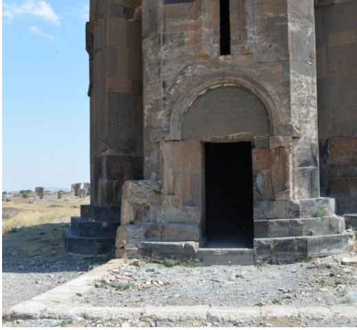
Resim 200: Apughamrents Kilisesi, güney cephe eksenindeki kapı açıklığı
