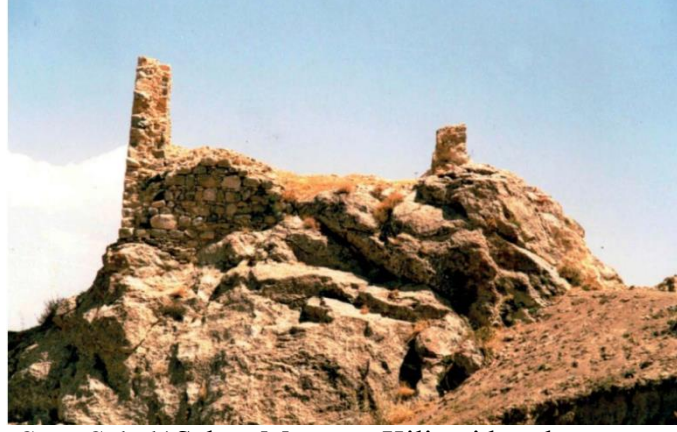
Resim 774: Elerin Surp Sahak\Sahag Manastır Kilisesi batıdan görünüm
