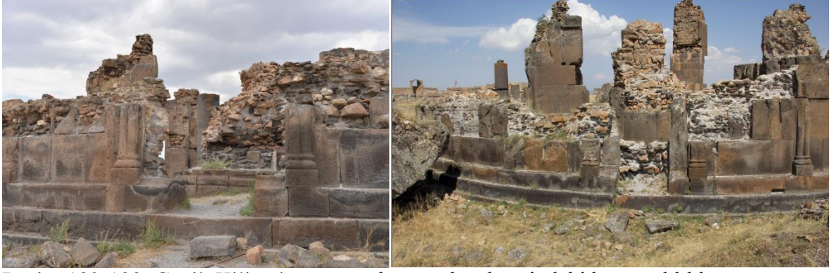
Resim 182-183: Gagik Kilisesi güney ve batı cephe eksenindeki kapı açıklıkları
