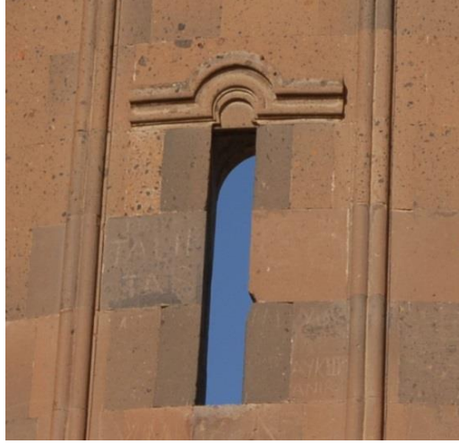
Resim 295: Surp Amenap'rkitch Kilisesi kubbe kasnađı, pencere açıklığı
