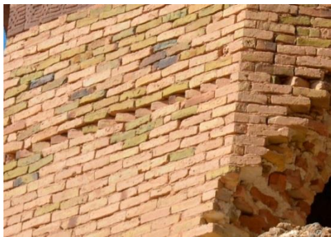
Resim869: Gevaş Karmirvank Manastırı Surp Asdvadzadzin Kilisesi, kubbe kasnağı, testere dişi motifi\kirpi saçak
