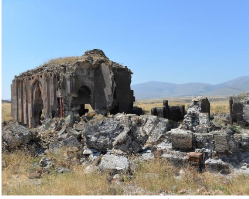
Resim 240: Ani Surp Arake'lots Kilisesi, kuzeydoğudan görünüm
