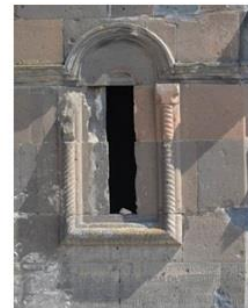
Apughamrents Kilisesi kuzeydoğu, açılan pencere
