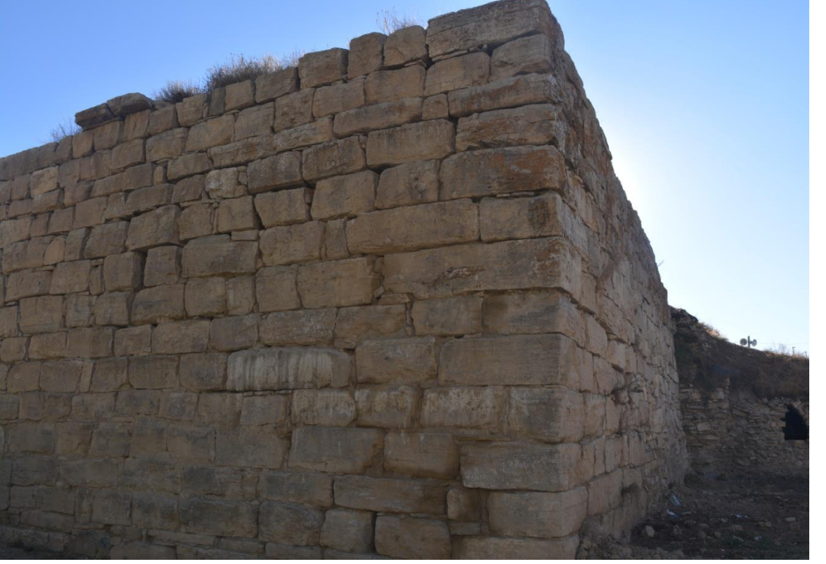
Resim 751: Surp Asdvadzadzin Kilisesi kuzeydoğudan görünüm
