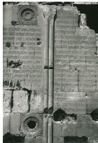
Resim 453: Kızlar Manastırı Kilisesi, yıkık durumdaki güney cephede doğu uçundaki kemer dizisi
