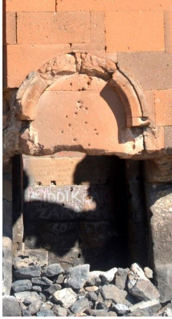
Resim 545: Taylar Kilise, güney cephe eksenindeki kapıaçıklığı
