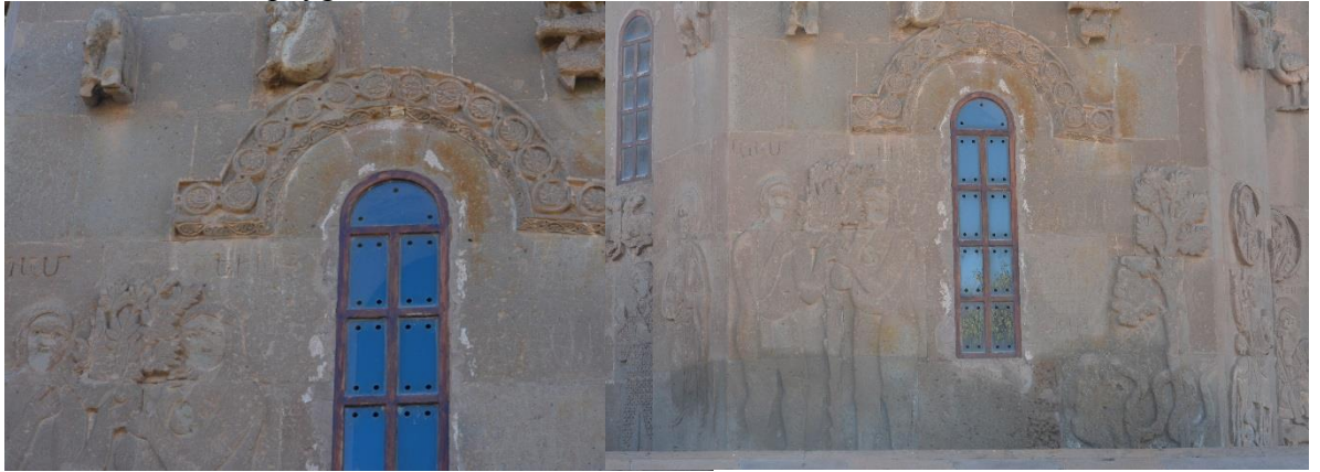
Resim 840: Akdamar Surp Haç/Khaç Kilisesi kuzey cephede eksendeki pencere
