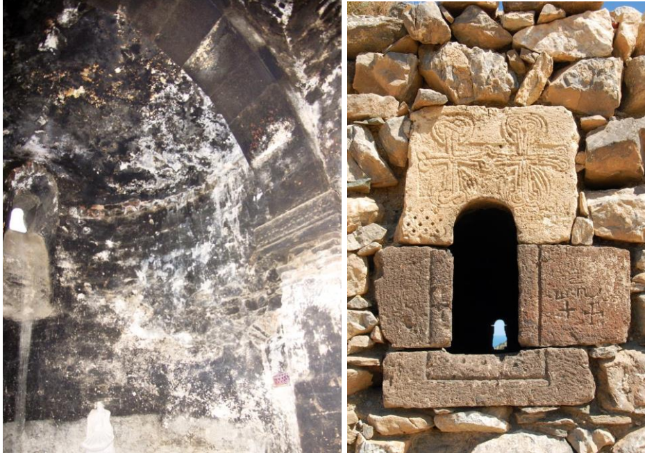
Resim 936-937: Tatvan Sorb Surp Karapet Kilisesi iç mekan ve doğu o-penceresinin yanındaki haçlar
