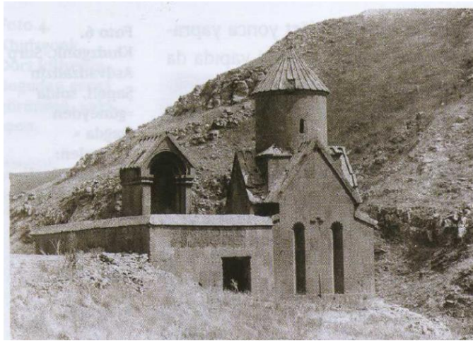
Resim 669: Surp Grigor Lasavoriç Kilisesi batıdan görünüm
