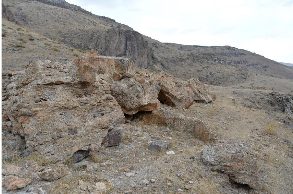
Resim 686: Surp Stephanos Kilisesi zemin seviyesindeki kalıntılar
