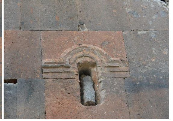
Resim 614: Dprevank Kilisesi, kuzey cephede batı taraftaki ek mekana açılan pencere
