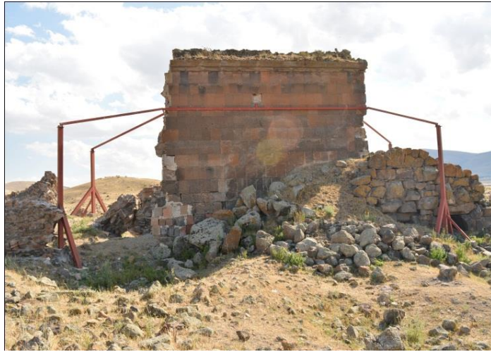
Resim 322: Gürcü Kilisesi, kuzey cephe korunan bölüm
