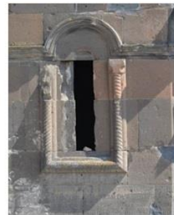
Apughamrents Kilisesi kuzeydoğu, açılan pencere
