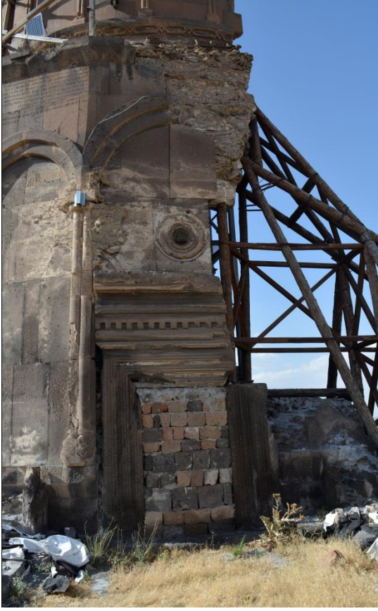
Resim 272: Surp Amenap'rkitch Kilisesi, güney cephe eksenindeki kapı açıklığı
