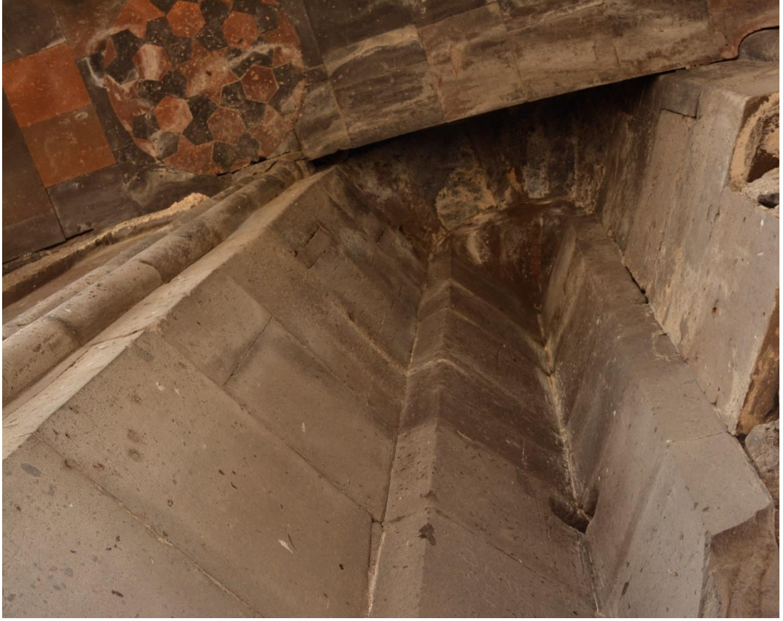
Resim 247: Ani Surp Arake'lots Kilisesi, güney cephe doğu taraftaki niş
