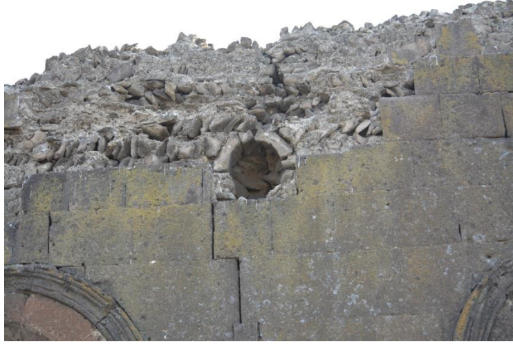
Resim 591: Oğuzlu Kilisesi kuzey cephede eksenindeki okulus pencere
