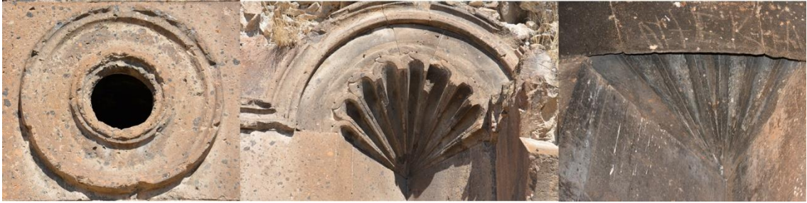
Resim 491: S. Hovhannes Kilisesi, güney cephe okulus pencere ve nişler
