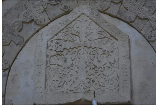
Resim 756: Surp Asdvadzadzin Kilisesi, batı cephe eksenindeki giriş kapısı detay
