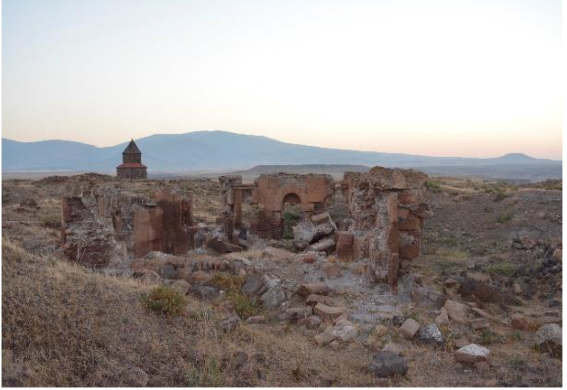
Resim 307: Anonim Kilise dođu cephe mevcut durum
