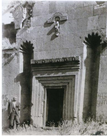
Resim 668: Surp Stephanos Kilisesi güney cephe eksenindeki kapı açıklığı
