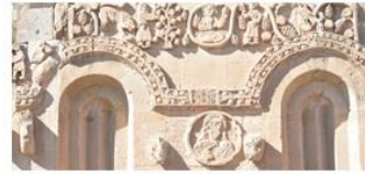
Akdamar Adası Surp Haç Kilisesi Doğu cephe
