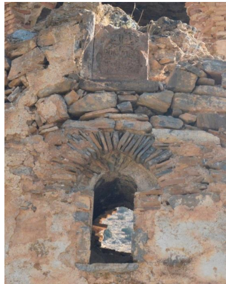
Resim 862: Karmirvank Manastırı Surp Asdvadzadzin Kilisesi batı cephede eksenindeki pencere
