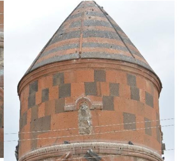
Resim 616: Dprevank Kilisesi, kubbe kasnağı
