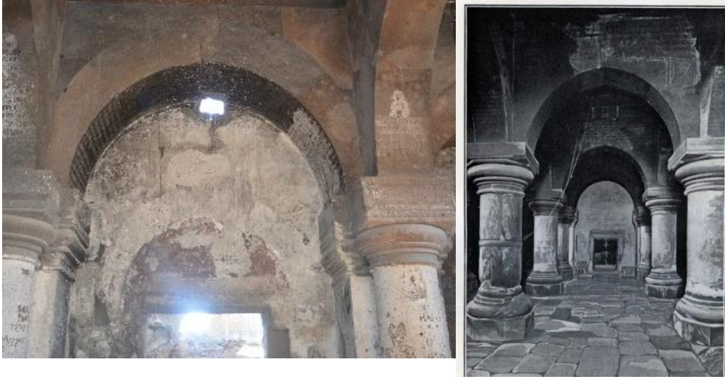
Resim 496-497: Jamatun iç mekan, kilise batı kapısı ( https://www.vanker.org/fiche/horo-jean/saint-jean/#anciennes-photos , 10.04.2019)
