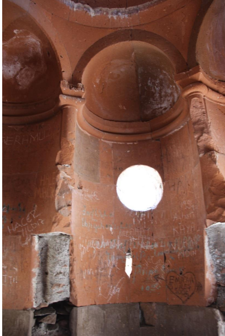
Resim 402: Bakireler Manastırı Kilisesi iç mekan
