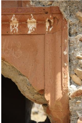
Resim 422: Bakireler Manastırı Kilisesi, batı cephe eksenindeki kapı açıklığı detay
