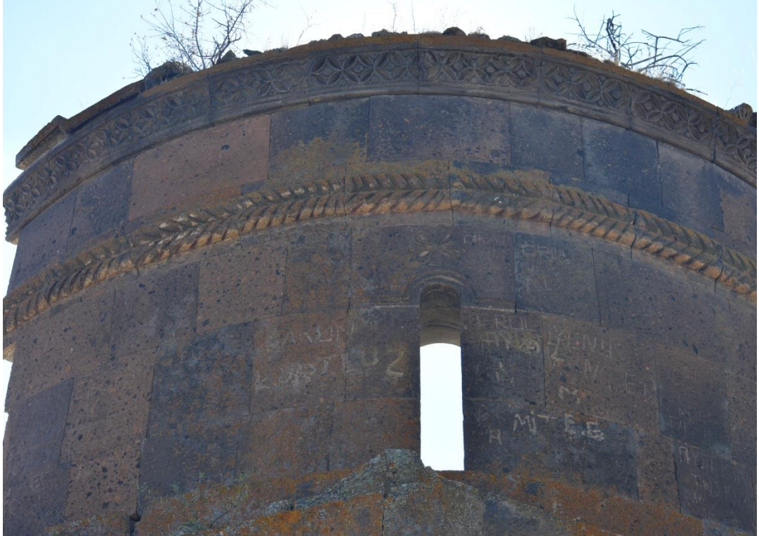
Resim 519: S. Minas Kilisesi kubbe kasnağı, korunan kuzey kısım
