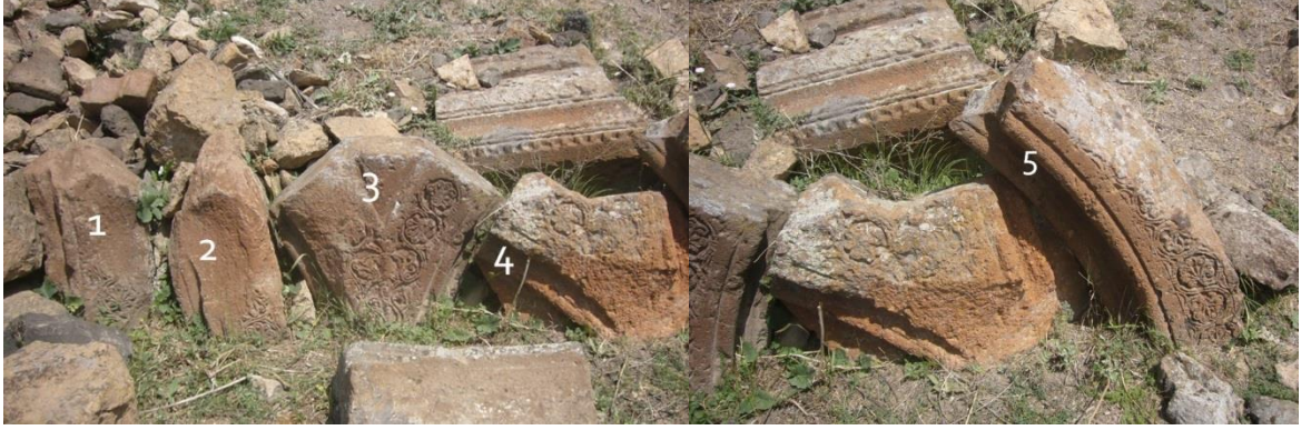
Resim 169-170: Gagik Kilisesi yapı kalıntıları arasında kemer dizileri parçaları
