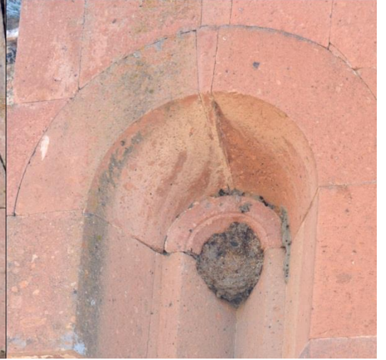
Resim 570: Karmirvank Kilisesi, doğu cephe kuzey taraftaki üçgen nişin tepeliği
