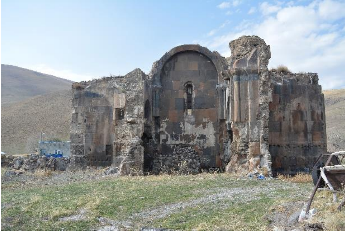
Resim 635: Baghnayr Manastırı Surp Asdvadzadzin Kilisesi, doğudan görünüm
