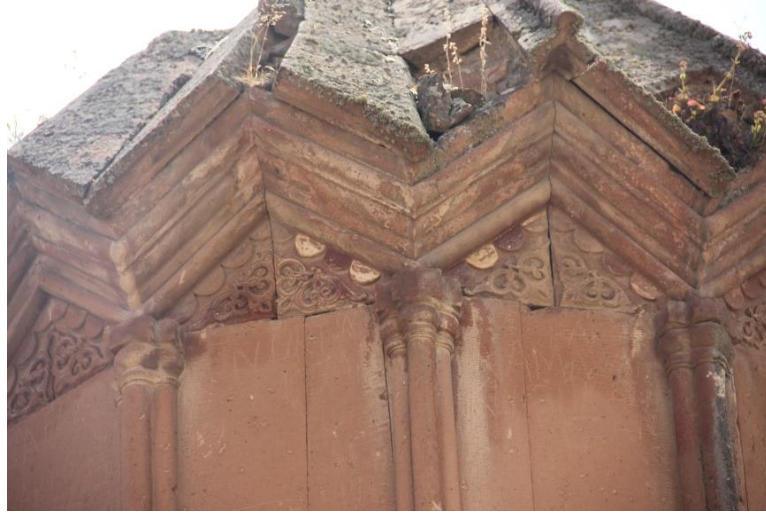
Resim 435: Bakireler Manastırı Kilisesi, kubbe kasağı kemer dizisi, örtü sistemi
