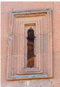
DeğirmendereKarmirvank Kilisesi, Doğu cephe eksenindeki pencereler
