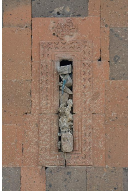
Resim 604: Dprevank Kilisesi, güney cephe eksenindeki pencere
