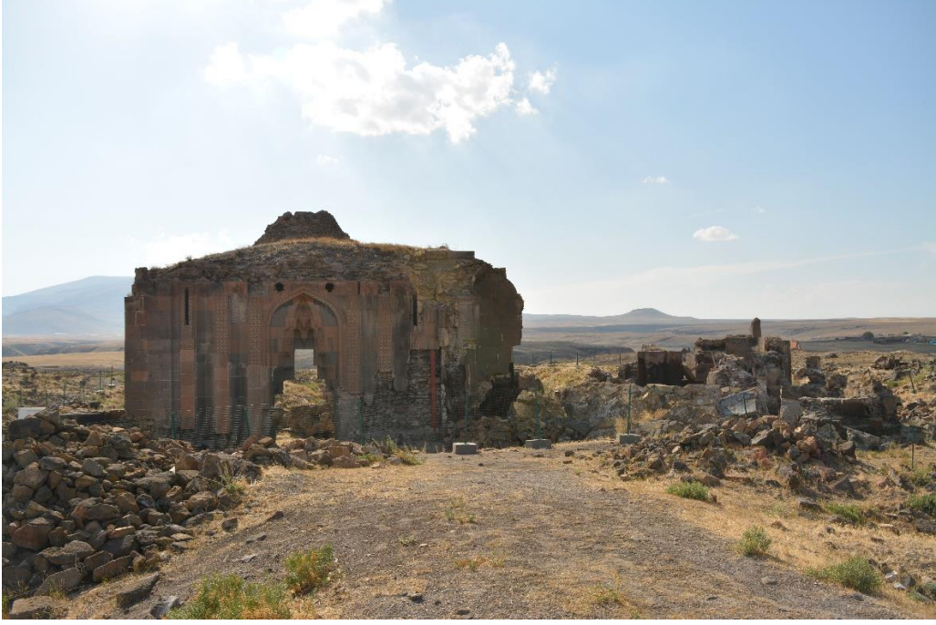
Resim 233: Ani Surp Arake'lots Kilisesi, güney jamatun doğu cephe
