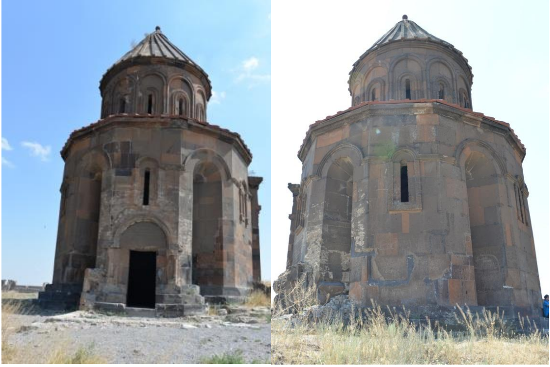
Resim 196-197: Apughamrents Kilisesi güneybatı, batı ve kuzeybatı cepheler
