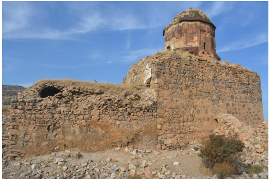
Resim 873: Kantzag/Ganjak Surp Thomas Manastır Kilisesi, güney cephe
