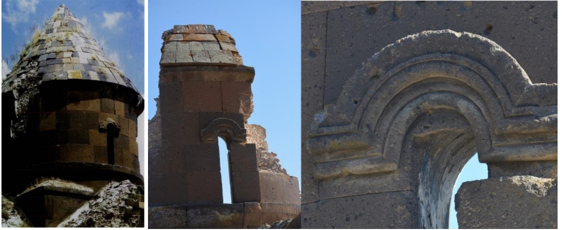
Resim 494: S. Hovhannes Kilisesi kubbe kasağı (Totoyan Baladian 2002, 54, Fig. 16)
