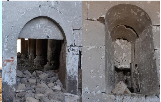
Resim 485: S. Hovhannes Kilisesi, batı cephe eksenindeki kapı ve pencere açıklığı
