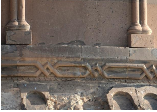
Resim 277: Surp Amenap'rkitch Kilisesi kubbe kasmağı alt seviyedeki saçak frizi
