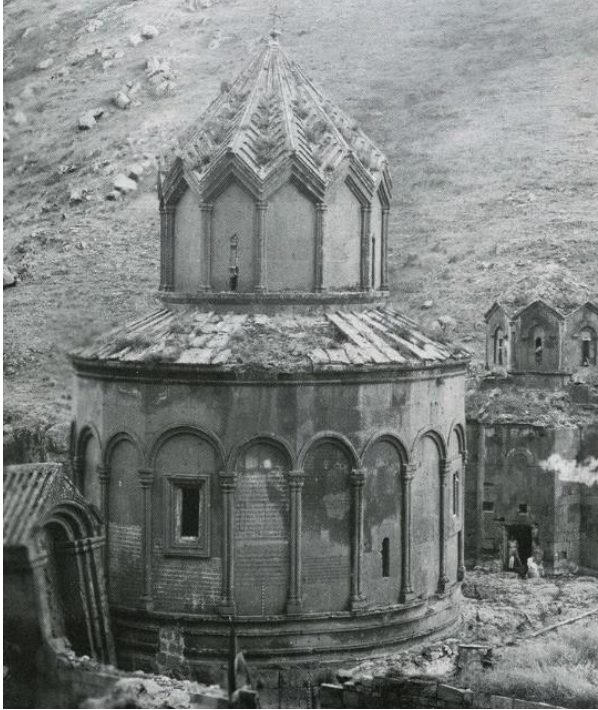
Resim 660: Surp Sargis Kilisesi kuzeybatıdan görünüm
