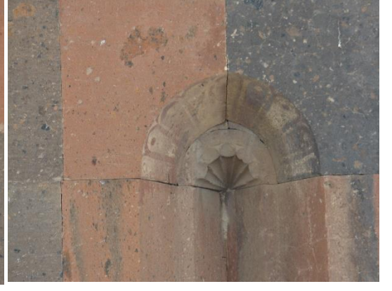
Resim 603: Dprevank Kilisesi, güney cephede doğu tarafta yer alan nişin tepeliği
