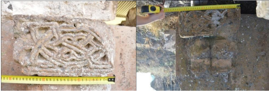
Resim 292-294: Surp Amenap'rkitch Kilisesi, yapıya ait kalıntılar içerisinde korunan başlıklar
