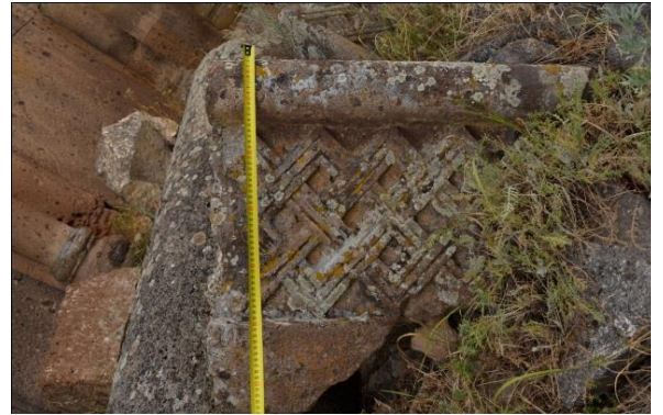
Resim 187: Gagik Kilisesi korunan yapı kalıntıları içinde yer alan saçak frizi parçası
