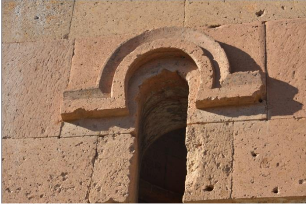
Resim 564: Güney cephe eskenindeki pencere
