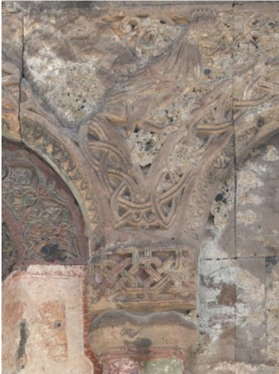
Resim 339: Tigran Honents Kilisesi, batı cephede güney kanatta içteki ikinci başlık ve kemer köşeliği
