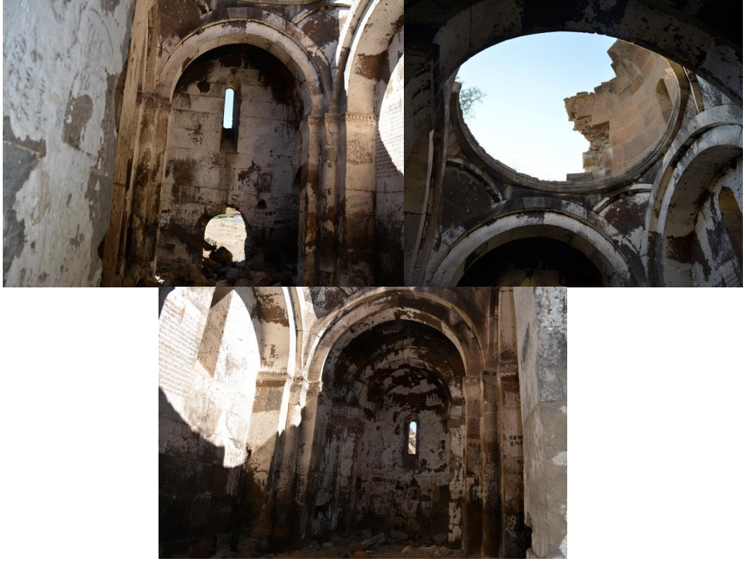
Resim 505-507: S. Minas Kilisesi iç mekan
