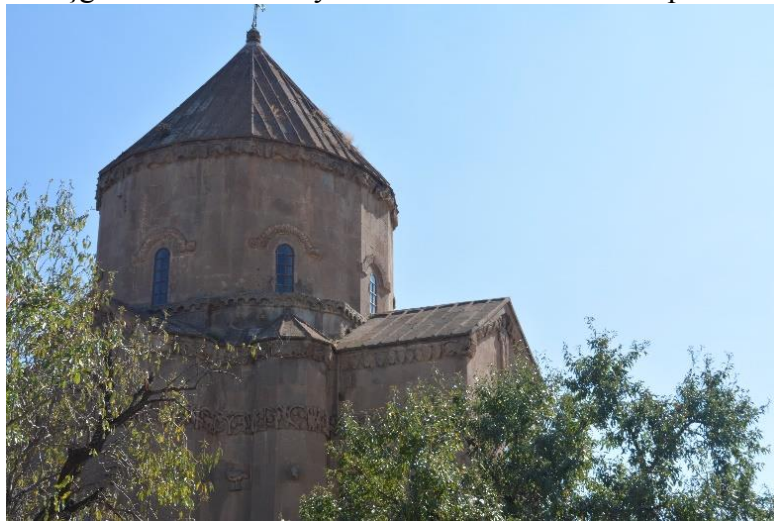
Resim 850: Akdamar Surp Haç/Khaç Kilisesi kubbe kasanğı kuzeybatıdan görünüm
