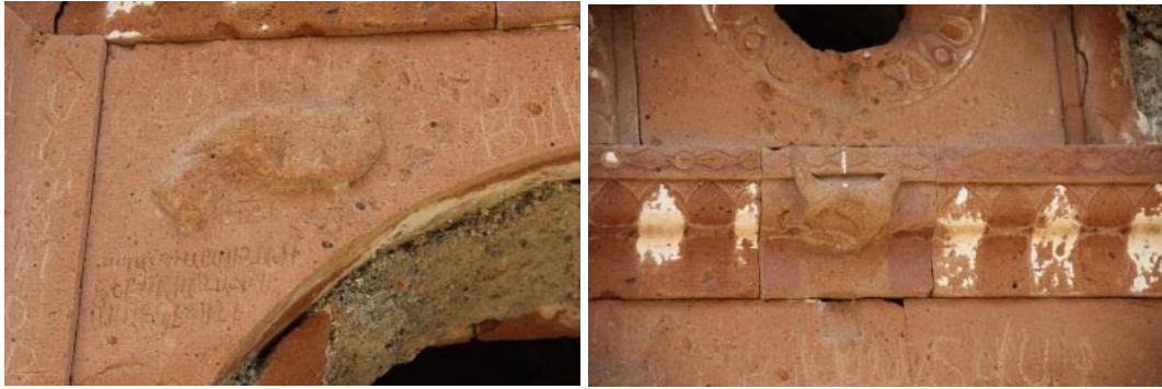
Resim 420-421: Bakireler Manastırı Kilisesi, batı cephe eksenindeki kapı açıklığı detay
