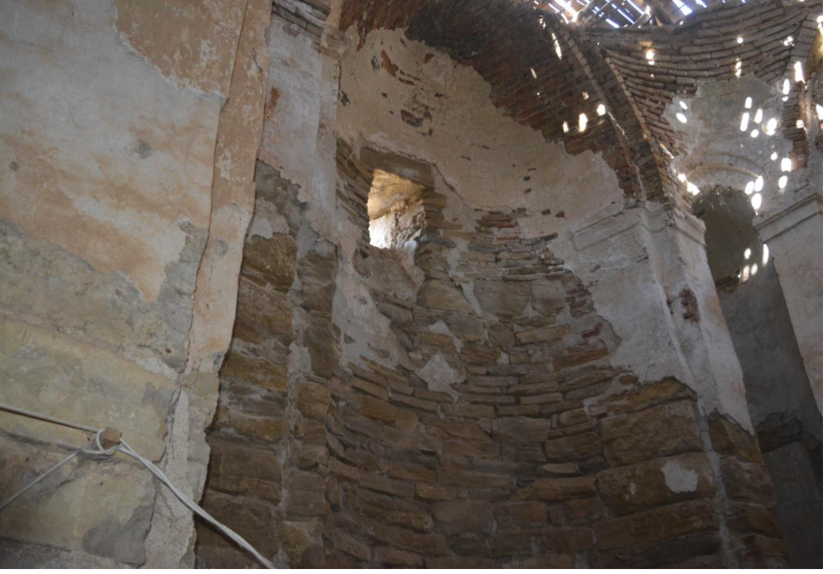
Resim 753: Surp Asdvadzadzin Kilisesi, iç mekan
