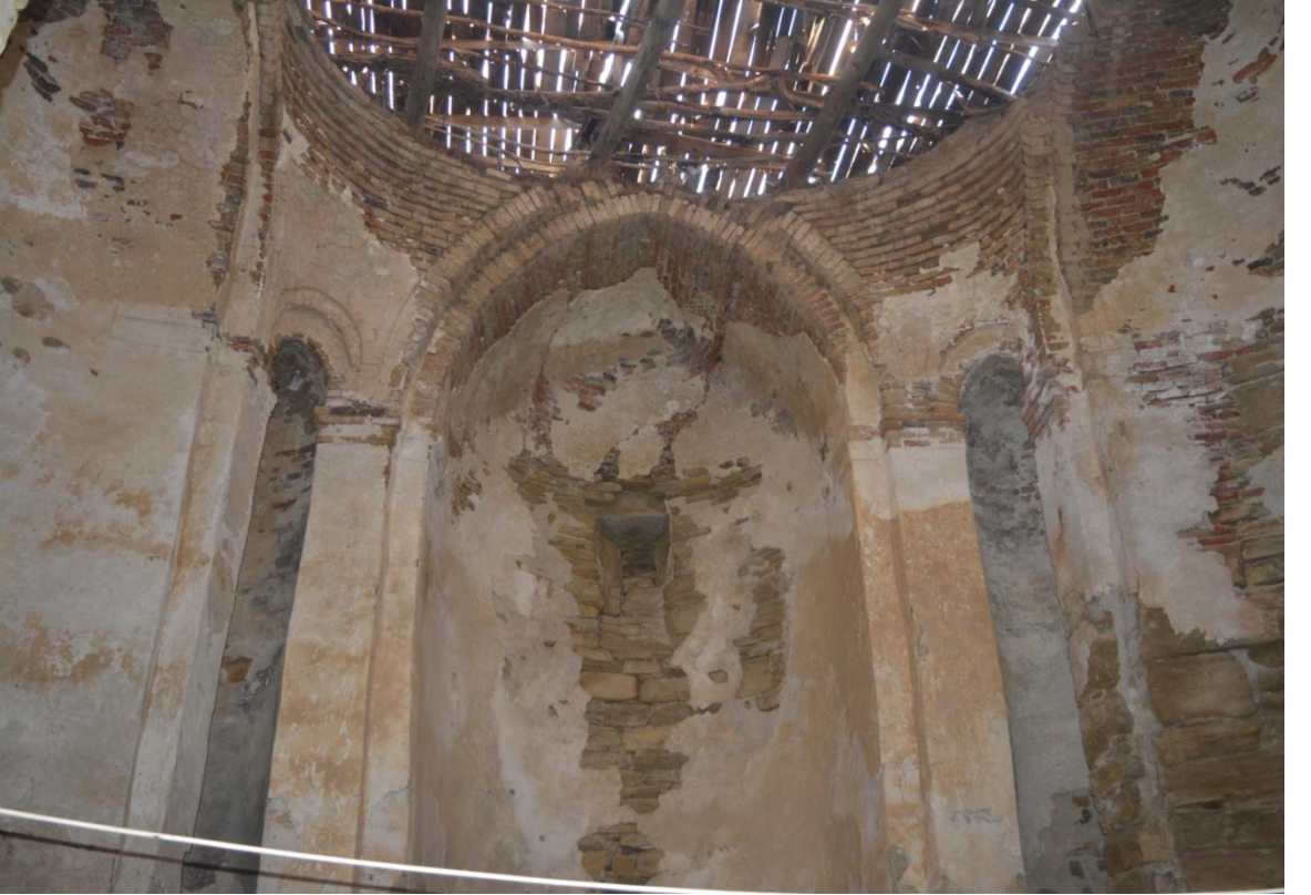
Resim 752: Surp Asdvadzadzin Kilisesi iç mekan
