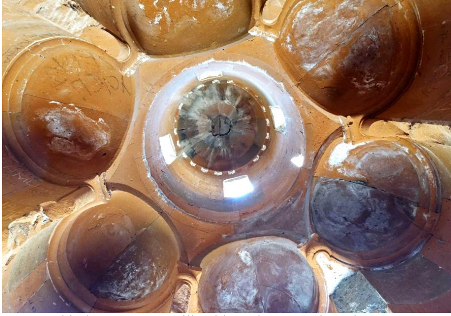
Resim 401: Bakireler Manastırı Kilisesi iç mekan örtü sistemi
