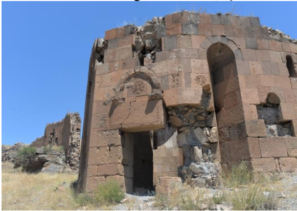
Resim 39: Ste. Egeia Kilisesi güney cephe
