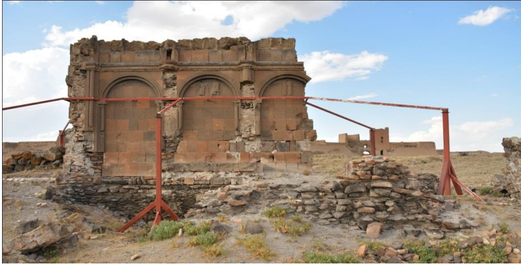
Resim 318: Gürcü Kilisesi, kuzey duvar iç mekandan
