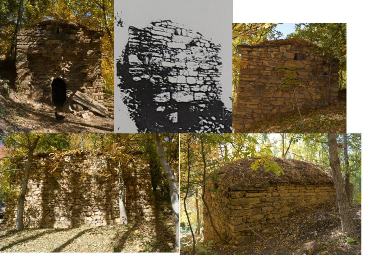
Resim 913: Papatya Köyü\Par Surp Grigor Kilisesi batı-doğu-güney-kuzey cepheler
