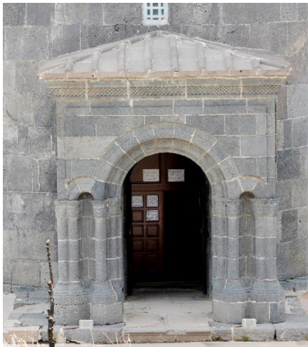
Resim 713: Kars Surp Arake'lots Kilisesi kuzey cephe eksenindeki giriş mekanı
