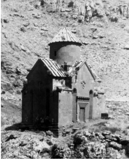
Resim 666: Surp Stephanos Kilisesi güneybatıdan
