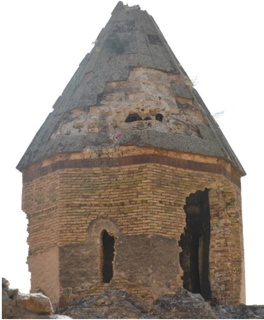
Resim 868: Gevaş Karmirvank Manastırı Surp Asdvadzadzin Kilisesi, kubbe kasnağı
