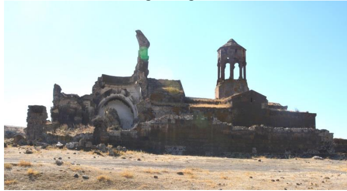
Resim 483: S. Hovhannes Kilisesi kuzeyden görünüm
