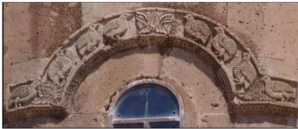
Resim 857: Akdamar Surp Haç/Khaç Kilisesi kubbe kasmağı, güneybatıya açılan pencere
