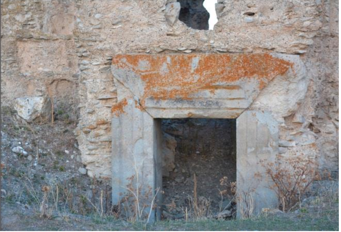
Resim 738: Kumbet Kilisesi, batı cephe eksenindeki kapı açıklığı
