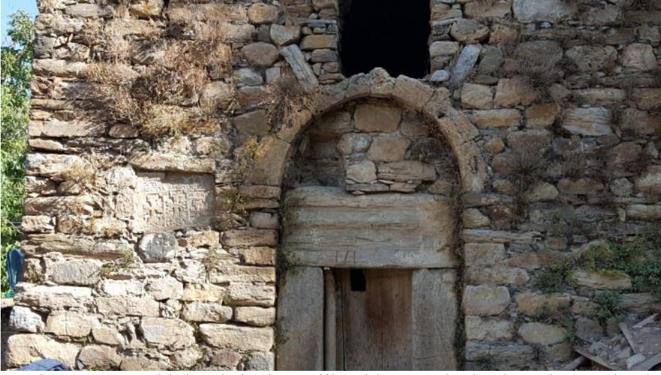
Resim 906 Bahçesaray Keskindöy/Kinekas Kilisesi batı cephede eksende yer alan kapı açıklığı
