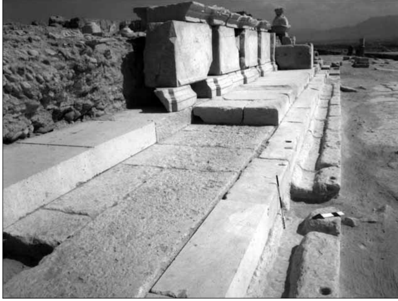
Resim 5: A Nympaeum'un, kaideli ve taçlı havuz parapetleri, arkada opus caementicium duvar, önde Erken Bizans havuzu ve açık su kanaleti
