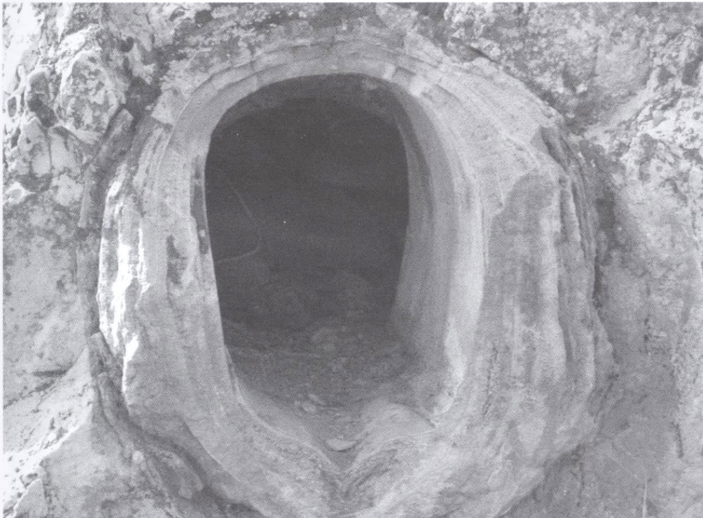
Res. 14 İkiz hat içinde oluşan kalker tabakası.
