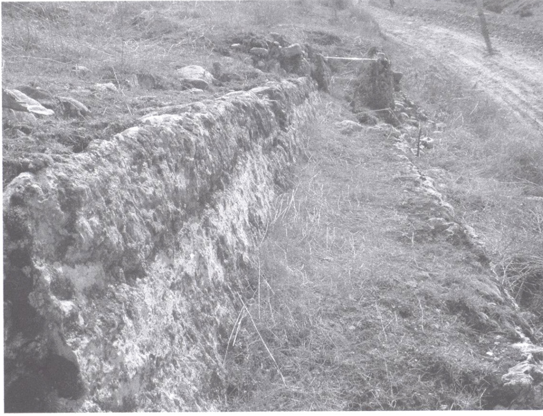
Res. 9 Armutkr Tepesi yannda yer alan in situ traverten kanal.
