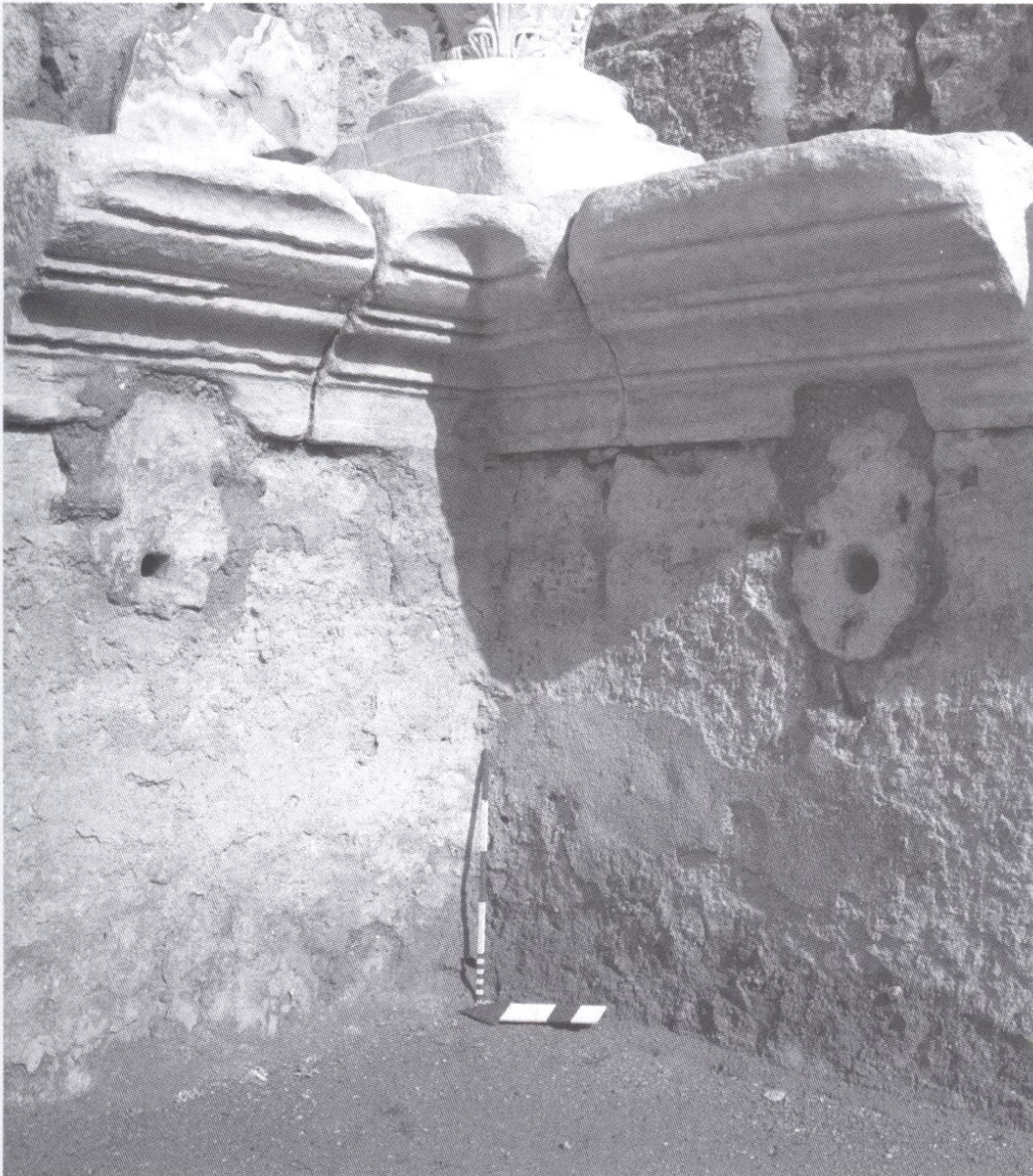
Res. 28 Septimius Severus Çeşmesi'nden havuz suyu tahliye kanalları.
