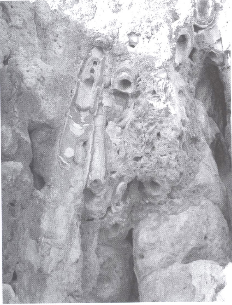
Res. 20 I. su dağıtım terminalinden pişmiş toprak borular
