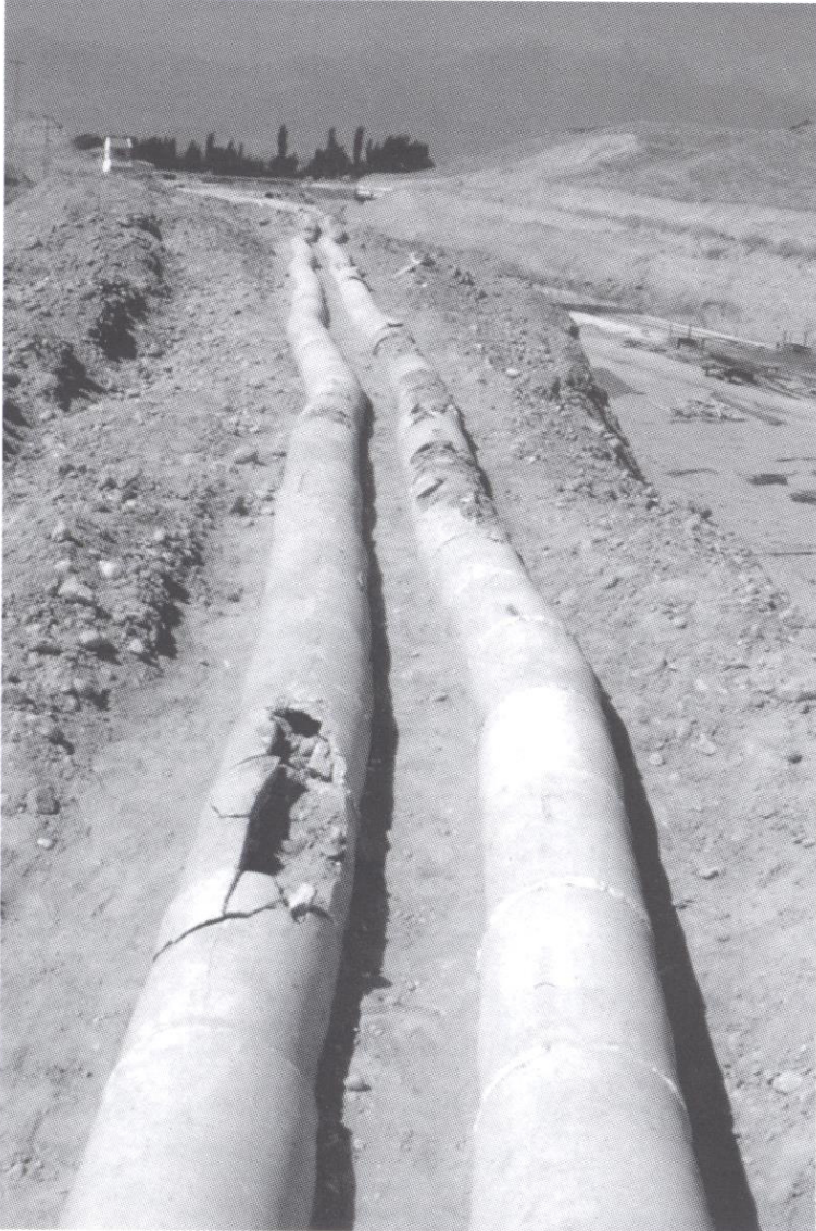
Res. 3 Denizli Su Arıtma Tesisi alanından kaldırılan pişmiş toprak ikiz hat.
