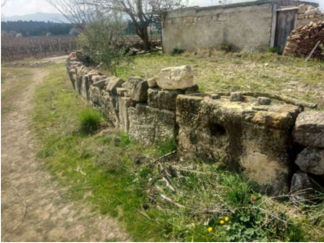
Fig. 33: Kırbyık, Köy Evinin Çevirme Duvarında Kullanılan Mimari Bloklar.
