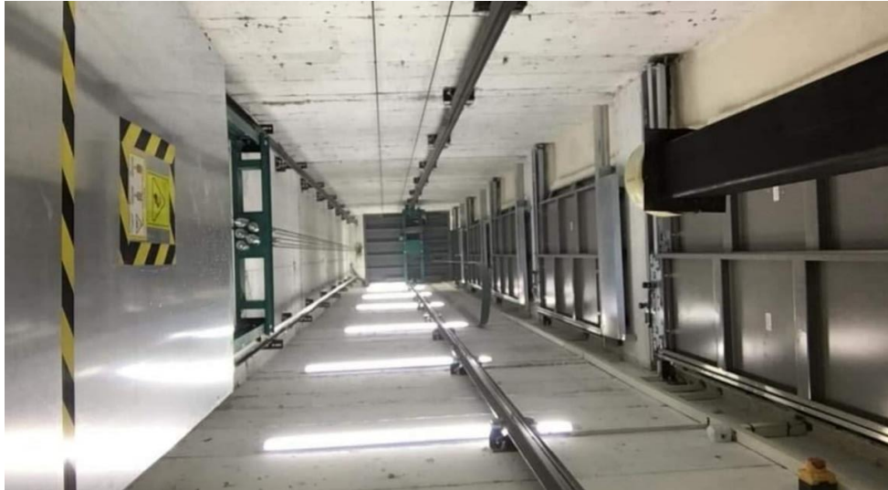
Şekil 2.3: Tamamen kapalı asansör kuyusu
