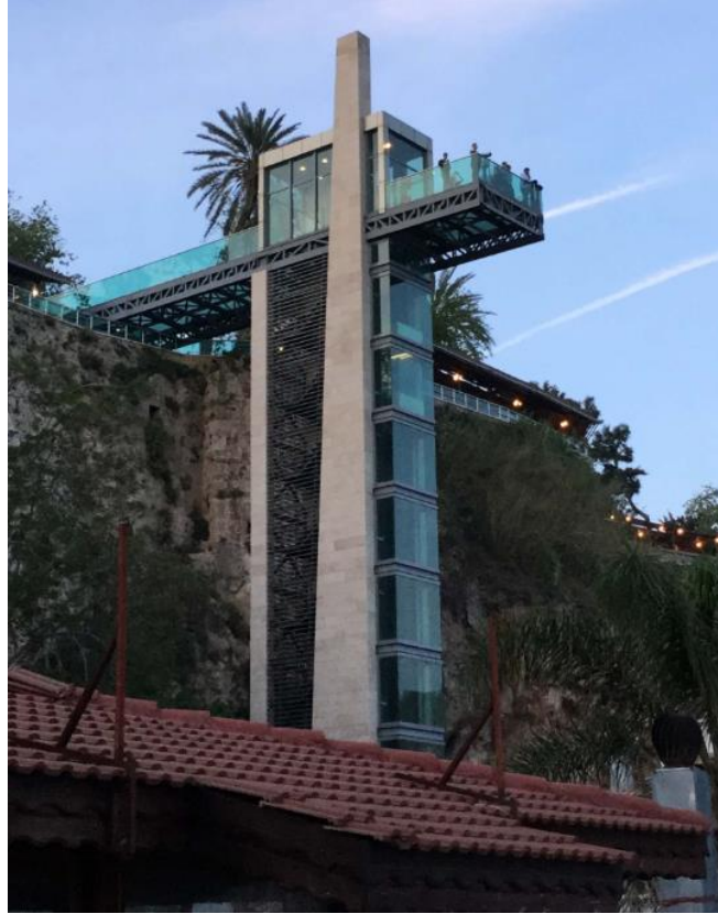
Şekil 2.5: Kısmi kapatılmış asansör kuyusu
