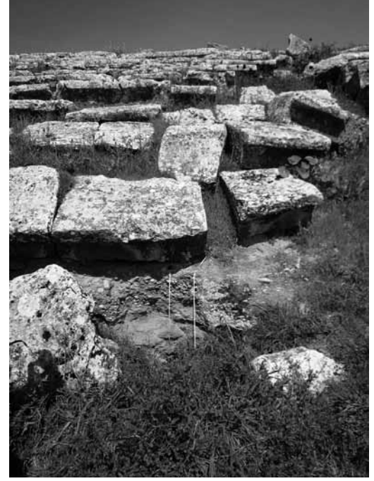
Fig. 15 Üst Cavea Konglomera Üzerine Yerleştirilen Oturma Basamaklarının Deprem Sonrası Durumları.
