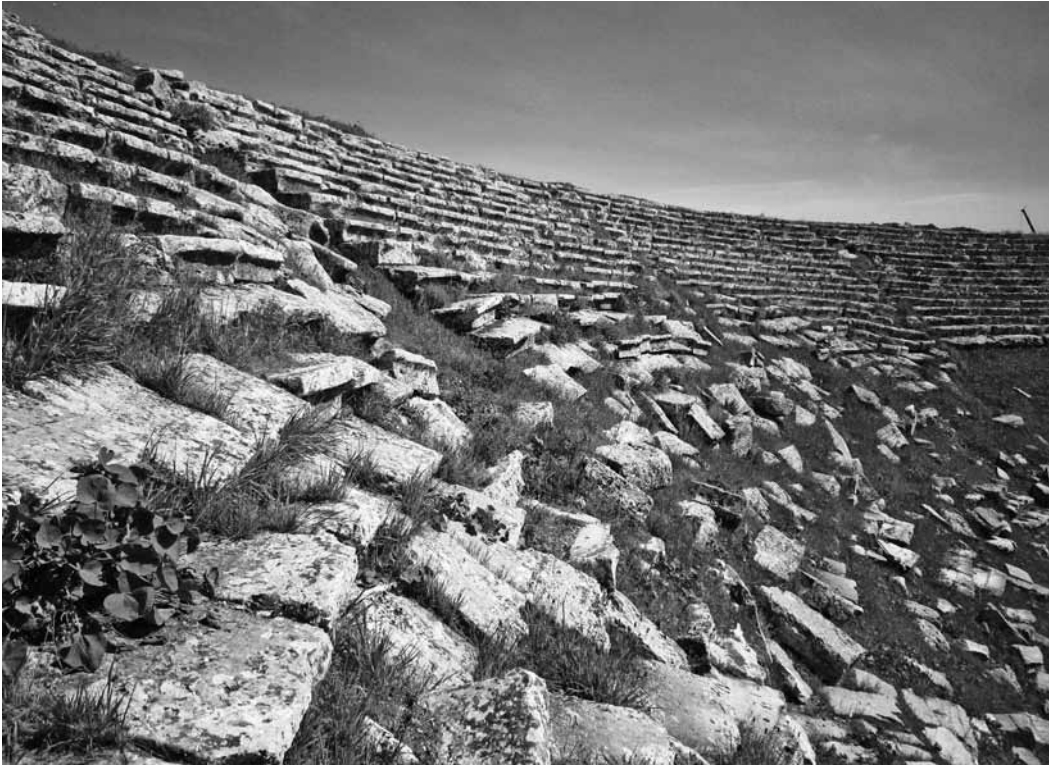
Fig. 8 Oturma Basamaklarında Deprem Sonrası OluŐan Kaymalar.
