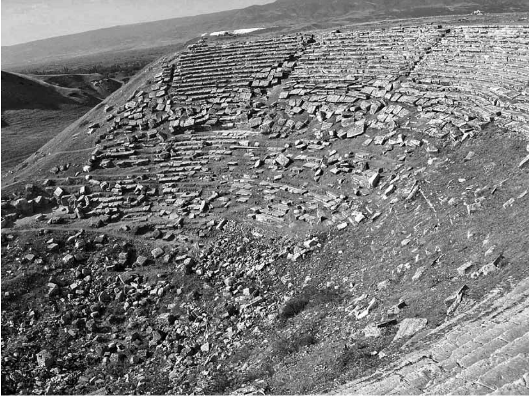
Fig. 7 Batı Tiyatrosu, Kuzeybatı Diazoma GeçiŐi ve Őst Cavea Oturma Basamaklarında Depremle Meydana Gelen Kaymalar.
