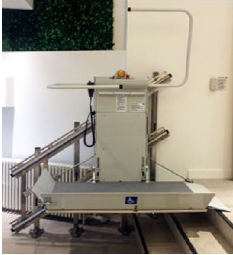
Şekil 2. 2: Merdiven tipi engelli platformu-2
