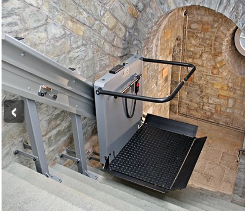
Şekil 2. 1: Merdiven tipi engelli platformu-1
