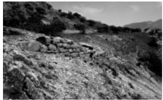
Resim 12: Güney yönde yer alan sur duvarı hattı.
