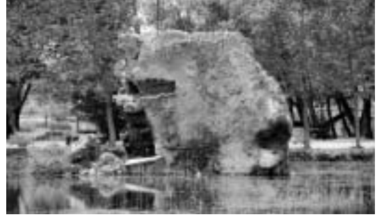
Resim 42: Işıklı kaynağından Roma kentine su sağlayan kule ve buna su aktaran dönme dolap sistemi.
