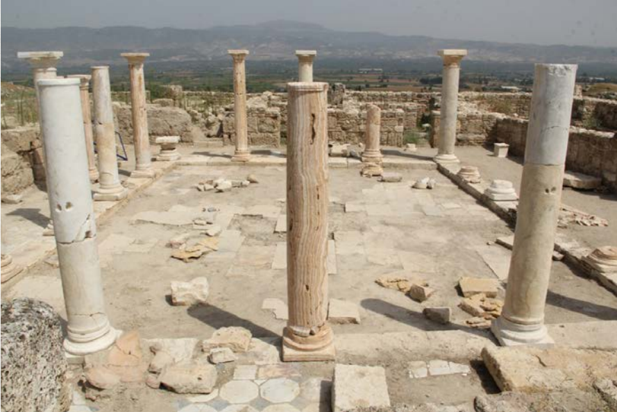
Resim 36 Kilseli Peristylli Ev, avlusunda yer alan taban döşemelerinin restorasyon öncesi durumu
