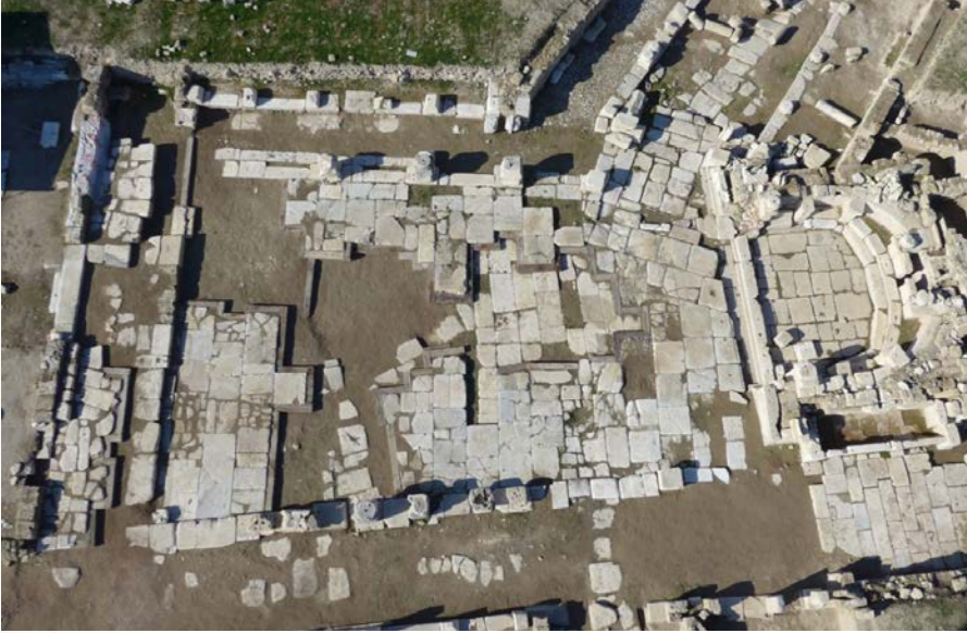
Resim 21 Traian Nymphaeumu Meydanı çalışmalar sonrası döşemelerin abşap traverslerle çevrelenmesi sonrası doğudan görünümü
