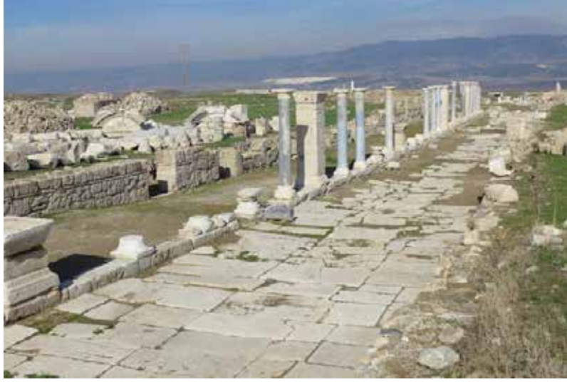
Resim 5: Stadyum Caddesi restorasyon çalışmaları sonrası durumu
