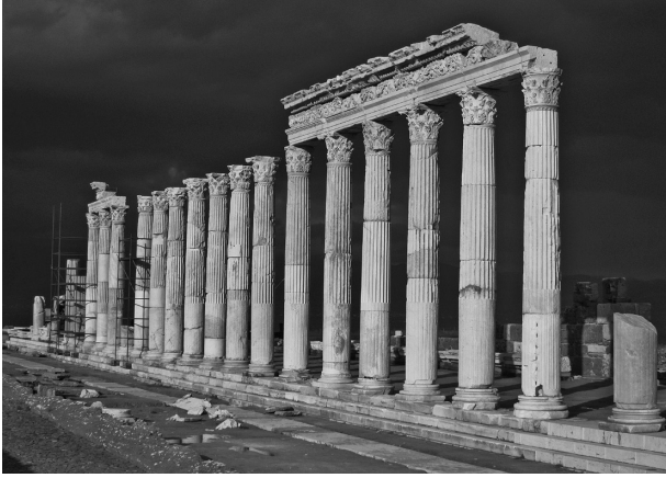
Res. 23 Kuzey (Kutsal) Agora Doğu Portik sütunlu galerisinin restorasyon sonrası durumu
