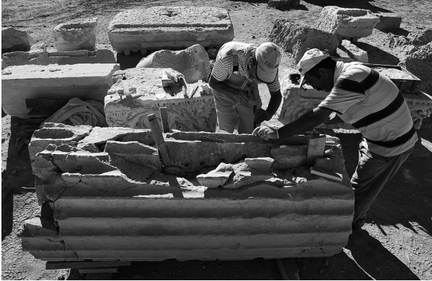
Res. 24 Kuzey (Kutsal) Agora Doğu Portiğine ait sütun tamburunda kırık parçalarının birleştirilmesine ve sağlamlaştırılmasına yönelik restorasyon çalışmaları
