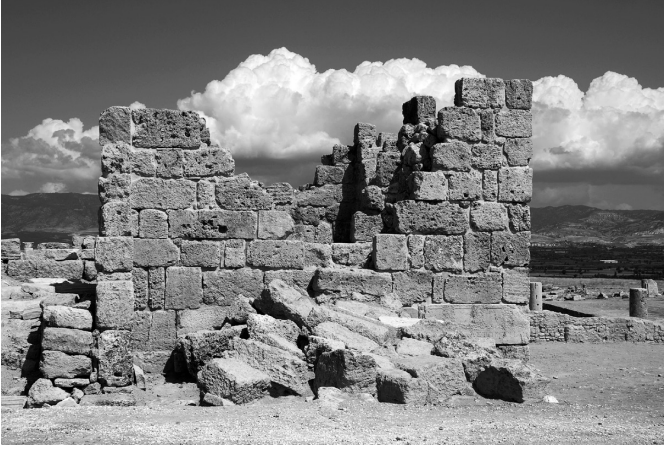
Res. 8 Restorasyon çalışması sonrası Güney Bizans Kulesi ve güney tarafında MS 7. yy başı depreminde yıkılan blokların in situ durumu
