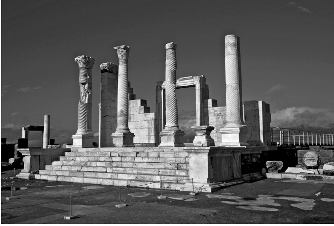
Res. 11 Tapınak A'nın yapılan restorasyon çalışması sonrası durumu
