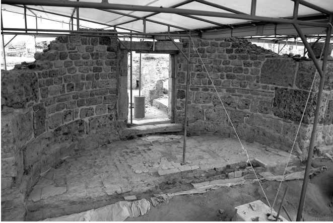
Res. 18 Güneydoğu apsiste yer alan opus sectile ve döşemenin restorasyon öncesi durumu
