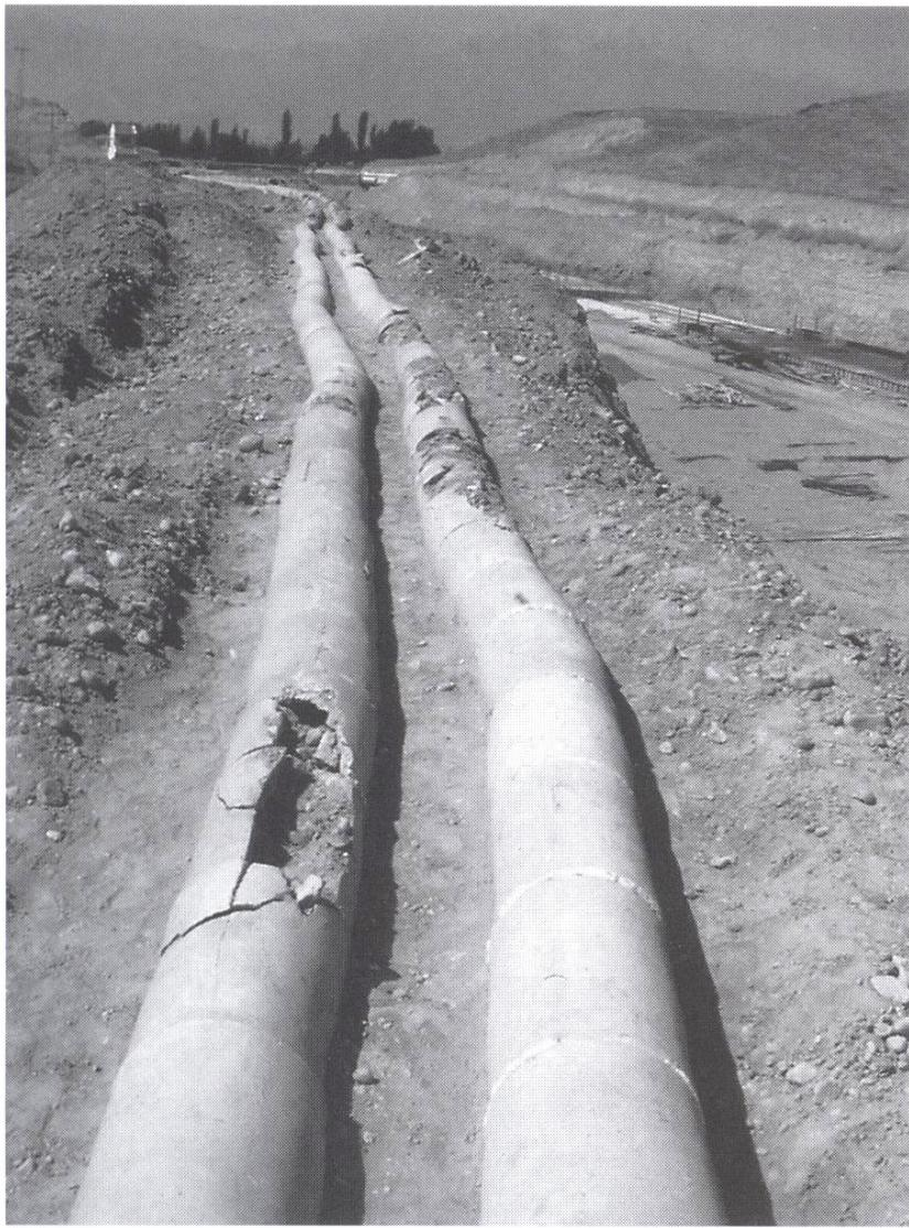
Abb. 3. Im Gelände der Wasserkläranlage von Denizli freigelegte Zwillingsleitung aus Tonrohren.
