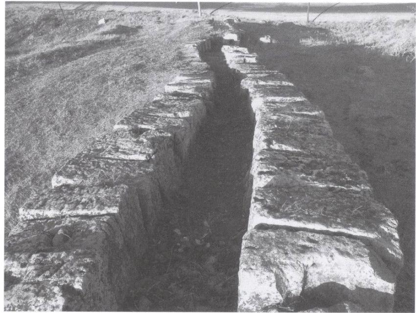
Abb. 6. Die Zwillingsleitung aus Travertinrohren des Aquäduktes von Laodikeia.
