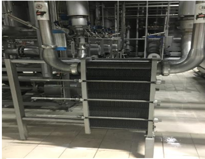
Őekil 3. 4: Plakalı ısı deĐiŐtirici (st alım)
