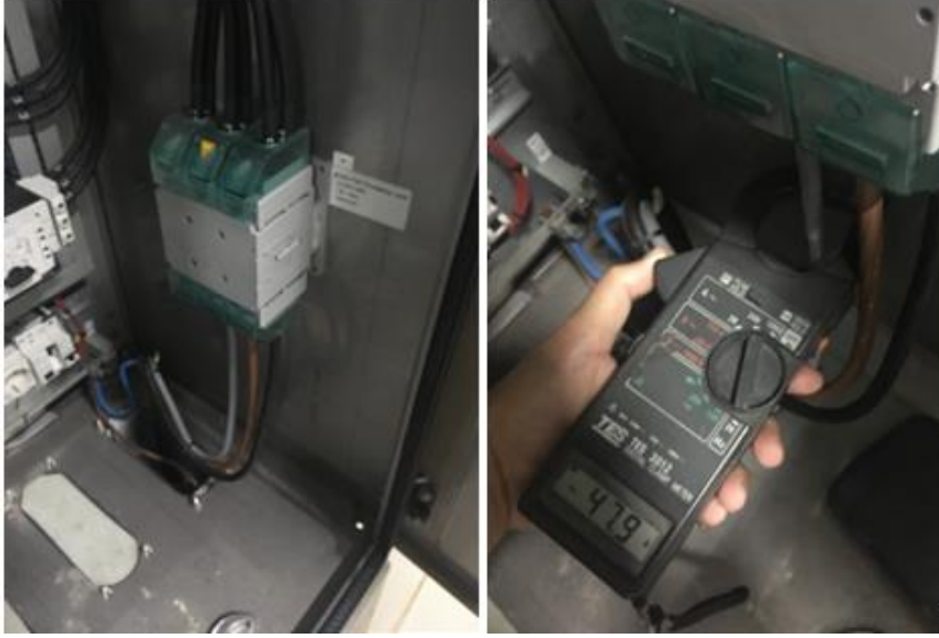
Şekil 4. 5: Pastörizasyon ünitesi pens ampermetre ile elektrik ölçümü
