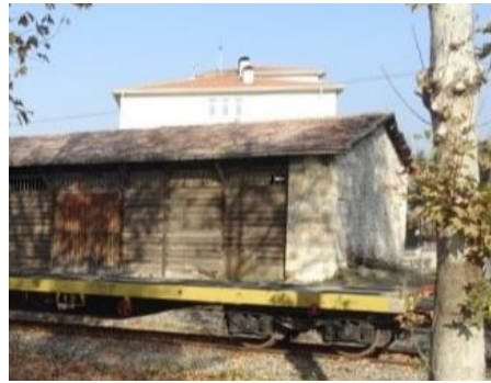
Foto 37: Sarayköy istasyonu depo yapısı kuzey cephesi.
