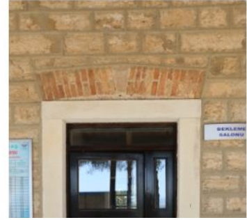
Foto 66: Goncalı istasyon binası tuğla kemer detayı.
