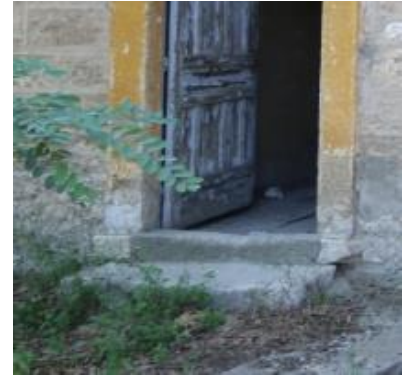
Foto 128: Böceli İstasyonu, İşçi Barakası ve Lojmanı, kapı basamağı detayı.
