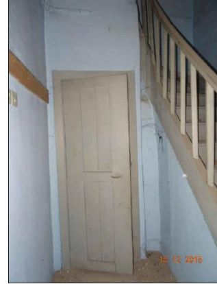
Foto 58: Sarayköy istasyonu konut yapısı, Hol 1 mekânının doğu duvarı.
