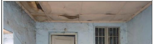
Foto 46: Sarayköy istasyonu konut yapısı 4 no.lu mekânın tavan detayı.
