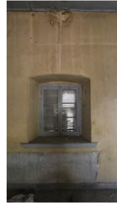
Foto 144: Böceli İstasyonu, İşçi Barakası ve Lojman Binası, 4 no.lu mekân kuzeybatı duvarı.
