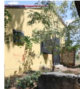
Foto 238: Bozkurt İstasyon Binası, batı cephesi.
