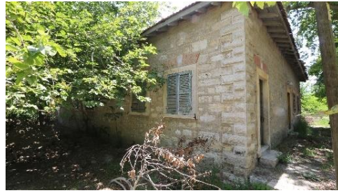
Foto 133: Böceli istasyonu, İşçi Barakası ve Lojmanı, kuzey cephe detayı.
