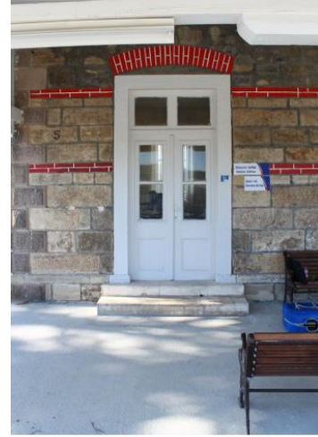
Foto 210: Kaklık İstasyon Binası, 1.nolu mekân girişi.
