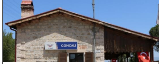
Foto 70: Goncalı istasyon binası kuzeybatı cephe detayı.
