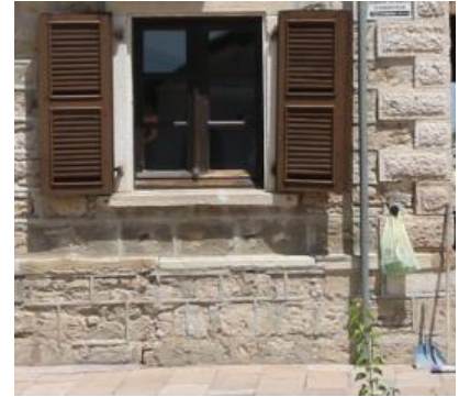
Foto 68: Goncalı istasyon binası kuzeybatı cephe detayı.
