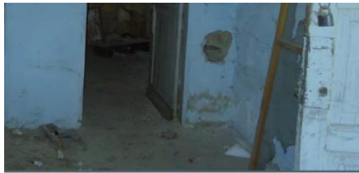
Foto 45: Sarayköy istasyonu konut yapısı 4 no.lu mekânın görüntüsü.
