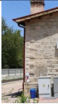
Foto 71: Goncalı istasyon binası cephe detayı.
