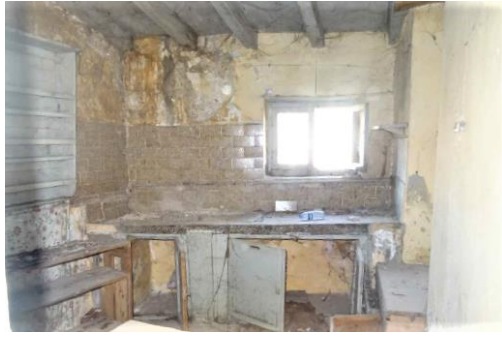
Foto 57: Sarayköy istasyonu konut yapısı 9 no.lu mekânın tavan döşemesi.
