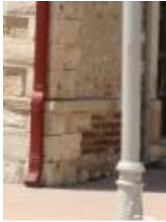
Foto 77: Goncalı istasyon binası güneydoğu cephe detayı.
