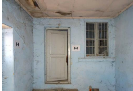
Foto 49: Sarayköy istasyonu konut yapısı 4 no.lu mekânın kuzey duvarı.
