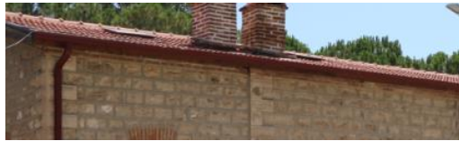
Foto 79: Goncalı istasyon binası kuzeydoğu cephe detayı.
