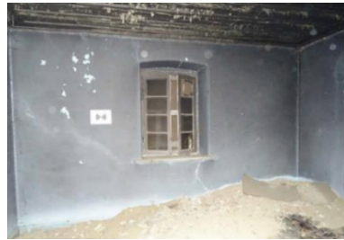
Foto 43: Sarayköy istasyonu konut yapısı 1 no.lu mekânın kuzey duvarı.
