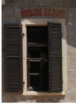
Foto 93: Goncalı istasyonu, lojman binası, güneydoğu cephedeki pencere detayı.
