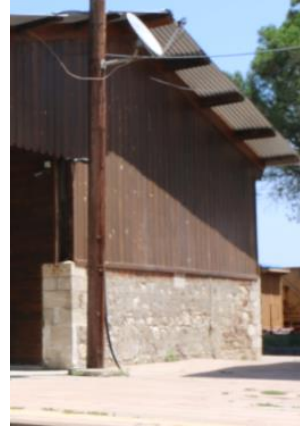
Foto 88: Goncalı istasyonu hangar binası, güneydoğu cepheden görüntü.
