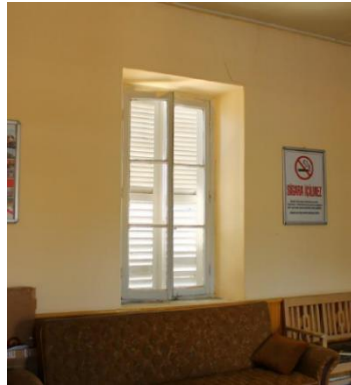
Foto 219: Kaklık İstasyon Binası, 3 nolu mekânın kuzeybatı duvarı.
