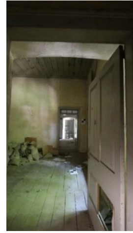
Foto 146: Böceli İstasyonu, İşçi Barakası ve Lojman Binası, 4 no'lu mekânın güneybatı duvarı.
