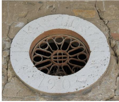
Foto 207: Kaklık İstasyon Binası, güneybatı cephe detayı.
