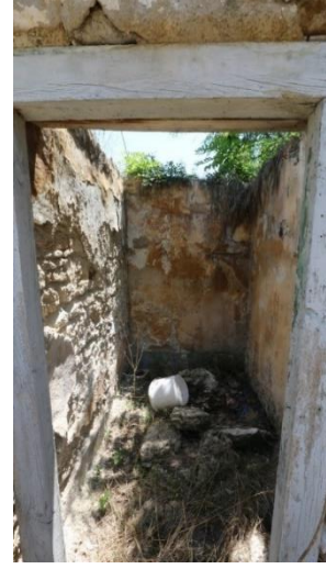
Foto 154: Böceli İstasyon Binası, İşçi Barakası ve Lojman Binası, 10 no.lu müştemilat yapısı.
