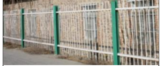
Foto 18: Sarayk y istasyonu lojman binası kuzey cephesi.
