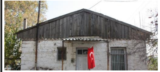
Foto 24: Sarayk y istasyonu lojman binası doęu cephesi.
