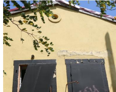
Foto 236: Bozkurt İstasyon Binası, batı cephe detayı.
