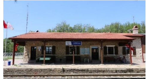
Foto 62: Goncalı istasyon binası kuzeydoğu cephe.
