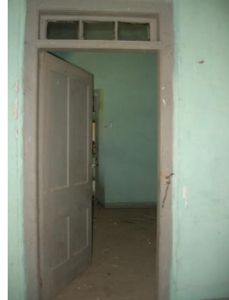
Foto 190: Kocabaş İstasyon Binası, 4 nolu mekânın batı duvarı.
