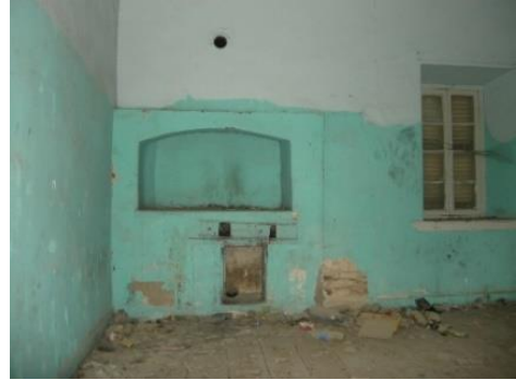
Foto 264: Çivril İstasyon Binası, ocak nişi.
