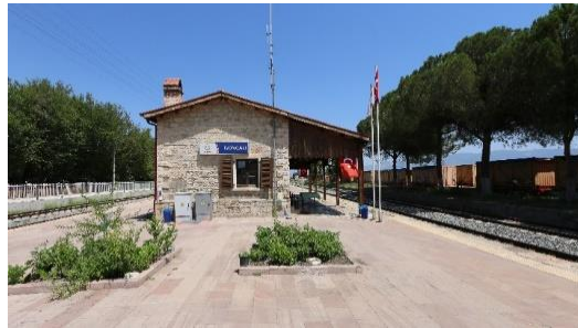
Foto 61: Goncalı istasyon binası, güneydoğu cephesi.
