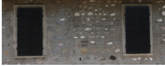
Foto 95: Sarayköy istasyonu lojman binası kuzeydoğu cephedeki pencere detayı.
