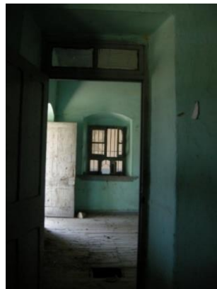
Foto 185: Kocabaş İstasyon Binası, 3 nolu mekânın batı duvarı.
