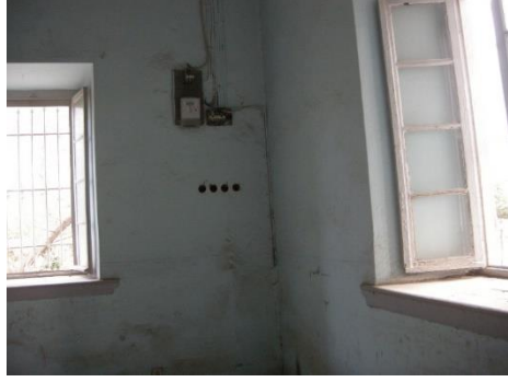
Foto 267: Çivril İstasyon Binası, pencere detayı.
