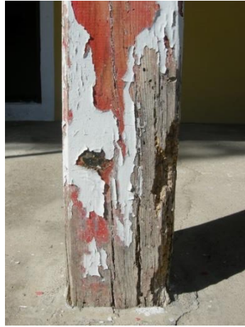
Foto 247: Çardak İstasyon Binası, güney cephede yer alan sundurmanın taşıyıcı detayı.
