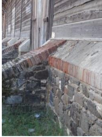
Foto 41: Sarayköy istasyonu depo yapısı güney cephesi detayı.
