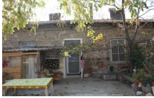
Foto 19: Sarayk y istasyonu lojman binas  g ney cephesi.
