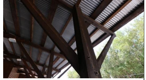
Foto 82: Goncalı istasyonu hangar binası, üst örtü detayı.
