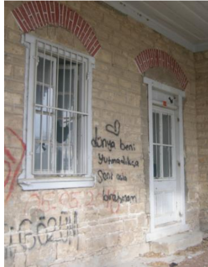
Foto 265: Çivril İstasyon Binası, güney cephesi.
