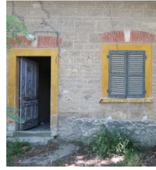
Foto 126: Böceli İstasyonu, İşçi Lojmanı ve Barakası, kapı ve pencere detayı.
