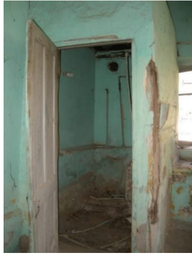
Foto 193: Kocabaş İstasyon Binası, 5 nolu mekân, banyo mekânı.
