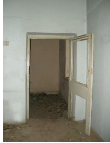
Foto 260: Çivril İstasyon Binası, 4 nolu mekâna geçişi sağlayan kapı.
