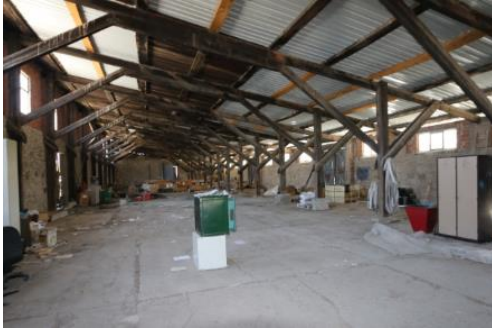
Foto 227: Kaklık İstasyonu Hangar Yapısı, üst örtüsü.
