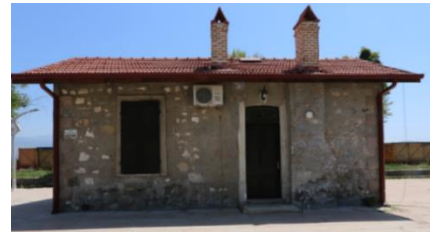
Foto 92: Goncalı istasyonu lojman binası, güneybatı cephe, kapı ve pencere detayı.
