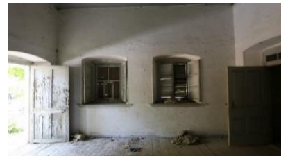
Foto 136: Böceli istasyonu, İşçi Barakası ve Lojman Binası, 1 no'lu mekânın kuzeybatı duvarı.
