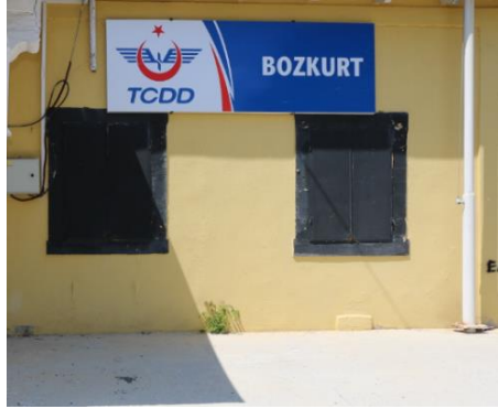
Foto 233: Bozkurt İstasyon Binası, pencere detayı.
