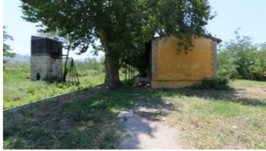
Foto 101: Böceli istasyon binası kuzeybatı cephe detayı.
