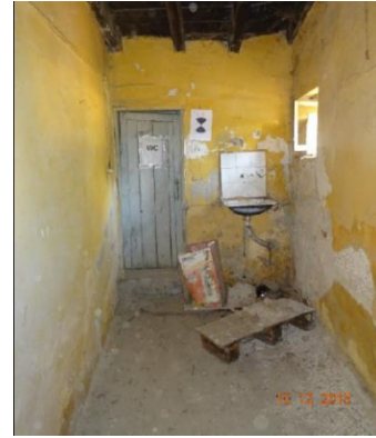
Foto 54: Sarayköy istasyonu konut yapısı 7 no.lu mekânın güney duvarı.
