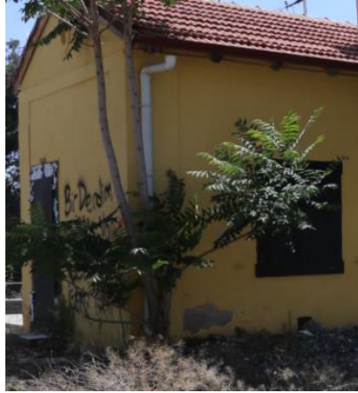
Foto 231: Bozkurt İstasyon Binası, cephe detayı.
