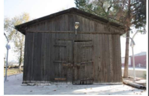
Foto 30: Sarayk y istasyonu ahşap depo yapısı doęu cephesi.
