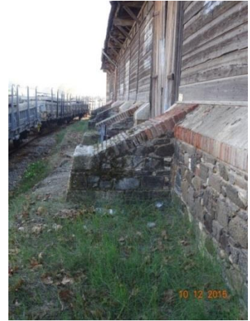
Foto 42: Sarayköy istasyonu depo yapısı güney cephe detayı.
