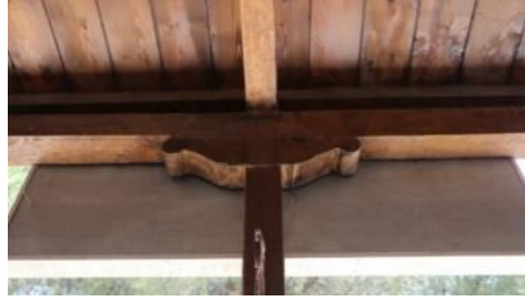
Foto 63: Goncalı İstasyon Binası sundurma detayı.
