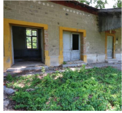
Foto 104: Böceli istasyon binası kapı ve pencere detayı.
