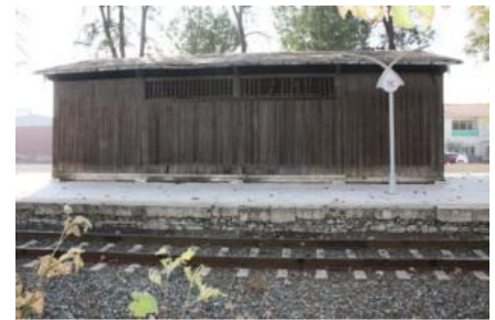
Foto 28: Sarayk y istasyonu ahşap depo yapısı kuzey cephesi.
