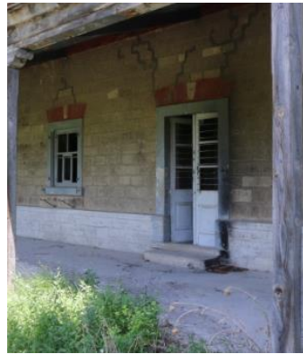
Foto 97: Böceli istasyon binası, kapı ve pencere detayı.
