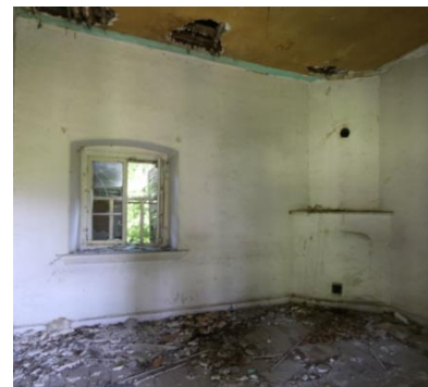
Foto 118: Böceli İstasyon Binası, 4 no.lu mekânın kuzeydoğu duvarı.
