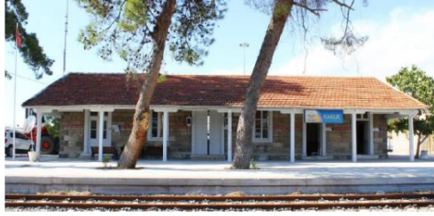
Foto 201: Kaklık İstasyon Binası, güneydoğu cephe.
