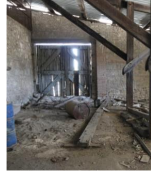
Foto 230: Kaklık İstasyonu, Hangar Yapısı, Güneybatıda yer alan girişin içten görünüşü.
