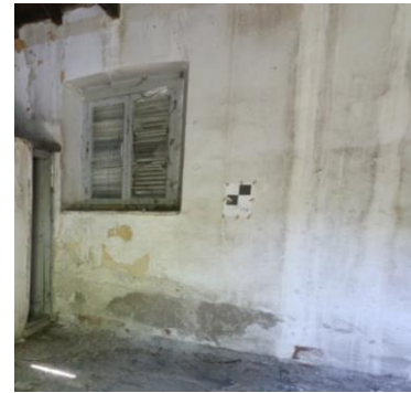
Foto 148: Böceli İstasyonu, İşçi Barakası ve Lojman Binası, 6 no.lu mekân, kuzeybatı duvarı.
