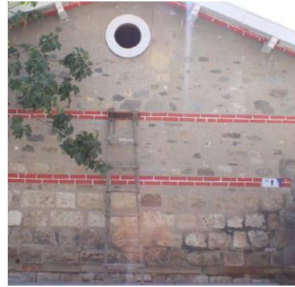
Foto 208: Kaklık İstasyon Binası, kuzeydoğu cephesi.
