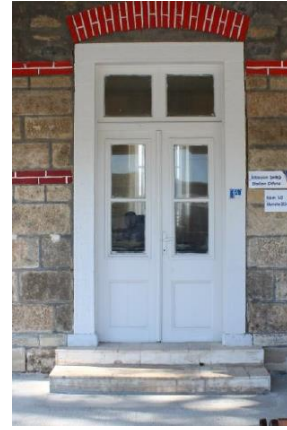
Foto 196: Kaklık İstasyon binası, kapı detayı.
