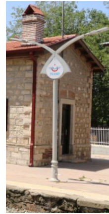
Foto 74: Goncalı istasyon binası güneydoğu cepheden görüntü.
