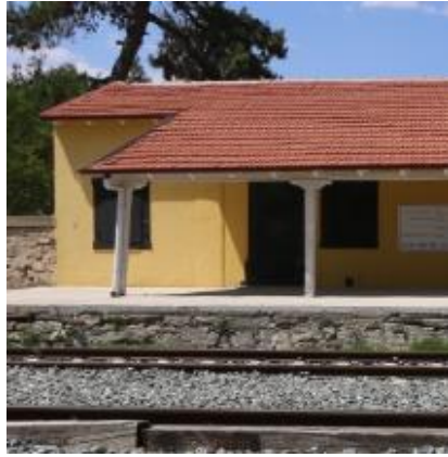
Foto 239: Bozkurt İstasyon Binası, güney cephesi.
