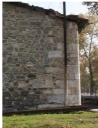
Foto 39: Sarayköy istasyonu depo yapısı batı cephe detayı.
