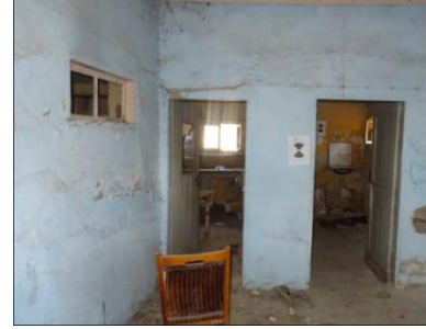
Foto 50: Sarayköy istasyonu konut yapısı 4 no.lu mekânın güney duvarı.
