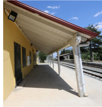
Foto 232: Bozkurt İstasyon Binası, güney cephe sundurması.
