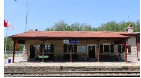
Foto 72: Goncalı istasyon binası Güneybatı cepheden görüntü.
