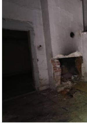
Foto 149: Böceli İstasyonu, İşçi Barakası ve Lojman Binası, 6 no.lu mekân, güneybatı duvarı.
