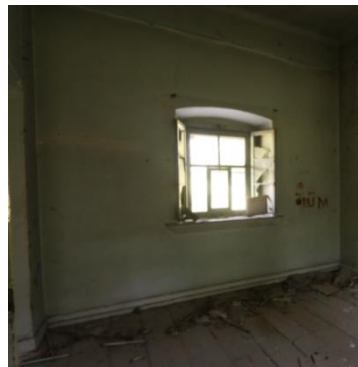
Foto 117: Böceli İstasyon binası, 3 no.lu mekânın güneybatı duvarı.
