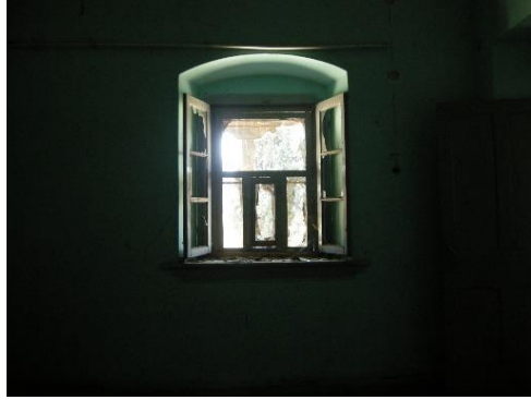
Foto 175: Kocabaş istasyon binası pencere detayı.
