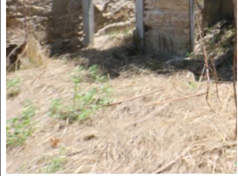
Foto 132: Böceli İstasyonu, İşçi Barakası ve Lojmanı, avlu zemini detayı.
