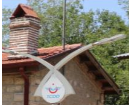
Foto 75: Goncalı istasyon binası güneydoğu cepheden görüntü.
