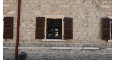
Foto 64: Goncalı İstasyon Binası pencere detayı.
