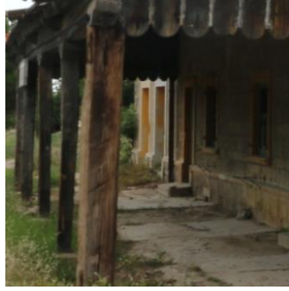
Foto 169: Kocabaş İstasyon Binası, güney cephe detayı.
