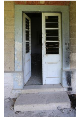
Foto 98: Böceli istasyon binası, kapı basamağı.
