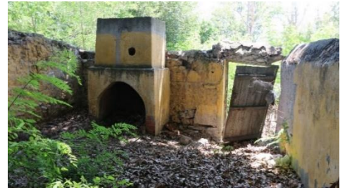
Foto 124: Böceli İstasyon Binası, avlunun güneydoğu duvarı.
