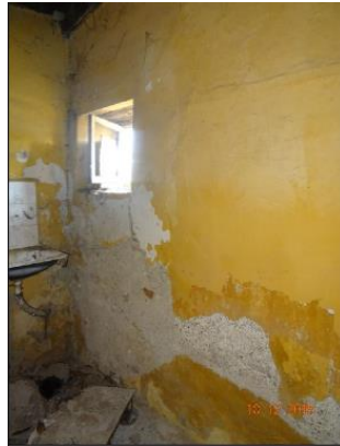
Foto 55: Sarayköy istasyonu konut yapısı 7 no.lu mekânın batı duvarı.
