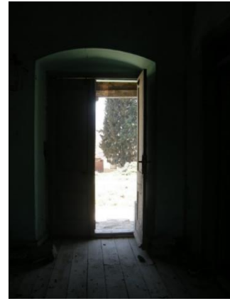
Foto 184: Kocabaş İstasyon Binası, 3 nolu mekân güney duvarı giriş açıklığı.
