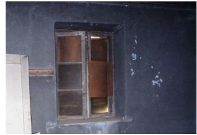
Foto 44: Sarayköy istasyonu konut yapısı 1 no.lu mekânın batı duvarı.
