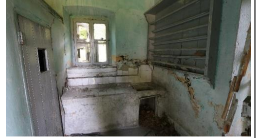
Foto 122: Böceli istasyon binası, 5 no.lu mekânın kuzeydoğu duvarı.
