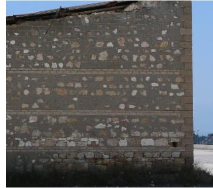
Foto 224: Kaklık İstasyonu Hangar Yapısı, cephe malzeme detay.
