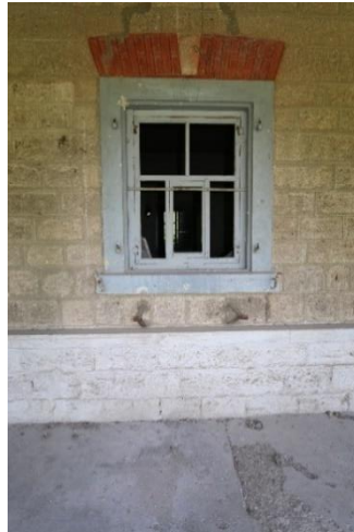
Foto 105: Böceli istasyon binası pencere detayı.
