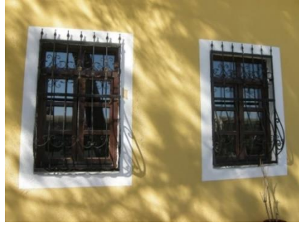
Foto 245: Çardak İstasyon Binası, cephe detayı.
