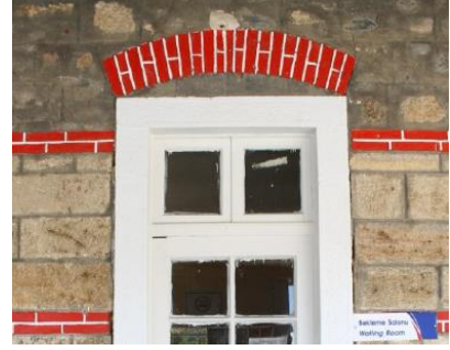
Foto 202: Kaklık İstasyon Binası, cephe malzeme genel detay.
