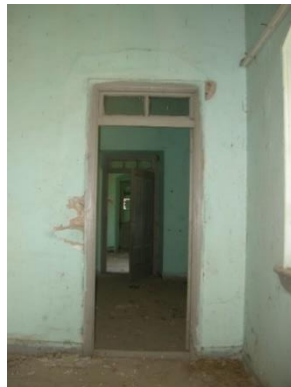
Foto 179: Kocabaş İstasyon Binası, 2 nolu mekânın doğu duvarı.
