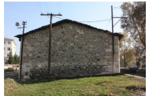
Foto 34: Sarayk y istasyonu depo yapısı doęu cephe g r nt s .
