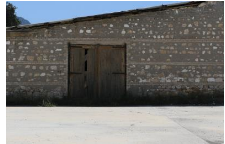
Foto 228: Kaklık İstasyonu Hangar Yapısı, Kuzeydoğu cephesi.
