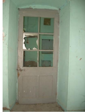
Foto 188: Kocabaş İstasyon Binası, 4 nolu mekânın doğu duvarı.
