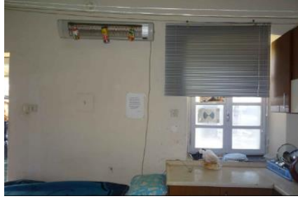
Foto 9: Sarayk y istasyon binası 1 no.lu mekânın batı cephesi
