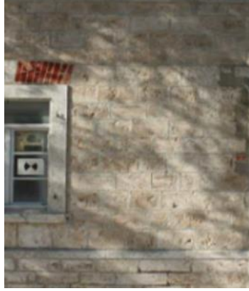
Foto 1: Sarayköy istasyon binası cephe detayı.
