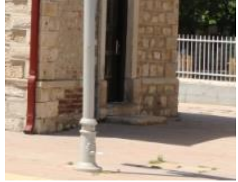
Foto 76: Goncalı istasyon binası güneydoğu cephe detayı.
