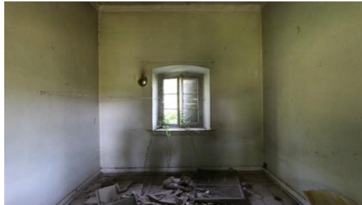
Foto 115: Böceli İstasyon Binası, 3 no.lu mekân, kuzeydoğu duvarı.
