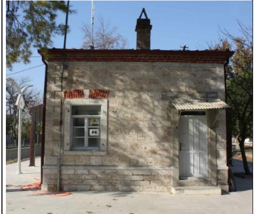
Foto 4: Sarayköy istasyon binası batı cephe detayı.
