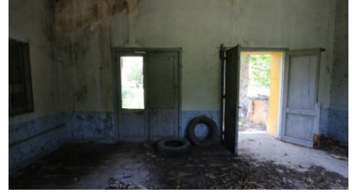
Foto 110: Böceli istasyon binası, 1 no.lu mekânın güneybatı duvarı.
