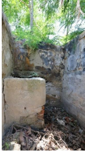
Foto 153 Böceli İstasyonu, İşçi Barakası ve Lojman Binası, 9 no.lu müştemilat yapısı.
