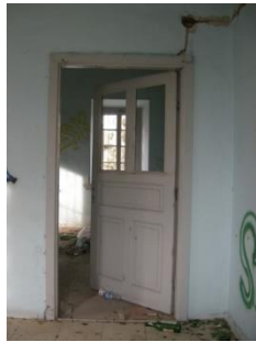
Foto 257: Çivril İstasyon Binası, 2 nolu mekâna açılan kapı.
