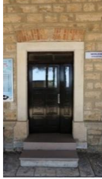
Foto 65: Goncalı istasyon binası kapı detayı.
