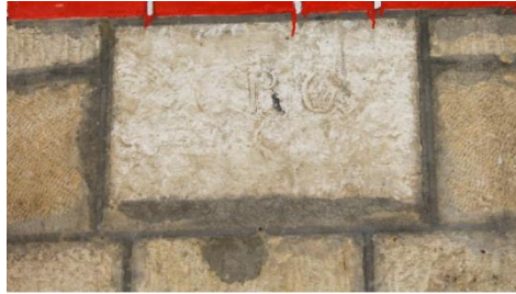
Foto 223: Kaklık İstasyon Binası, güneydoğu cephede yer alan ORC yazısı.
