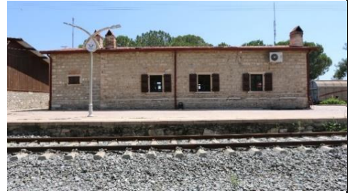
Foto 78: Goncalı istasyon binası kuzeydoğu cepheden görüntü.
