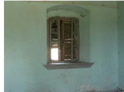
Foto 178: Kocabaş İstasyon Binası, 2 nolu mekânın kuzey duvarı.
