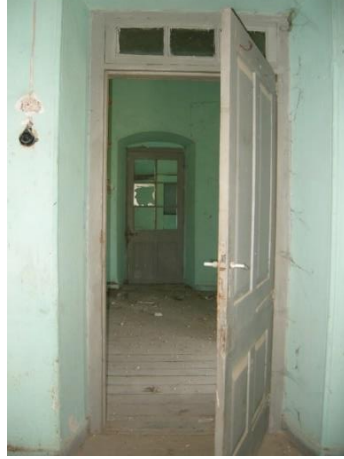
Foto 183: Kocabaş İstasyon Binası, 3 nolu mekân doğu duvarı.
