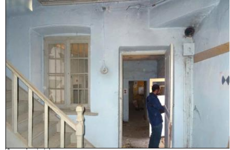
Foto 60: Sarayköy istasyonu konut yapısı, Hol 1 mekânının güneyde yer alan giriş ve pencere.
