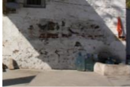
Foto 17: Sarayk y istasyonu lojman binası cephe ayrıntısı.
