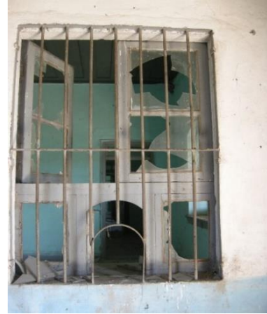
Foto 176: Kocabaş istasyon binası geniş penceresi detayı.
