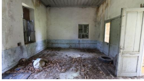
Foto 109: Böceli İstasyon Binası, 1 no.lu mekân, güneydoğu duvarı.
