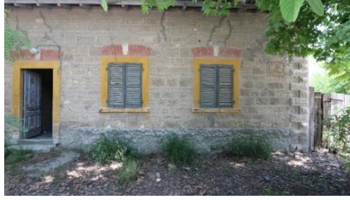
Foto 125: Böceli İstasyonu, İşçi Barakası ve Lojmanı, cephe detayı.
