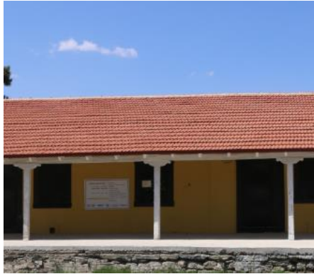
Foto 235: Bozkurt İstasyon Binası, üst örtüsü.
