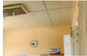
Foto 200: Kaklık İstasyon Binası, tavan döşemesi detayı.
