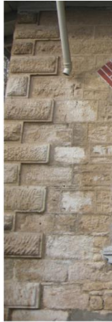
Foto 255: Çivril İstasyon Binası, cephe detayı.
