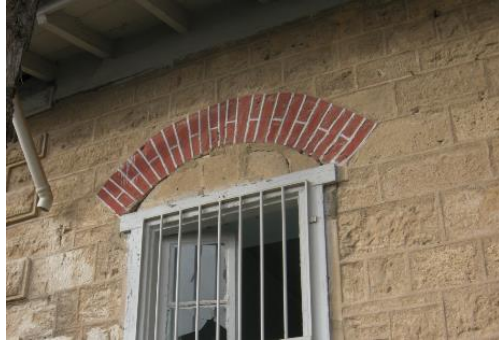
Foto 253: Çivril İstasyon binası keme detayı.
