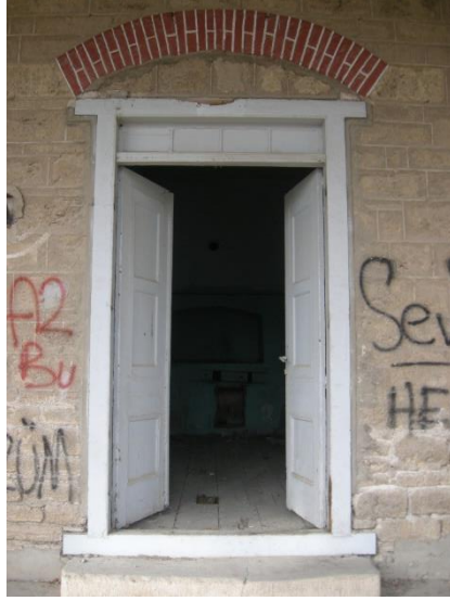
Foto 263: Çivril İstasyon Binası, 5 nolu mekana geçişi sağlayan kapı.
