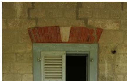
Foto 107: Böceli istasyon Binası, Güneybatı cephede yer alan pencere
