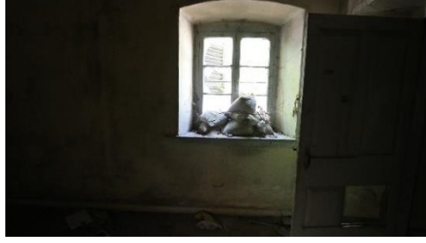
Foto 141: Böceli İstasyonu, İşçi Barakası ve Lojman Binası, 3 no.lu mekânın kuzeybatı duvarı.
