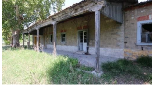
Foto 103: Böceli istasyon binası, güneybatı cephe detay.
