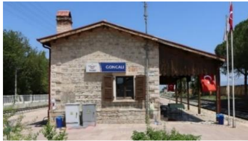
Foto 67: Goncalı istasyon binası kuzeybatı cephesi.
