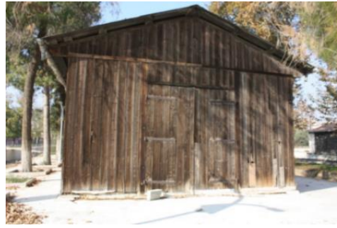
Foto 31: Sarayk y istasyonu ahşap depo yapısı, batı cephesi.
