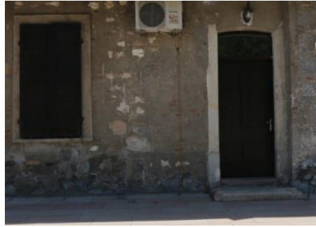
Foto 89: Goncalı istasyonu lojman binası, kapı ve pencere detayı.
