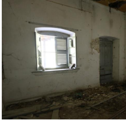
Foto 113: Böceli İstasyon Binası, 2 no.lu mekânın güneybatı duvarı.
