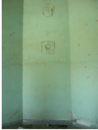
Foto 181: Kocabaş İstasyon Binası, 2 nolu mekânın kuzeybatı duvarı.
