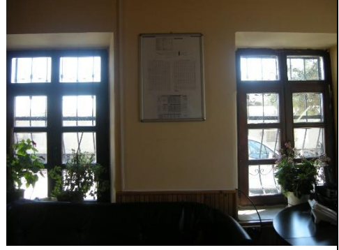
Foto 246: Çardak İstasyon Binası, istasyon şefliği (yazıhane), güney duvarı.
