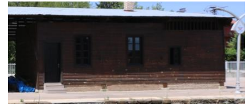
Foto 86: Goncalı istasyonu hangar binası, kapı ve pencere detayı.
