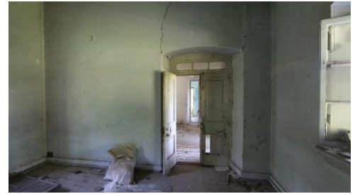
Foto 116: Böceli İstasyon binası, 3 no.lu mekânın güneydoğu duvarı.
