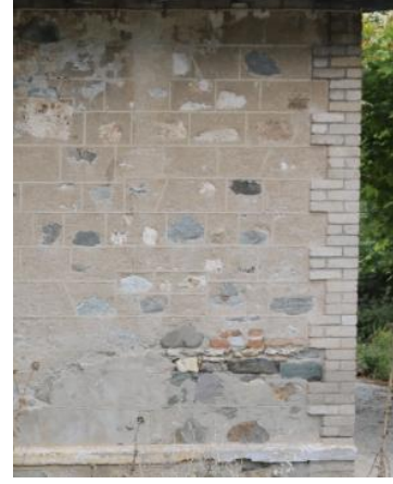
Foto 162: Kocabaş İstasyon Binası, cephe detayı.
