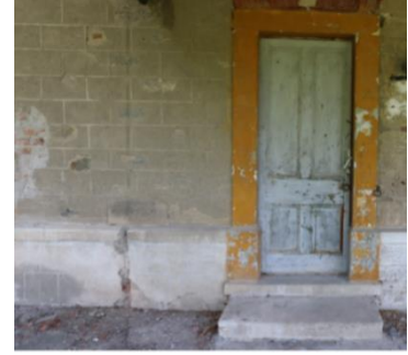
Foto 96: Böceli istasyon binası, cephe detayı.
