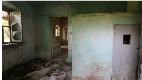
Foto 123: Böceli İstasyon binası, 5 no.lu mekânın kuzeybatı duvarı.
