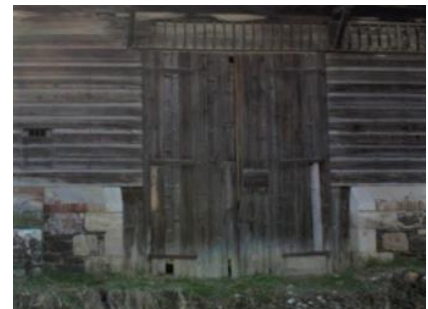
Foto 40: Sarayköy istasyonu depo yapısı güney cephe detayı.
