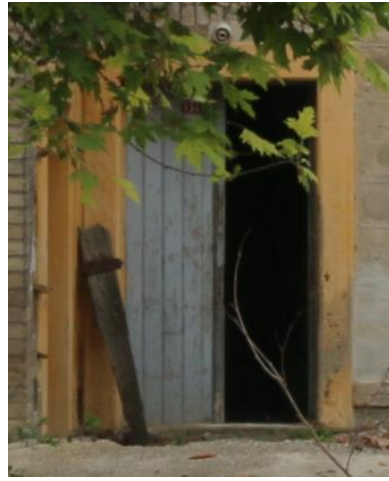
Foto 171: Kocabaş İstasyon Binası, doğu cephe girişi.
