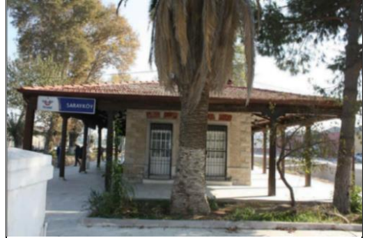
Foto 6: Sarayk y istasyon binası kuzey cephesi.
