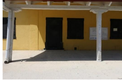
Foto 240: Bozkurt İstasyon Binası, güney cephesi.
