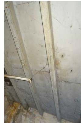
Foto 56: Sarayköy istasyonu konut yapısı 9 no.lu mekânın tavan döşemesi..
