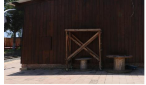
Foto 84: Goncalı istasyonu hangar binası, kuzeybatı cepheden görüntü.
