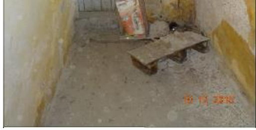
Foto 51: Sarayköy istasyonu konut yapısı 5 no.lu mekânın zemin döşemesi.
