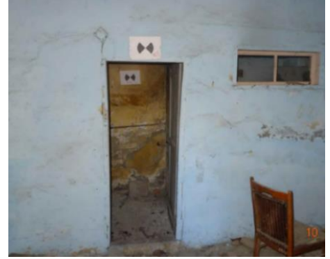
Foto 48: Sarayköy istasyonu konut yapısı 4 no.lu mekânın doğu duvarı.
