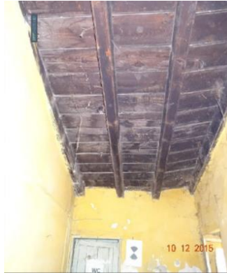
Foto 53: Sarayköy istasyonu konut yapısı 7 no.lu mekânın tavan döşemesi.
