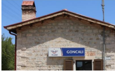
Foto 69: Goncalı istasyon binası kuzeybatı cephe detayı.
