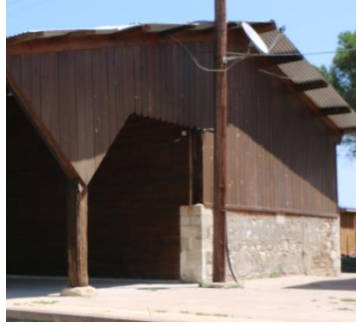
Foto 83: Goncalı istasyonu hangar binası, güneydoğu cepheden görüntü.
