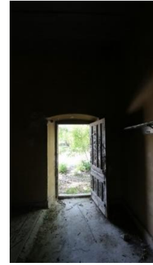
Foto 156: Böceli İstasyonu, İşçi Barakası ve Lojman Binası, 11 no.lu avlu mekânının kuzeybatı duvarındaki girişin içten görünüşü.
