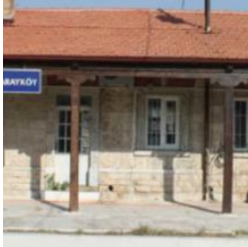
Foto 3: Sarayköy istasyon binası sundurma detayı.
