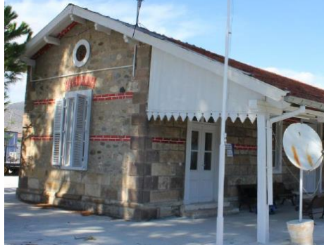
Foto 203: Kaklık İstasyon Binası, cephelerde yer alan çift sıra tuğla hatıl.
