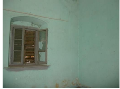
Foto 182: Kocabaş İstasyon Binası, 3 nolu mekân kuzey duvarı.
