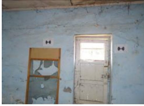
Foto 47: Sarayköy istasyonu konut yapısı 4 no.lu mekânın batı duvarı.
