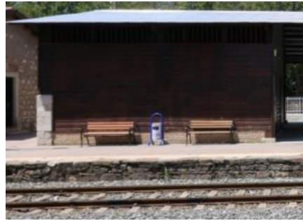
Foto 85: Goncalı istasyonu hangar binası, kuzeydoğu cepheden görüntü.
