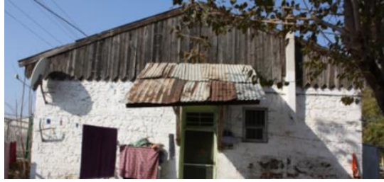
Foto 23: Sarayk y istasyonu lojman binası batı cephesi.
