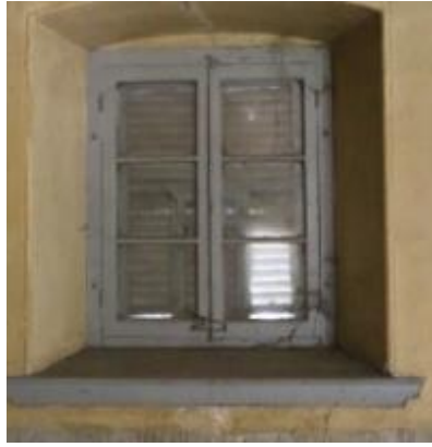
Foto 127: Böceli İstasyonu, İşçi Barakası ve Lojmanı, pencere detayı.
