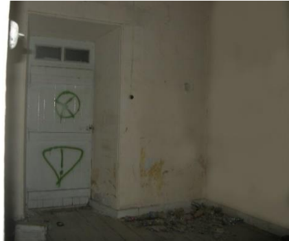
Foto 262: Çivril İstasyon Binası, 4 nolu mekânın kuzey duvarında yer alan giriş.
