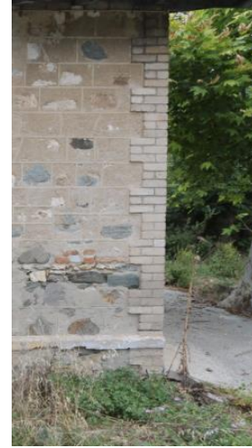
Foto 168: Kocabaş İstasyon Binası, cephe detayı .
