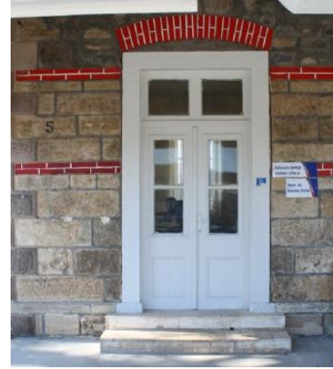
Foto 204: Kaklık İstasyon Binası, kapı genel detay.
