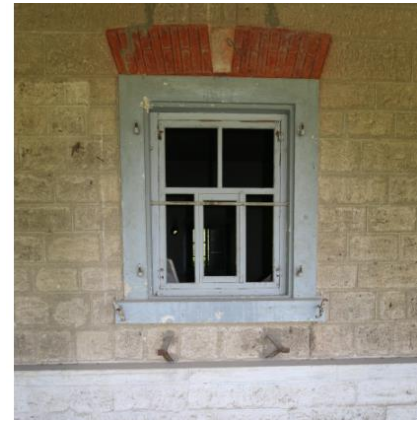
Foto 106: Böceli istasyon binası pencere detayı.
