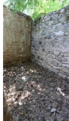
Foto 152: Böceli İstasyonu, İşçi Barakası ve Lojman Binası, 8 no.lu müştemilat yapısı.
