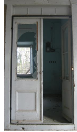
Foto 254: Çivril İstasyon Binası kapı detayı.
