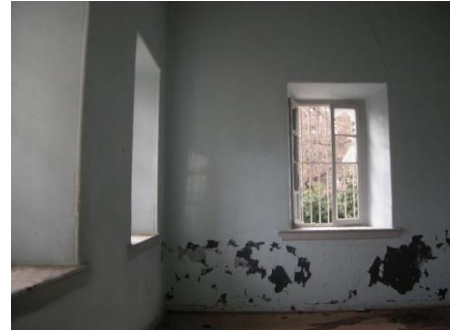
Foto 256: Çivril İstasyon Binası, güney ve batı duvarı.
