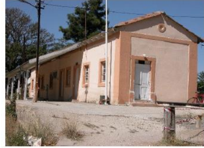
Foto 234: Bozkurt İstasyon Binası, kapı ve pencere detayı (Özyiğit, 2007).
