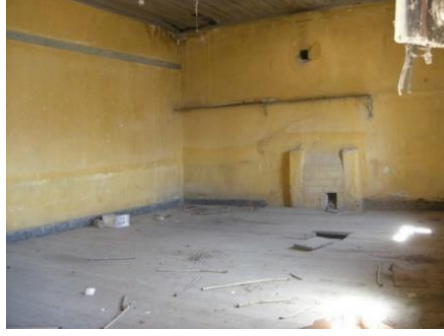
Fotoğraf 165: Kocabaş İstasyon Binası 1 no.lu mekânın görüntüsü.
