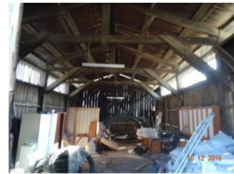
Foto 26: Sarayk y istasyonu ahşap depo yapısı tavan ayrıntısı.
