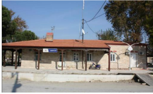
Foto 5: Sarayk y istasyon binası kuzey cephesi.
