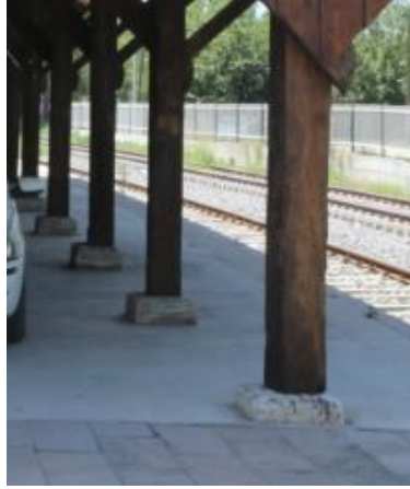
Foto 87: Goncalı istasyonu hangar binası, taşıyıcı detayı.
