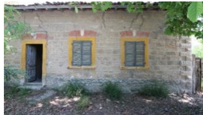
Foto 135: Böceli İstasyonu, İşçi Barakası ve Lojman Binası, güneybatı cephe, kapı ve pencere detayı.
