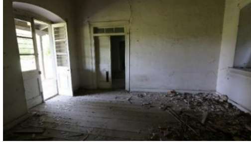
Foto 121: Böceli istasyon binası, 4 no.lu mekânın kuzeybatı duvarı.
