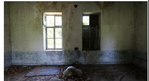
Foto 108: Böceli İstasyon Binası 1 no'lu mekân, kuzeydoğu duvarı.
