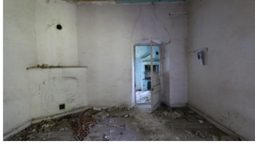
Foto 119: Böceli İstasyon Binası, 4 no.lu mekânın güneydoğu duvarı.
