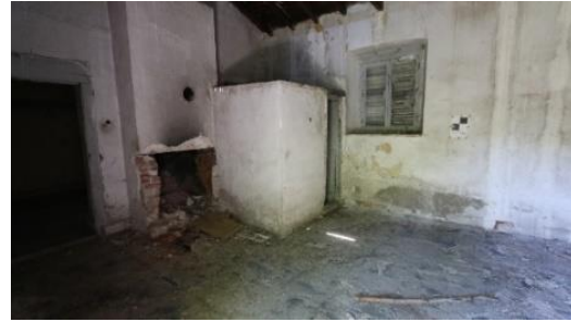
Foto 147: Böceli istasyonu, İşçi Barakası ve Lojman Binası, 6 no.lu mekân güneybatı duvarı.
