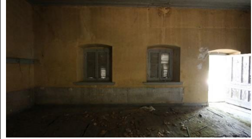
Foto 140: Böceli İstasyonu, İşçi Barakası ve Lojman Binası, 2 no.lu mekânın güneybatı duvarı.
