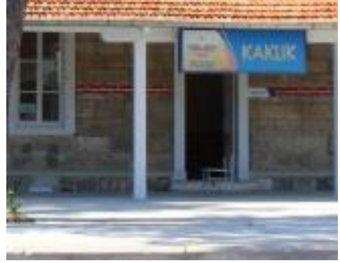
Foto 218: Kaklık İstasyon Binası, 3 no.lu mekânın girişi.
