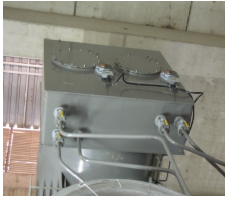
Şekil 7.14: Kademe ile domların ortak genişleme deposu
