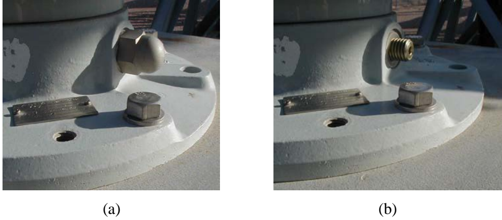
Şekil 7.9: (a) Buşing tap kapağı kapalı ve (b) açık durumları
