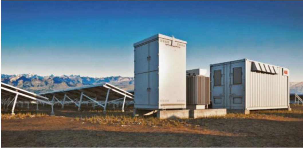
Şekil 3.11: Merkezi evirici (ABB, 2018 a )
