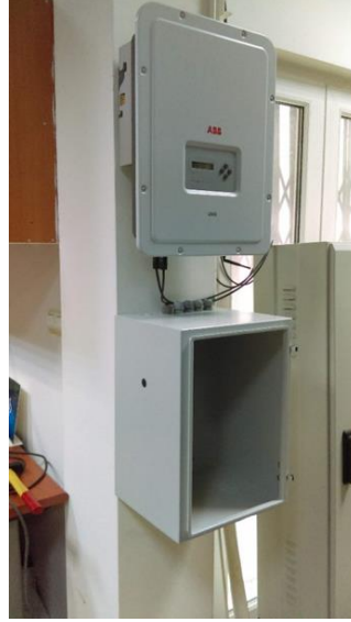
Şekil 5.1: FV santral evirici ünitesi ve şebeke entegrasyon panosu
