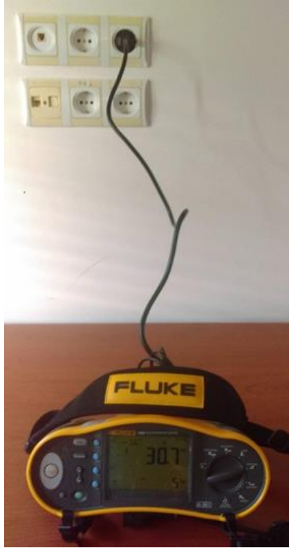
Şekil 5.12: Kaçak akım rölesi testi için elektriksel tesisat test cihazının tesisi
