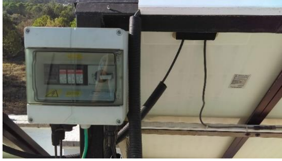
Şekil 4.5: FV panel grubu çıkışındaki SPD kutusu
