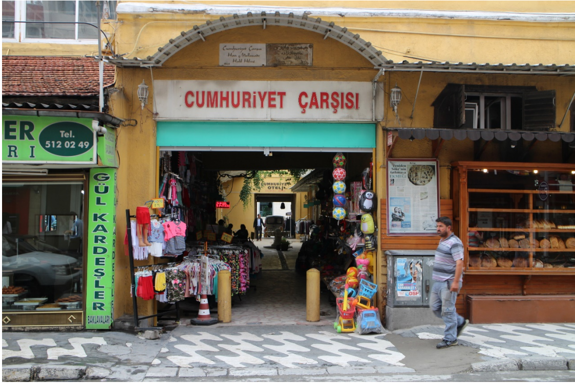
Fot. 286: Cumhuriyet Hanı Güney Cephe Kapı Açıklığı Görünümü.
