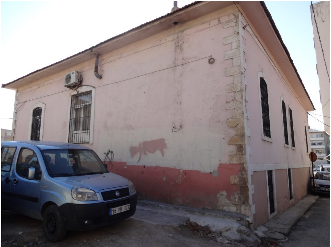
Fot. 269: Doğu Cephe Görünümü.
