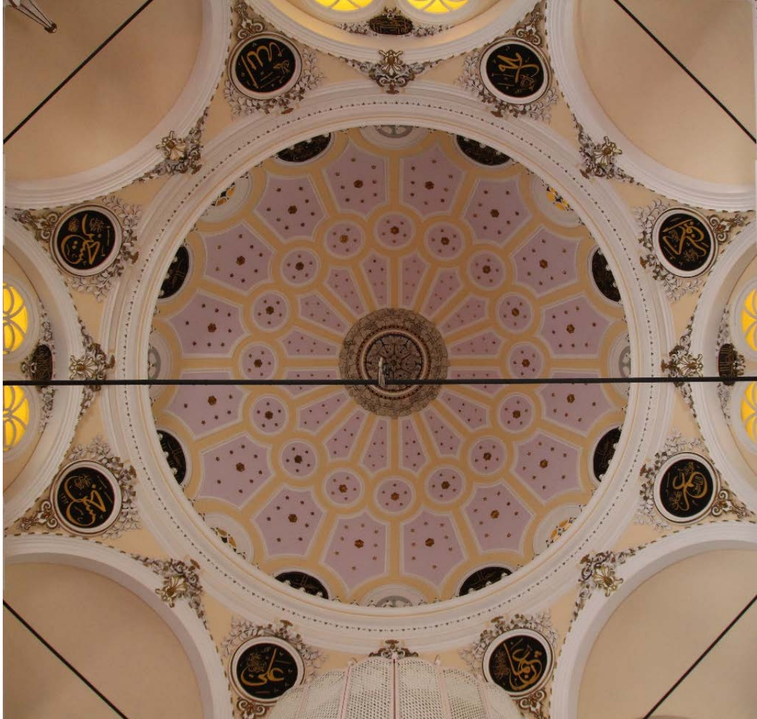
Fot. 151: Kubbe Geçiş Elemanları Görünümü.
