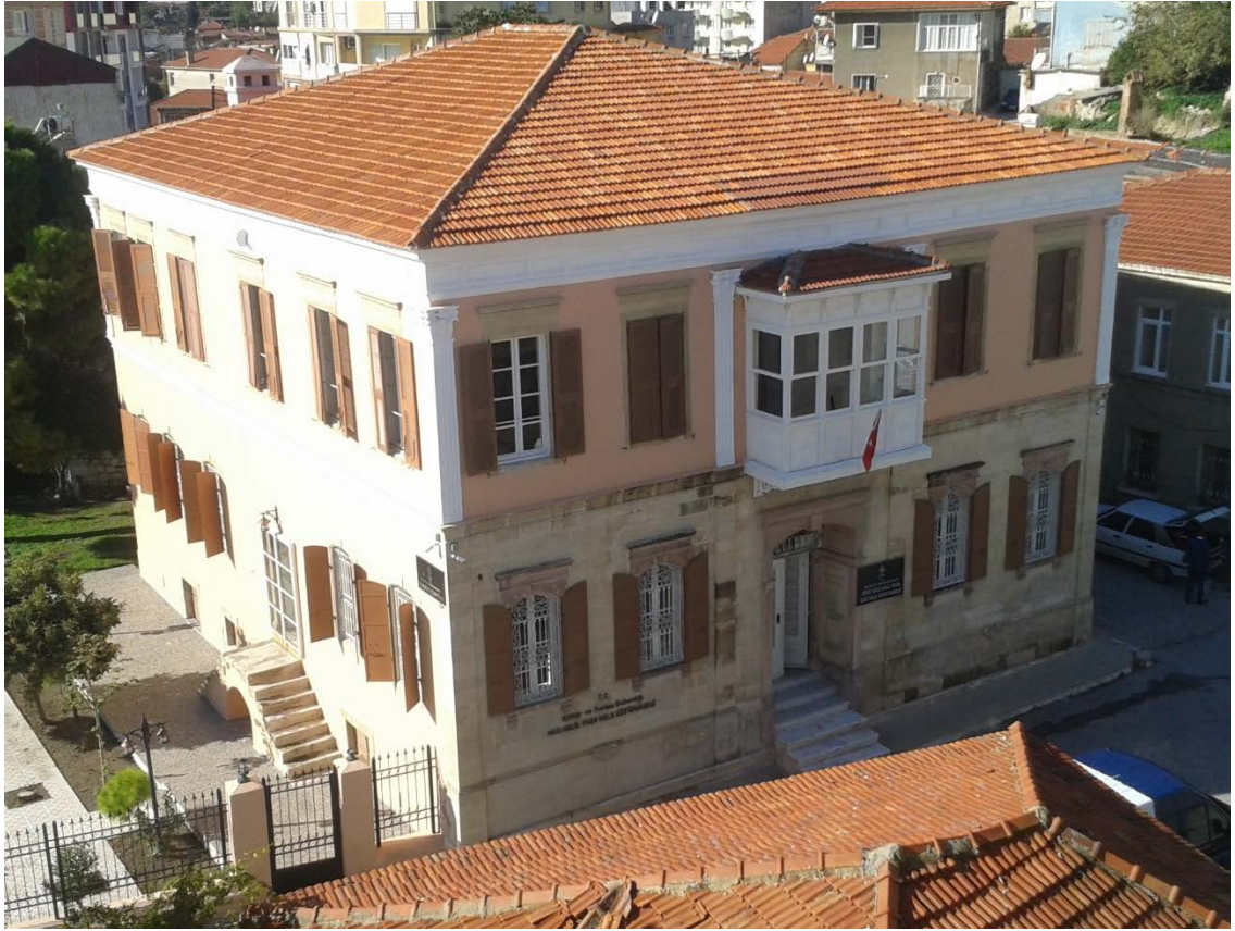
Fot. 186: Kuzeydoğu Cephe Görünümü.
