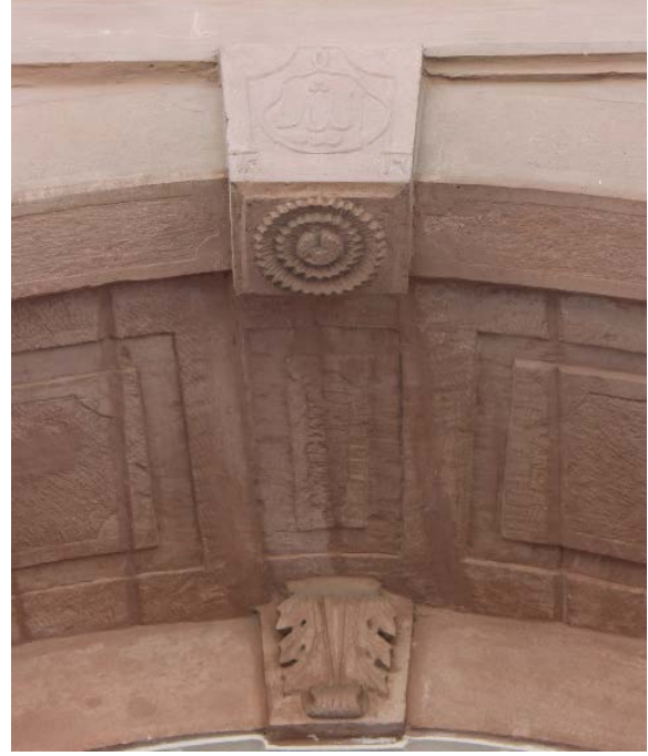
Fot. 188: Kapı Açıklığı Yüzeyindeki Bitkisel Süslemeler.
