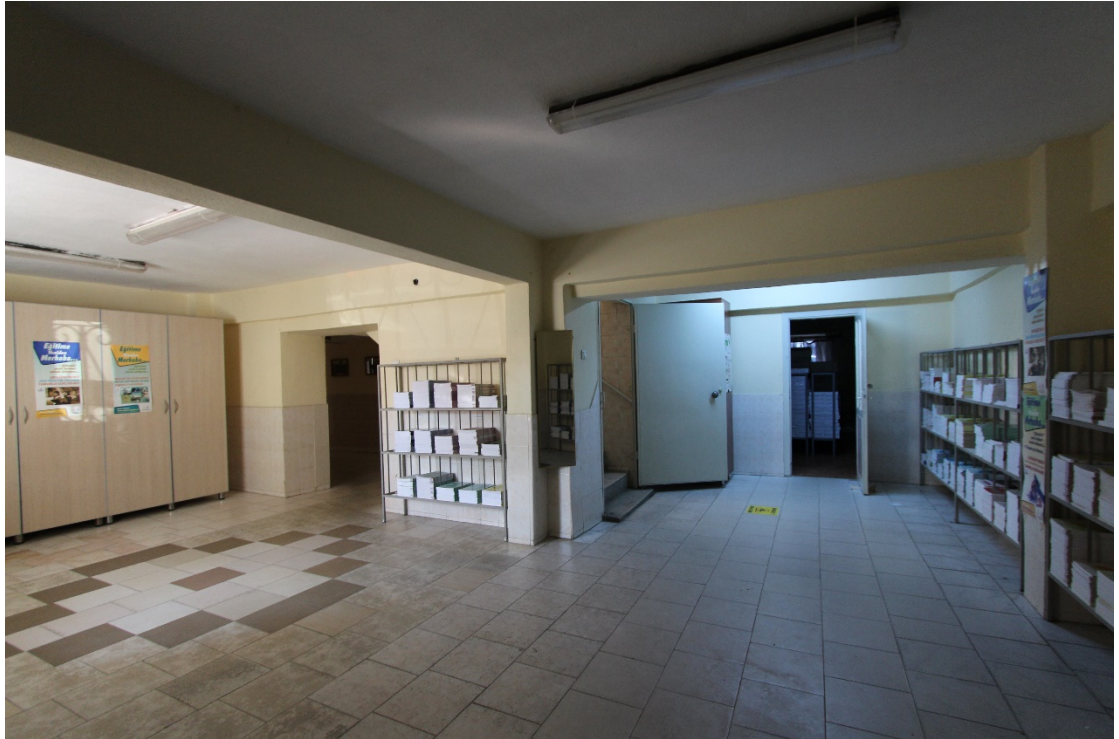
Fot. 274: Bodrum Kat Kuzeybatı Cephe "L" Formlu Mekân Görünümü.
