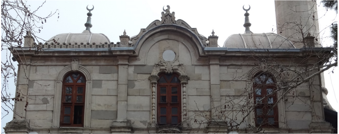
Fot. 96: Kuzey Cephe İkinci Kat Görünümü.
