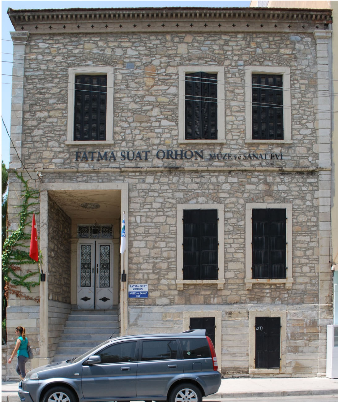
Fot. 250: Güney Cephe Görünümü.
