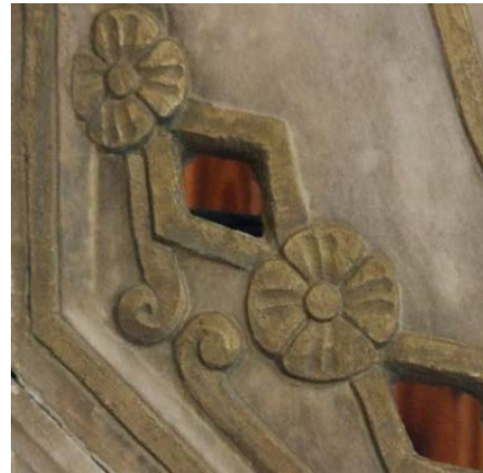
Fot. 37: Vaaz Kürsüsü Merdiven Korkuluğu.
