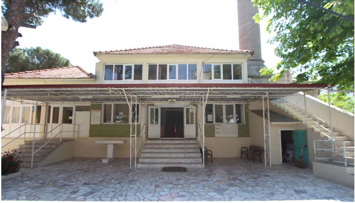
Fot. 69: Kuzey Cephe Görünüm Restorasyon Öncesi Görünümü.
