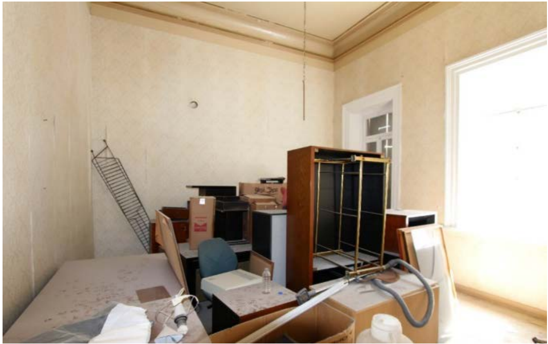
Fot. 227: Sofanın Güneyindeki Oda Görünümü.
