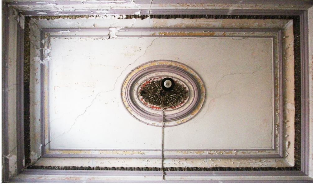
Fot. 235: Merdiven Basamakları Üzerindeki Tavan Düzenlemesi.
