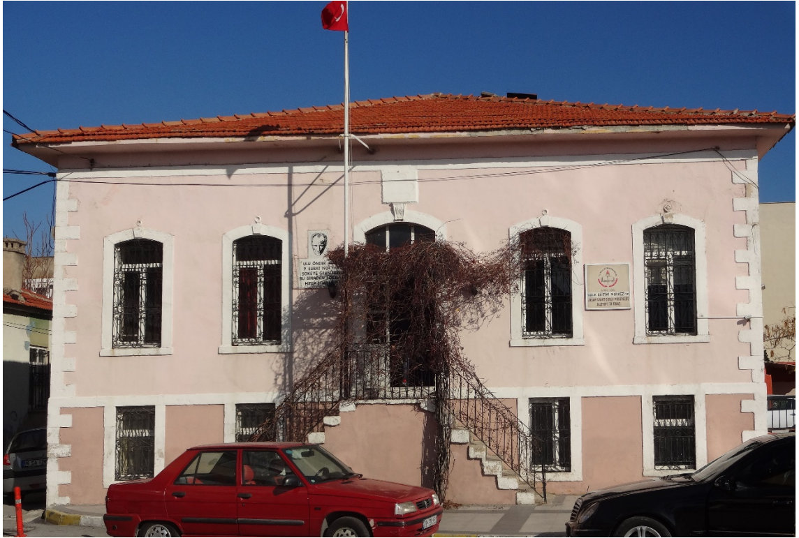
Fot. 272: Batı Cephe Görünümü.
