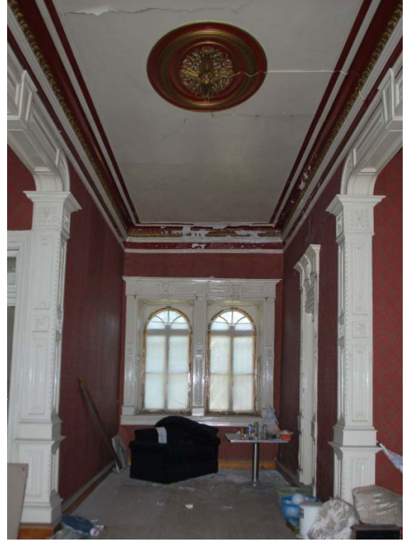
Fot. 225: Sofa Kuzeydoğu Görünüm.
