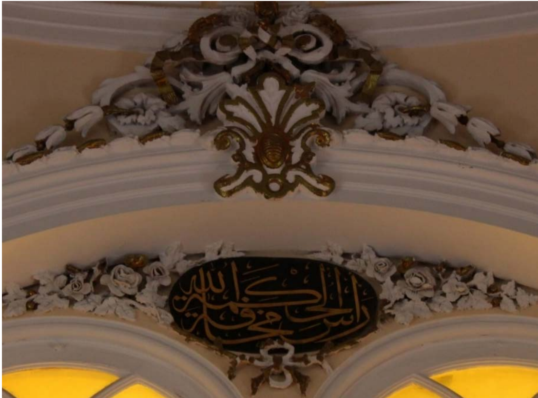
Fot. 153: Güney Cephe İkiz Pencere Üzerindeki Elips Formlu Yazı Kartuşu.
