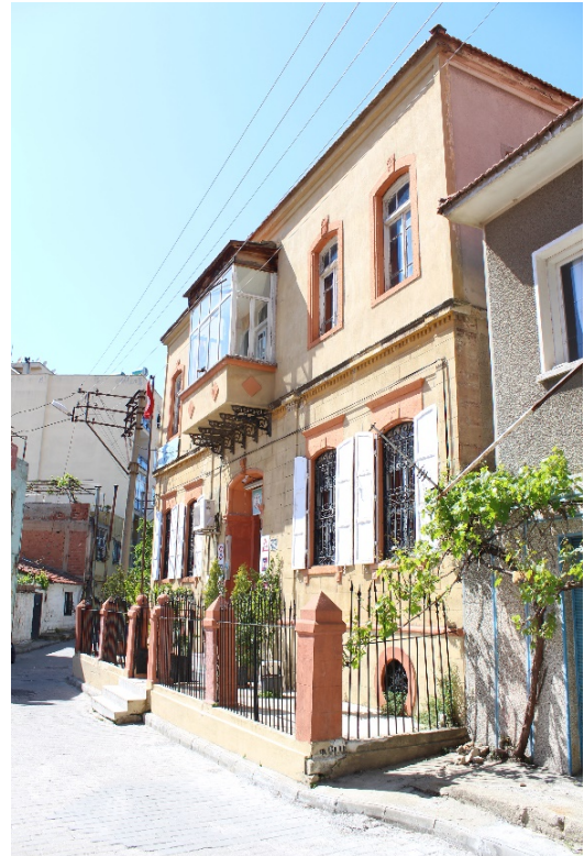
Fot. 203: Kocaöner Evi Güneydoğu Cephe.
