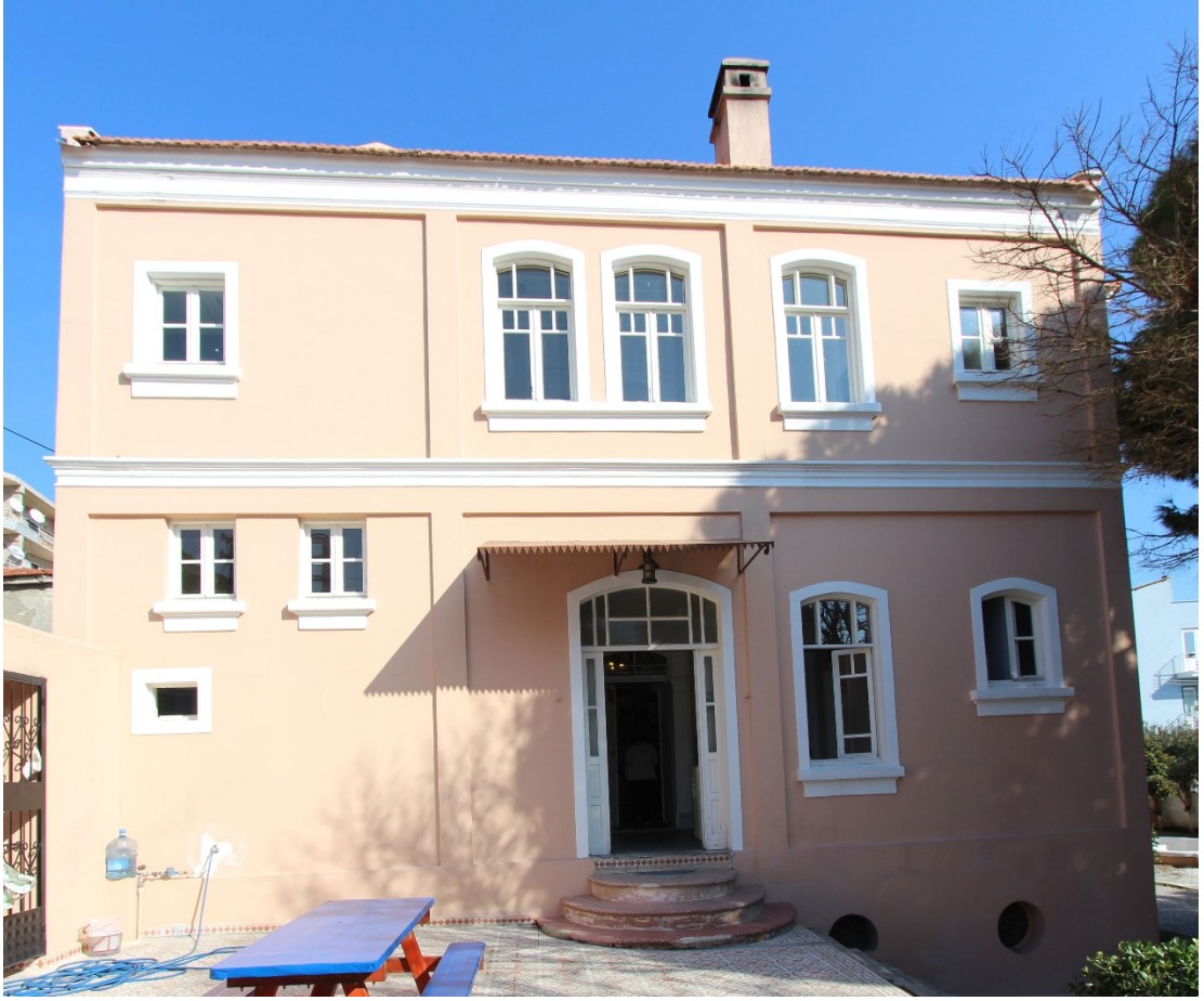
Fot. 181: Güneybatı Cephe Görünümü.
