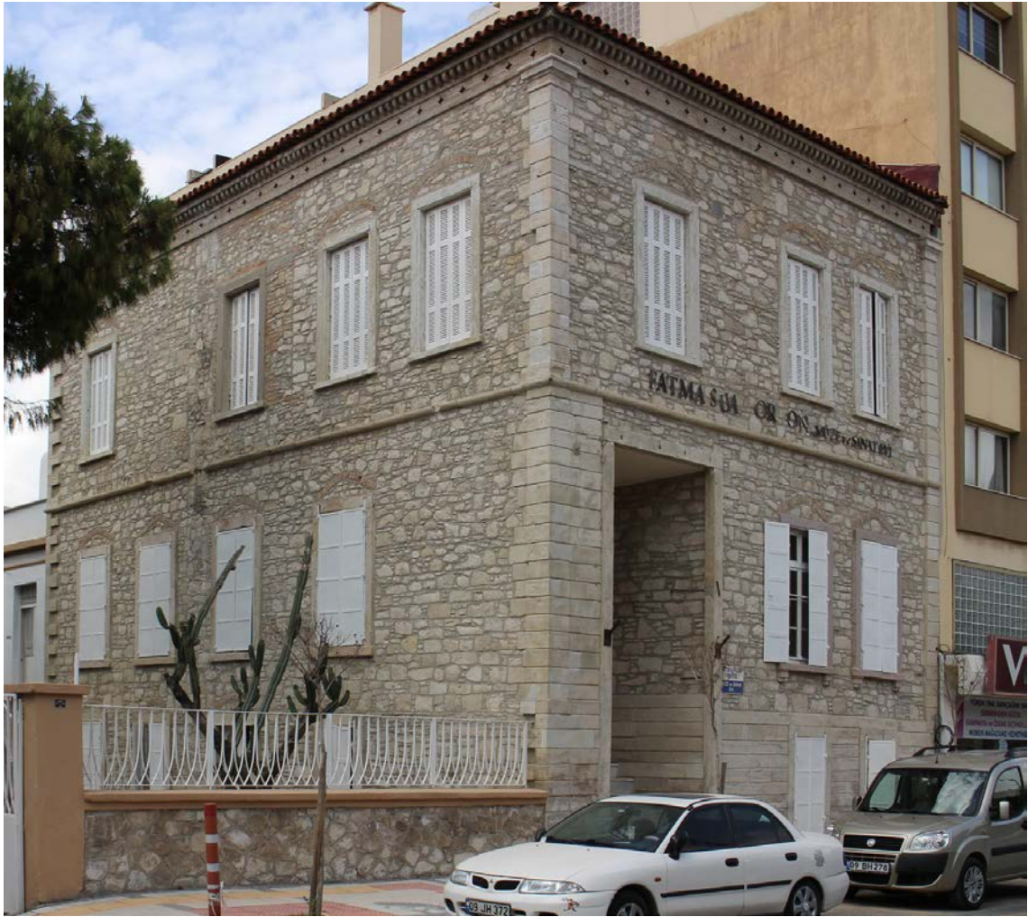
Fot. 253: Batı Cephe Görünümü.
