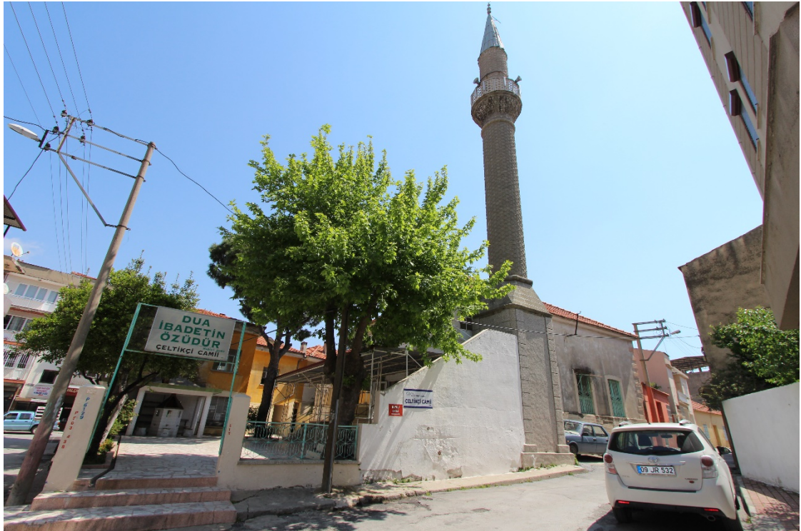
Fot. 68: Kuzeybatı Cephe Restorasyon Öncesi Görünümü.
