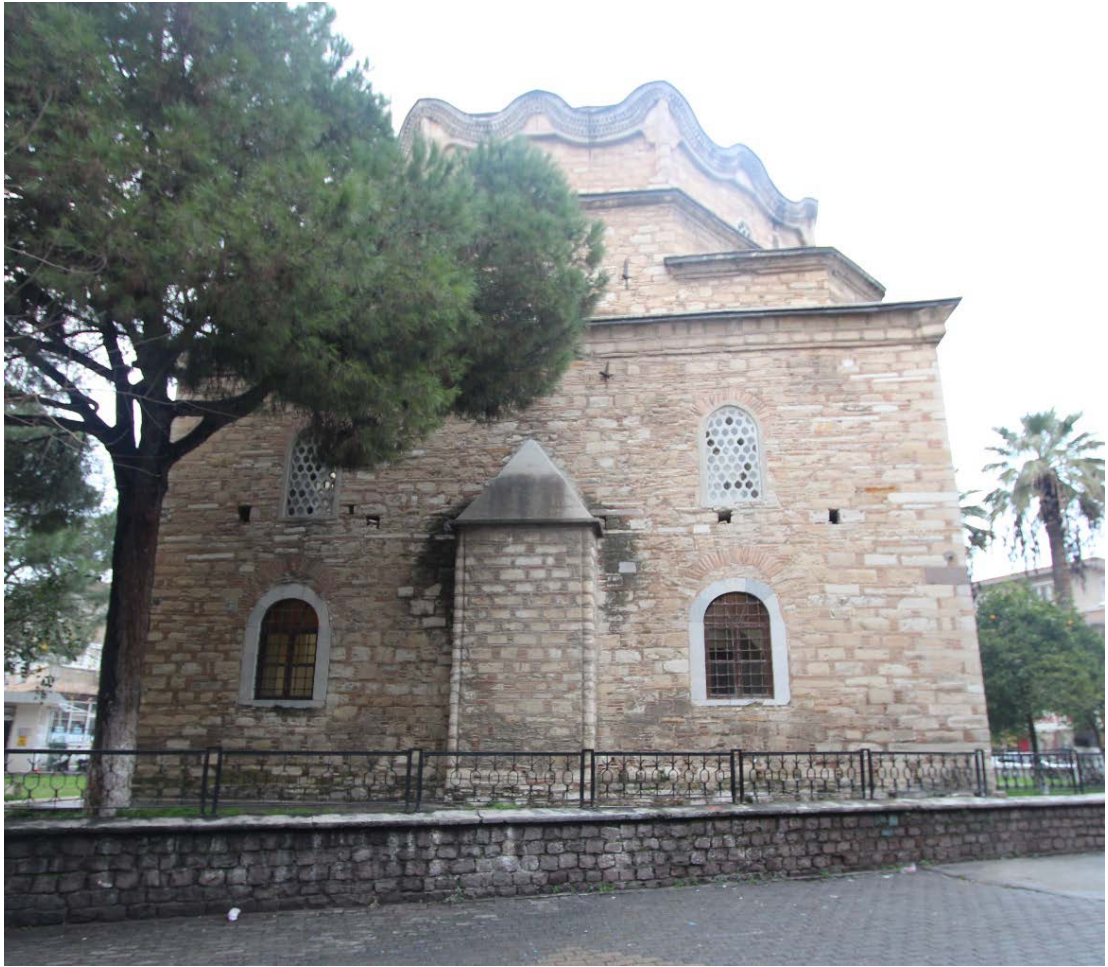
Fot. 6: Güney Cephe Görünümü.
