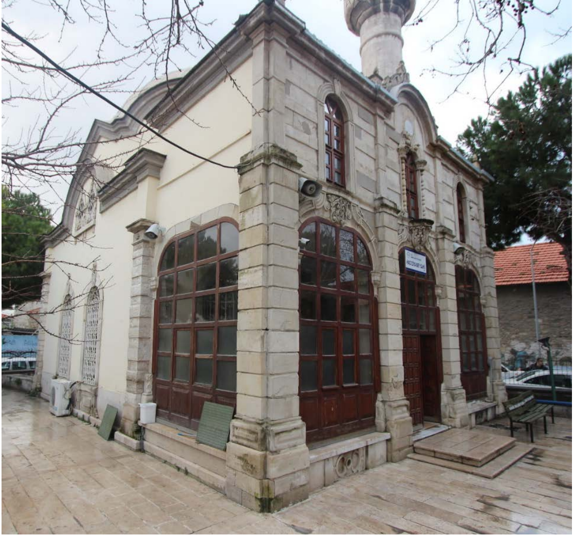
Fot. 81: Kuzeydoğu Cephe Görünümü.
