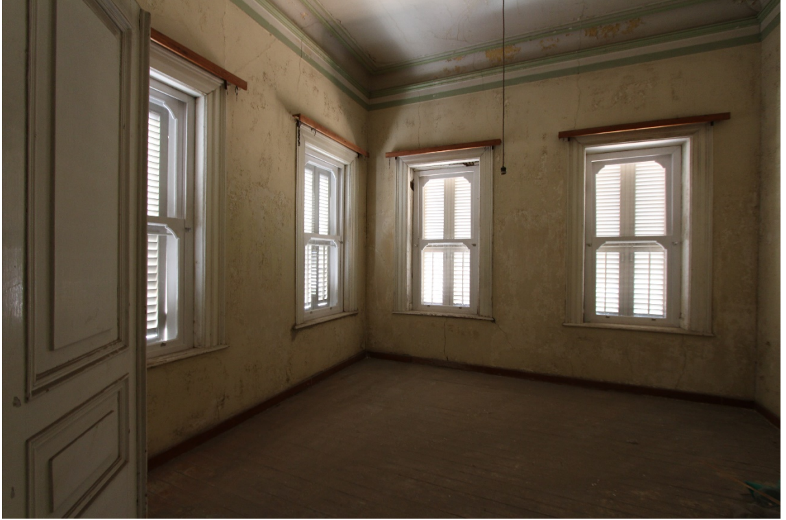
Fot. 242: İkinci Kat Batı Köşe Oda Görünüm.
