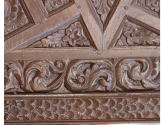
Fot. 19: Kapı Binisi Yüzeyindeki Balık Pulu Deseni Görünümü.
