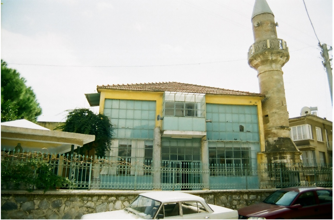
Fot. 45: Kuzey Cephe Onarım Öncesi Görünümü (VGM Arşivi).
