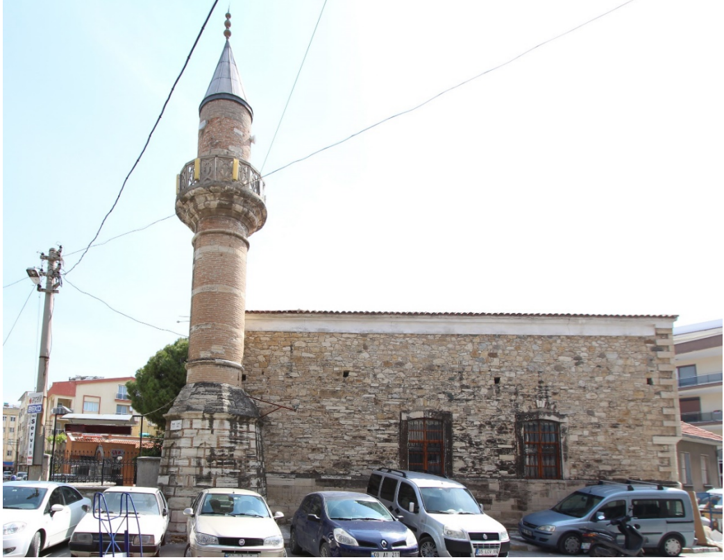
Fot. 49: Batı Cephe Görünümü.
