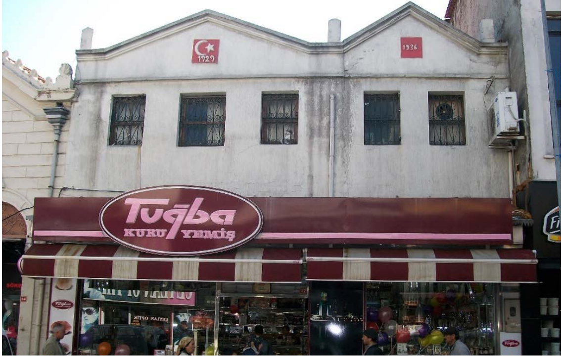
Fot. 293: Yıldız Toyran Dükkanı Kuzey Cephe Görünümü.
