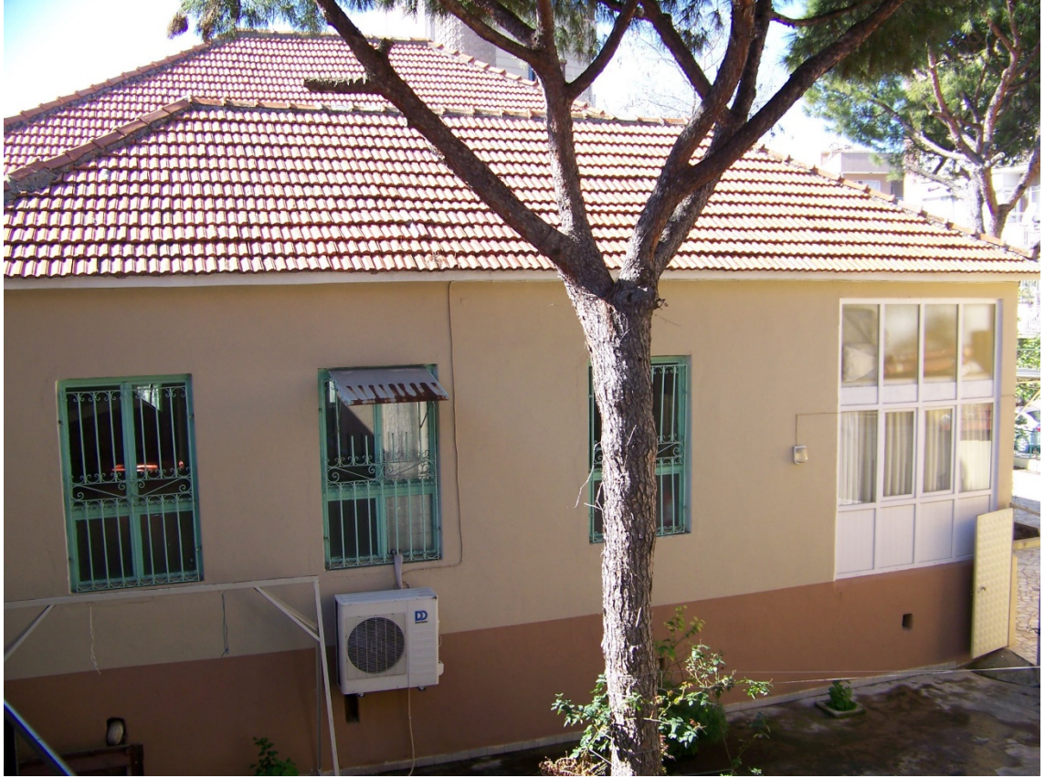
Fot. 65: Ek Mekânın Doğu Cephe Görünümü.
