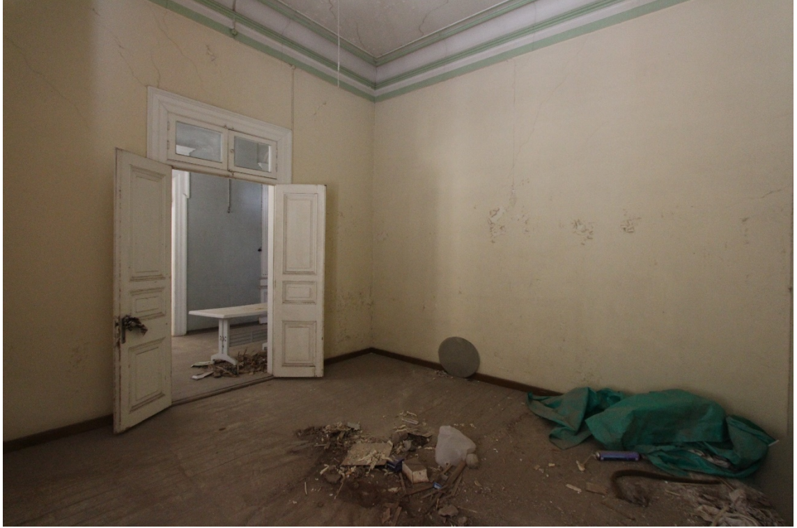
Fot. 239: İkinci Kat Güney Köşe Oda Görünümü.
