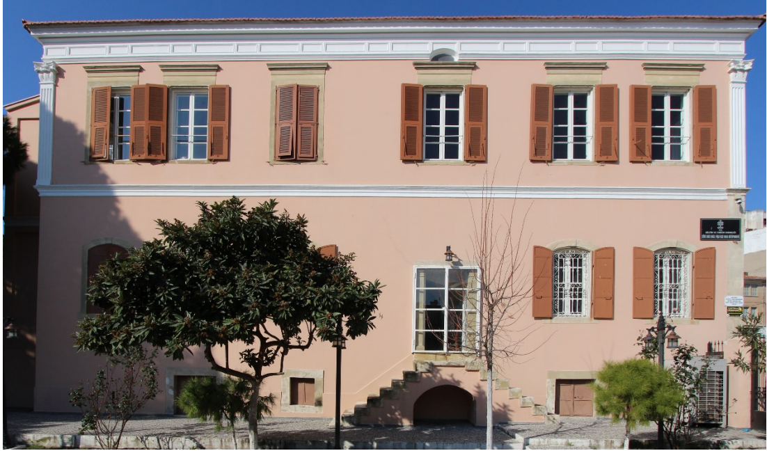
Fot. 180: Güneydoğu Cephe Görünümü.
