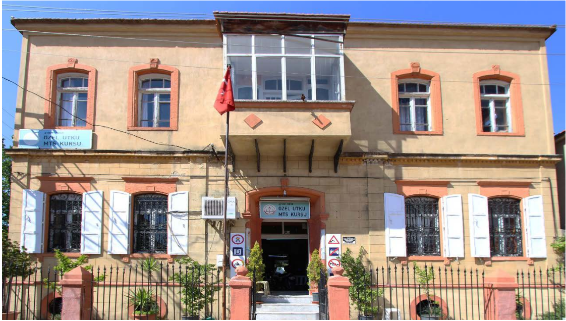
Fot. 205: Güney Cephe Görünümü.
