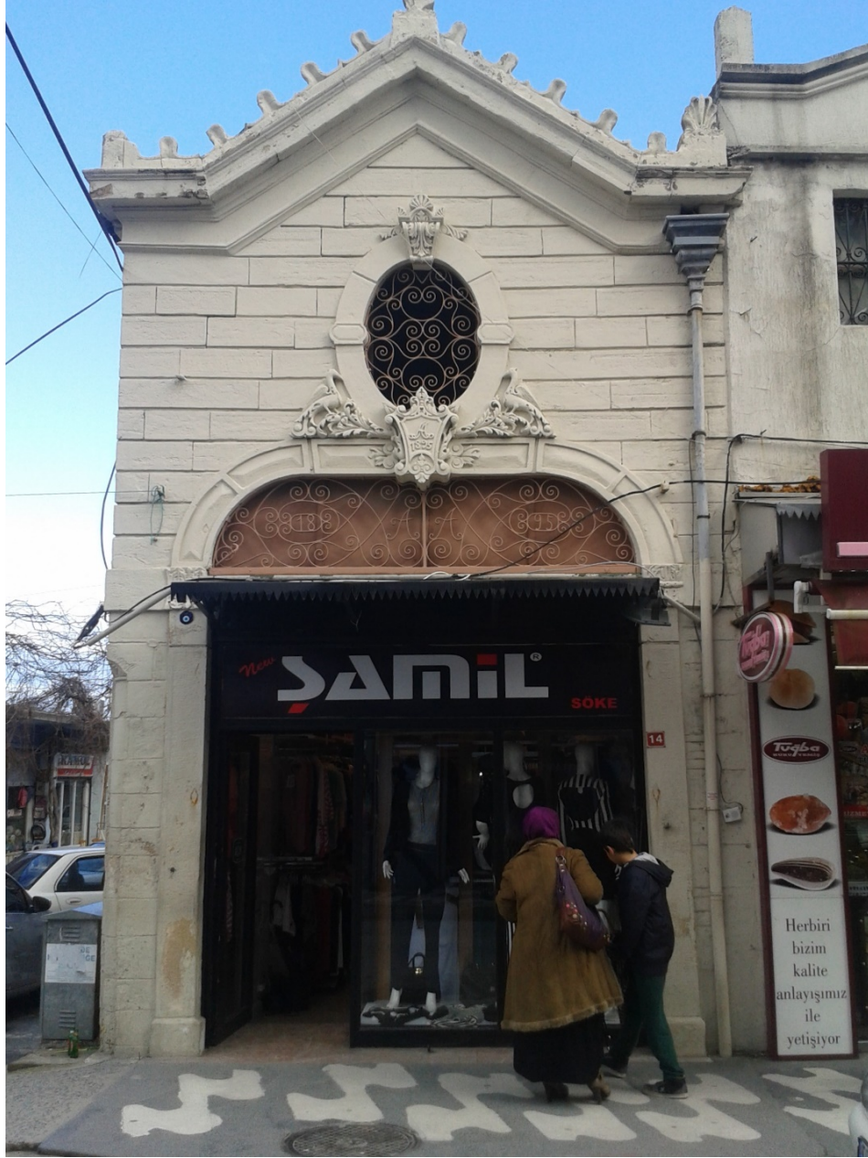
Fot. 289: Fuat Ersoy Kâgir Dükkânı Kuzey Cephe.
