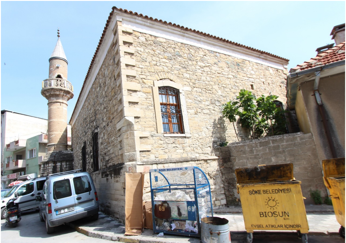
Fot. 48: Güneydoğu Cephe Görünümü.
