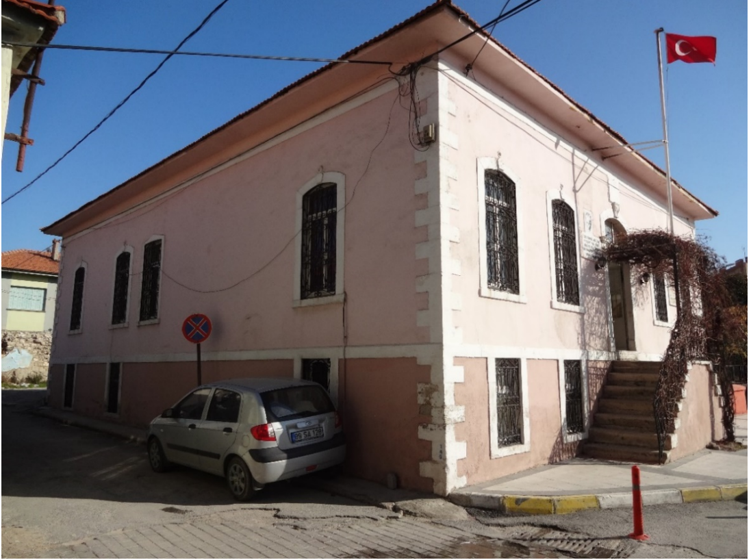
Fot. 266: Kuzeybatı ve Batı Cephe Görünümü
