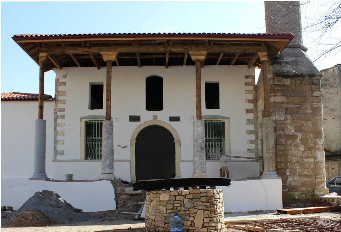
Fot. 70: Kuzey Cephe Görünüm Restorasyon Sonrası Görünümü.
