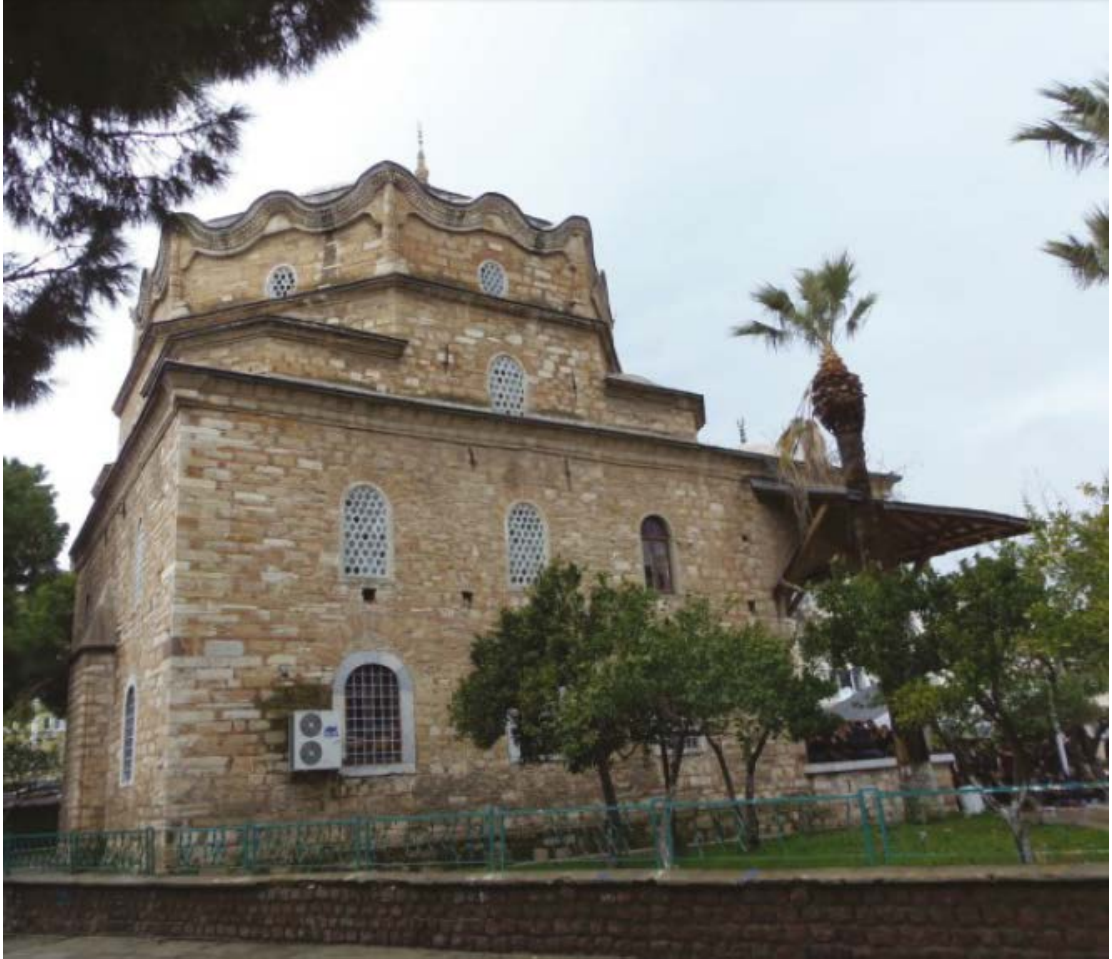
Fot. 5: Doğu Cephe Görünümü (Aydın Kültür Envanteri).
