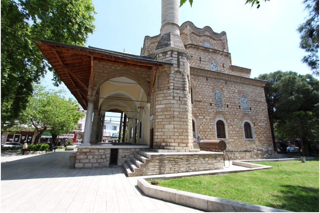
Fot. 7: Batı Cephe Görünümü.
