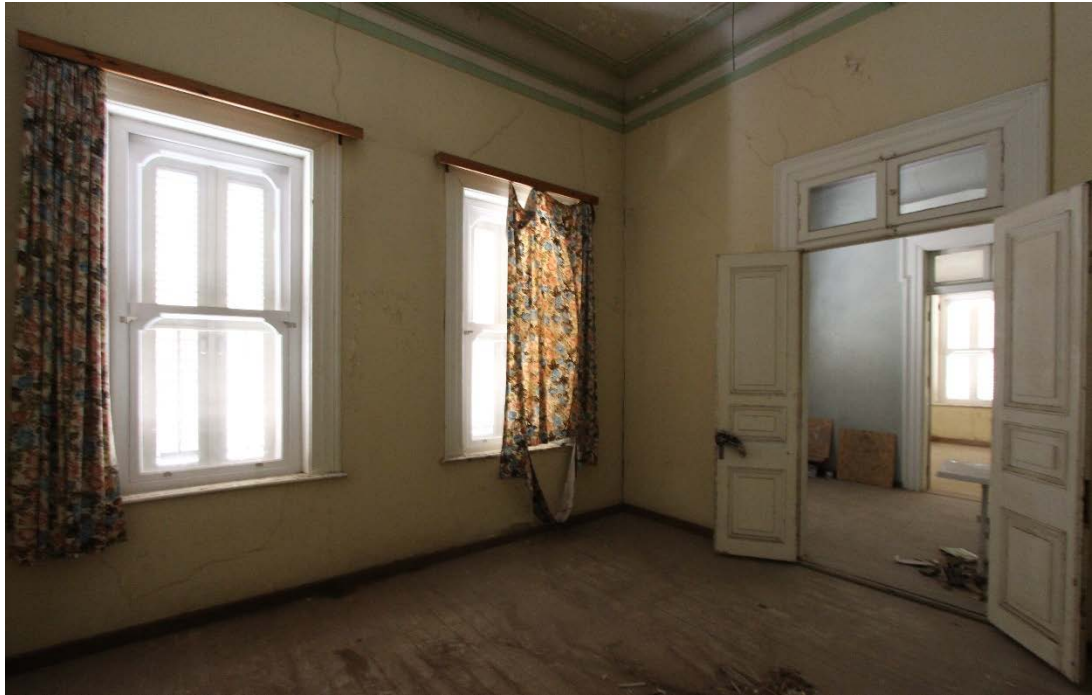
Fot. 238: İkinci Kat Güney Köşe Oda Görünümü.
