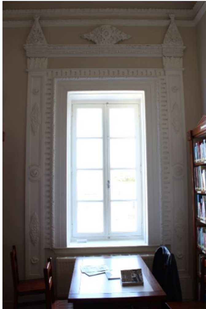
Fot. 201: Güney Cephe Pencere Görünümü.
