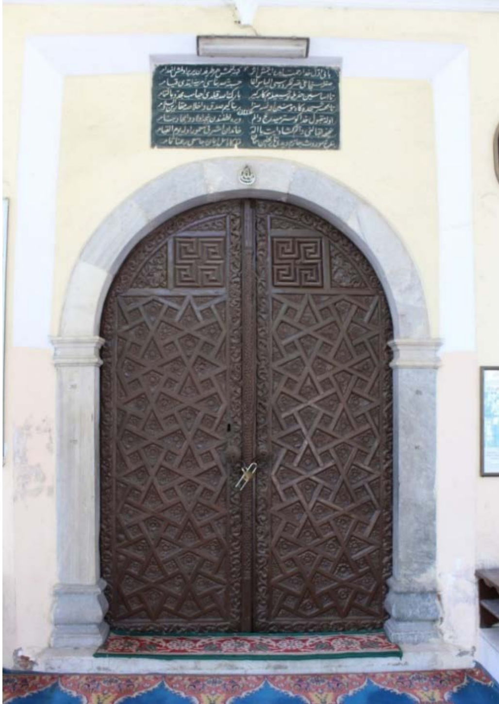
Fot. 15: Taçkapı Görünümü.
