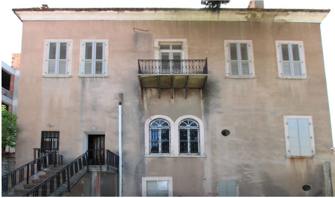
Fot. 221: Kuzeydoğu Cephe Görünümü.
