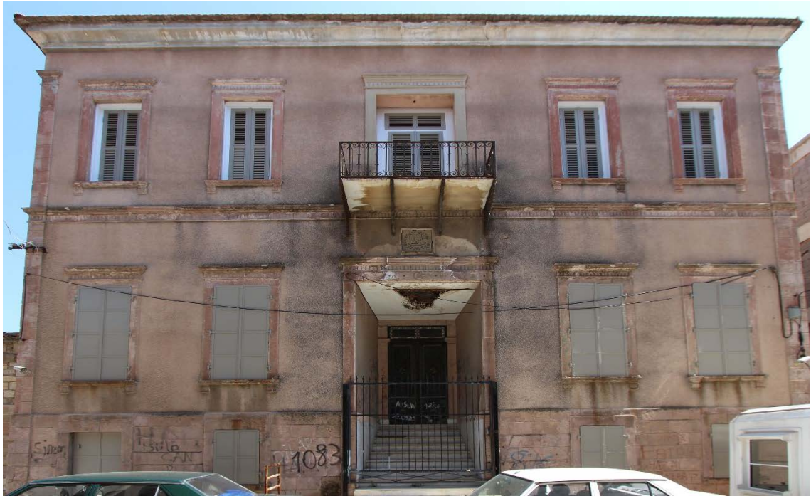
Fot. 223: Güneybatı Cephe Görünümü.
