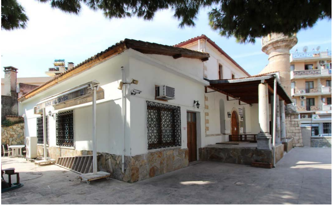
Fot. 47: Kuzeydoğu Cephe Görünümü.
