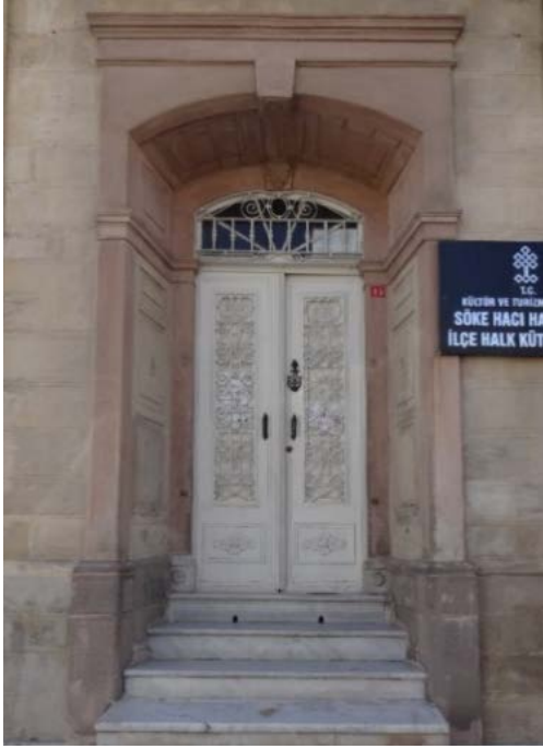
Fot 187: Kuzeydoğu Kapı Açıklığı.
