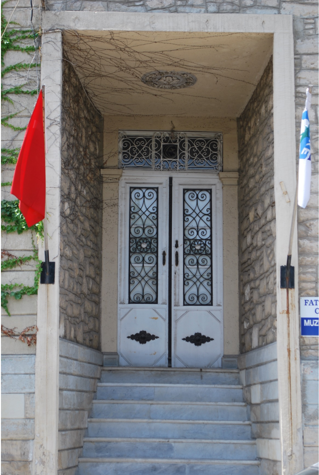
Fot. 251: Güney Cephe Niş Şeklindeki Kapı Açıklığı.
