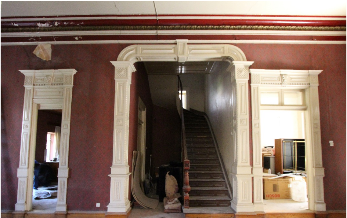
Fot. 226: Birinci Kat Sofa Güneydoğu Görünümü.
