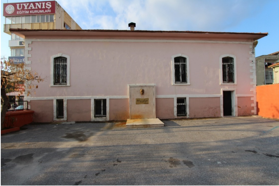
Fot. 270: Güney Cephe Görünümü.
