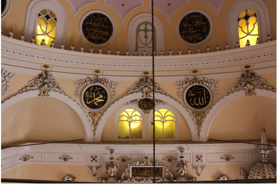
Fot. 152: Güney Cephe Kubbe Geçiş Öğeleri.
