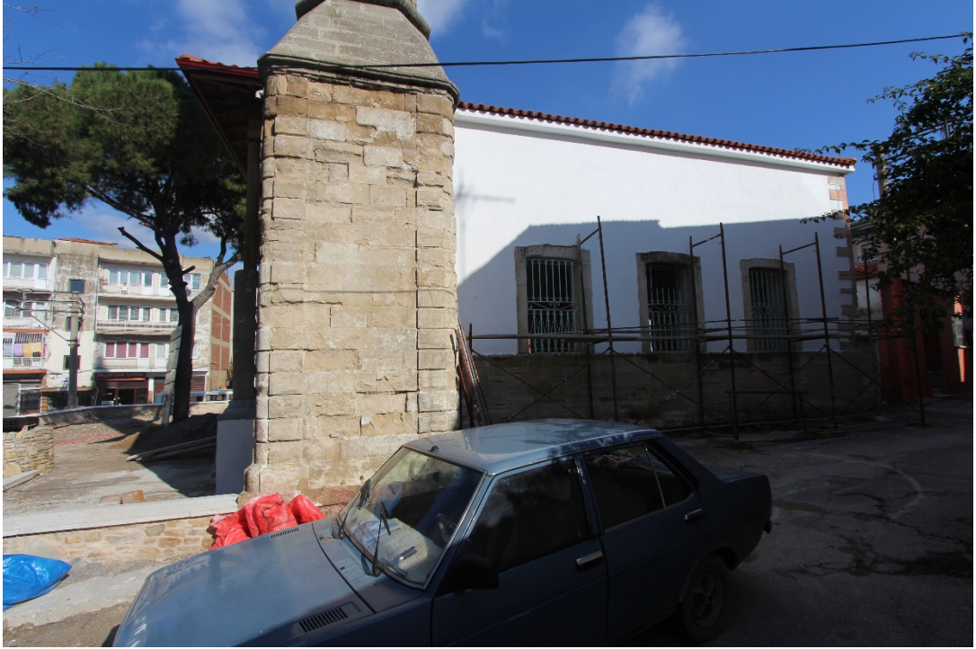
Fot. 67: Batı Cephe Görünüm Restorasyon Sonrası Görünümü.
