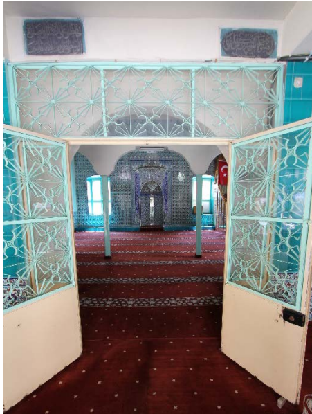
Fot. 60: Kapı Açıklığı Restorasyon Öncesi Görünümü.
