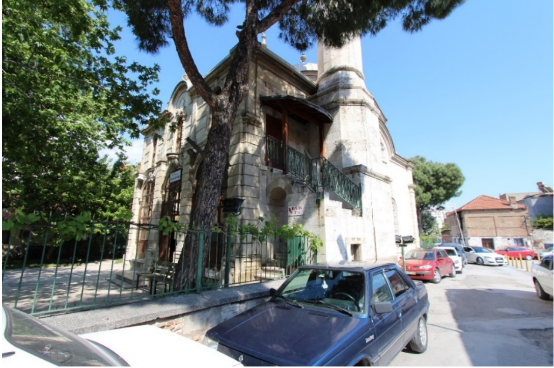
Fot. 91: Kuzeybatı Cephe Grnm.
