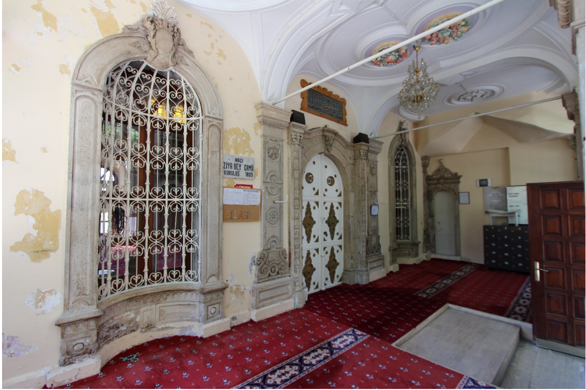
Fot. 102: Son Cemaat Yeri Güneybatı Cephe Görünümü.
