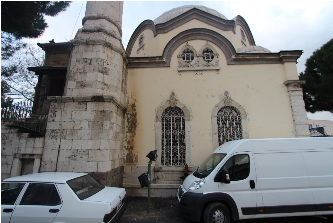
Fot. 90: Batı Cephe Görünümü.
