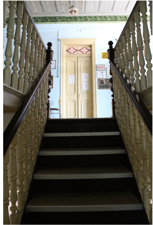
Fot. 209: İkinci Kat Merdiven Basamakları.
