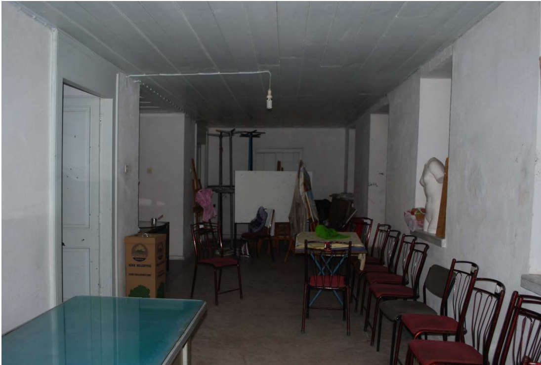
Fot. 256: Bodrum Kat Güney Cephe Görünümü.
