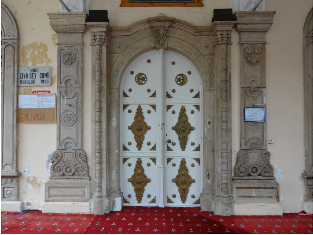
Fot. 116: Taçkapı Görünümü.
