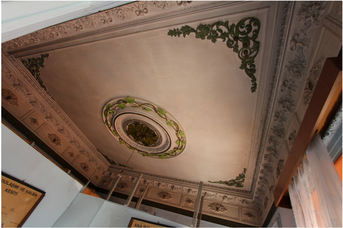
Fot. 217: Sofanın Güneydoğusundaki Başodanın Çökertme Tavan Görünümü.
