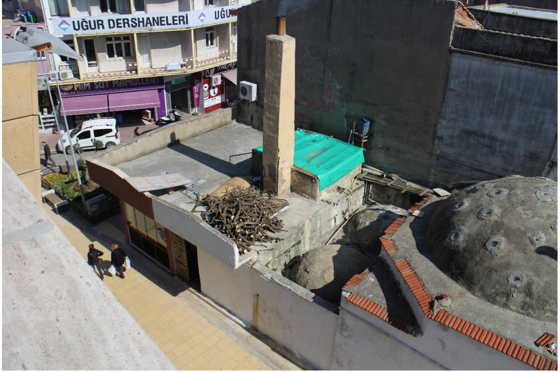
Fot. 265: Külhan Bölümünden Görünümü.
