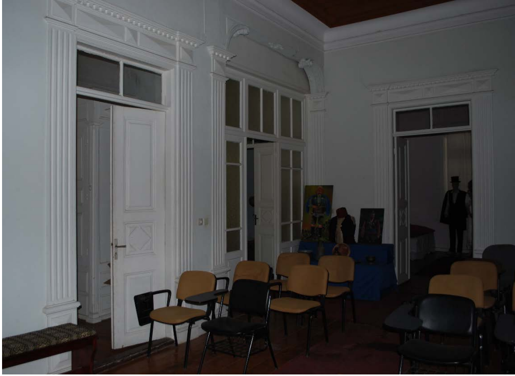
Fot. 257: Birinci Kat Sofa Güney Cephe Görünümü.
