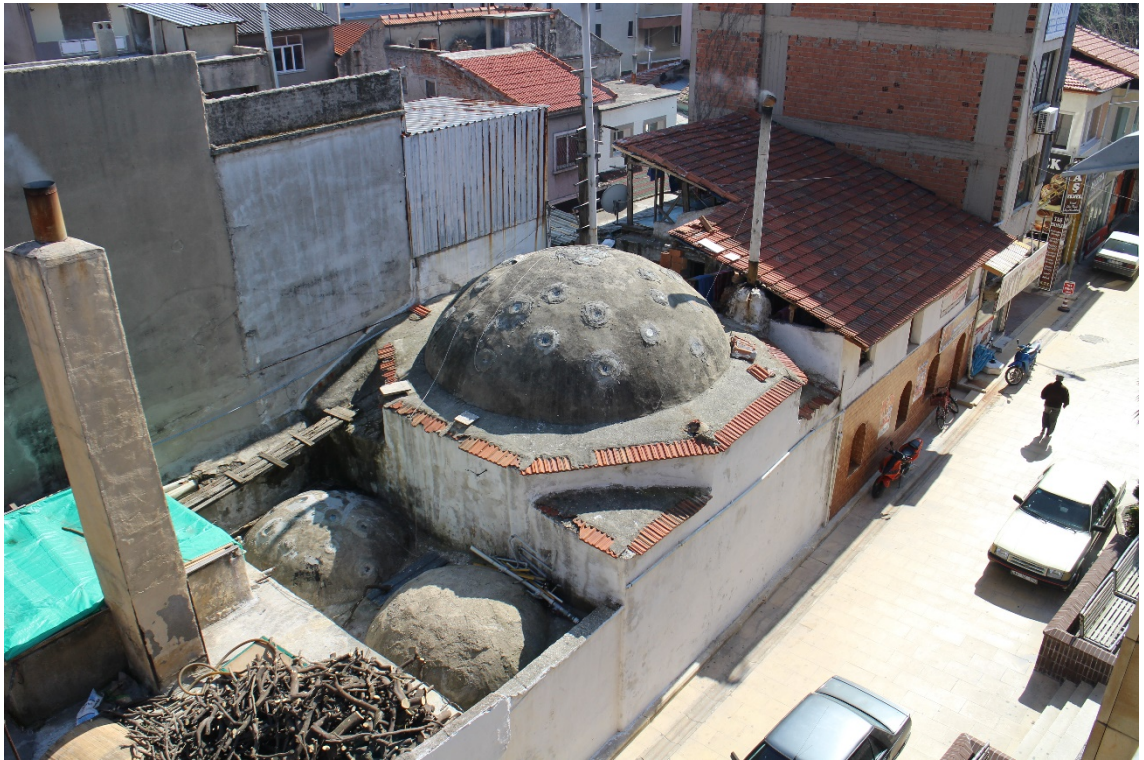
Fot. 260: Kuzeydoğu Cephe Örtü Sistemi Görünümü.
