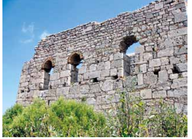
Res. 6 Çatıya kadar korunagelmış yapının pencere sistemi Fig. 6 Window system of the building standing to roof level
