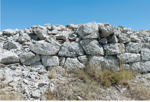
Res. 2 Kuzey Surları, Kuzey Cephe
