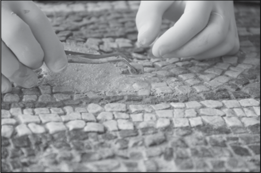
Resim 7: Erikli Kilise, Orta Nef kuzeybatı köşesi, tessera harç yatağı yenileme uygulaması.
