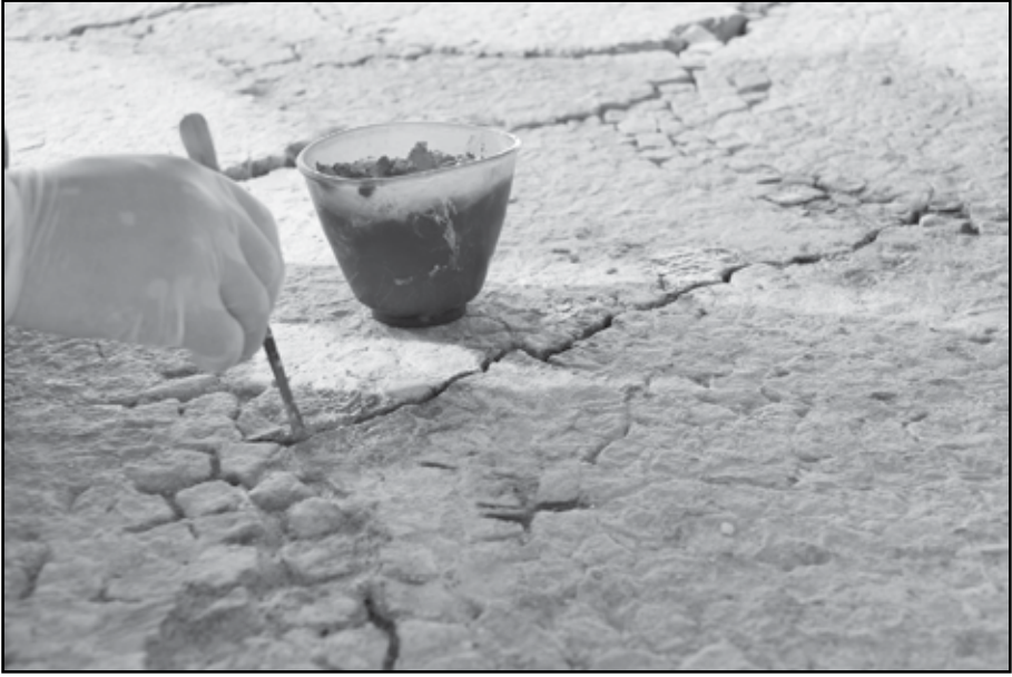
Resim 8: Dođu Portik taban mozaiđı, 2 numaralı panel, atlak dolgu uygulaması.
