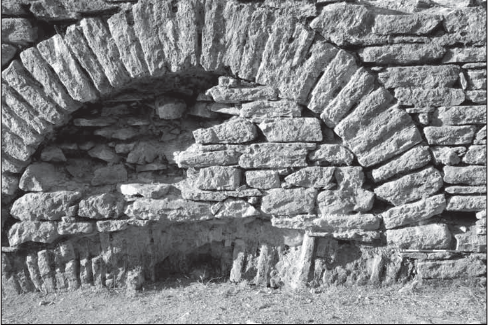
Resim 6: Hamamdaki kemerli geiř.
