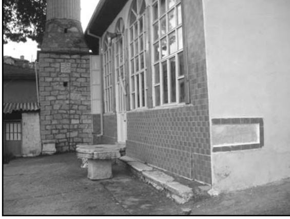
Resim 4: Cami önünde ve duvarlarındaki mimari bloklar
