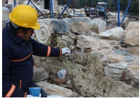
Resim 10: Derzleme ve Sağlama Çalışmaları
