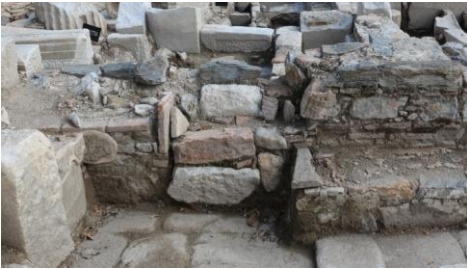
Resim 11: Narteks Duvarı, Uygulama Çalışmaları Öncesi
