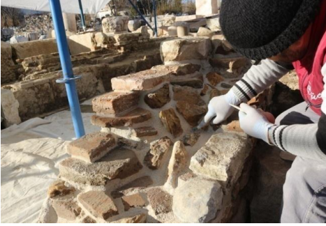
Resim 9: Derzleme ve Sağlama Çalışmaları
