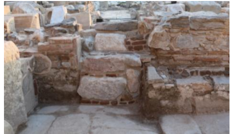
Resim 12: Narteks Duvarı, Uygulama Çalışmaları Sonrası
